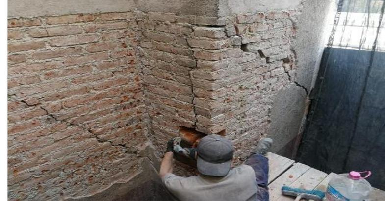
CONSOLIDACIÓN DE MUROS DE TABIQUE A TRAVÉS DE COSIDO DE MUROS
