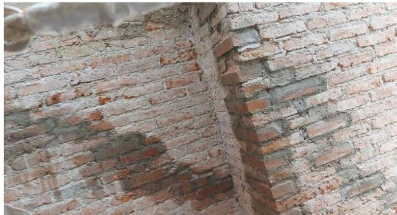
CONSOLIDACIÓN DE MUROS DE TABIQUE A TRAVÉS DE COSIDO DE MUROS
