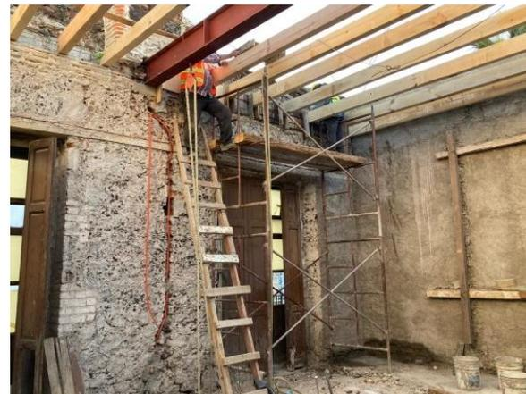
REINTEGRACIÓN DE VIGAS PARA RECIBIR LOSA DE AZOTEA
