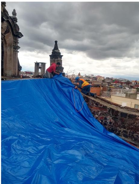
Colocación de lonas para evitar filtraciones.
