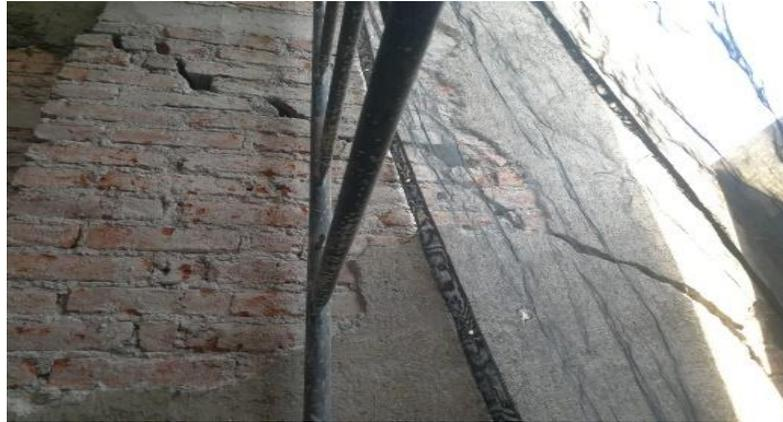
RETIRO DE APLANADO PARA DETERMINAR EL GRADO DE DAÑO
