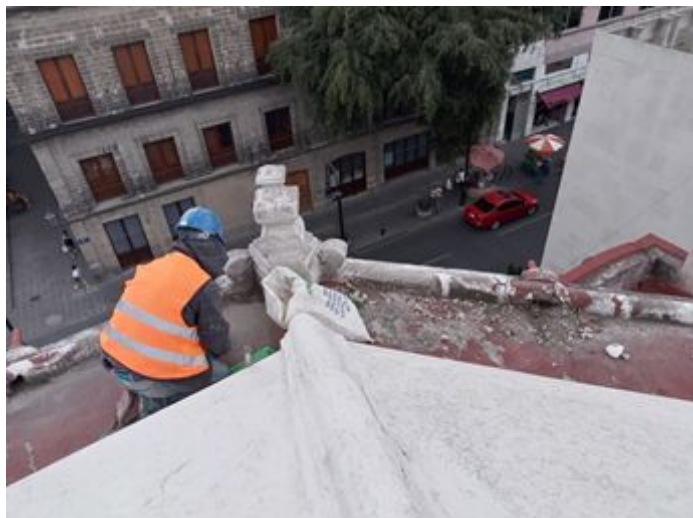
Limpieza de bajadas pluviales
