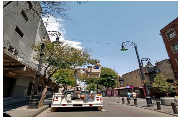
Reparación de circuito en República de Cuba. Quedan funcionando 16 luminarias
