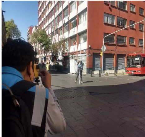
VERIFICACIÓN TOPOGRÁFICA DE LOS NIVELES DE LA TUBERÍA DE DRENAJE.
