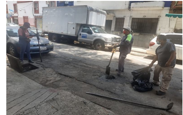
Se realiza dezasolve en la calle Marqués Sterling
