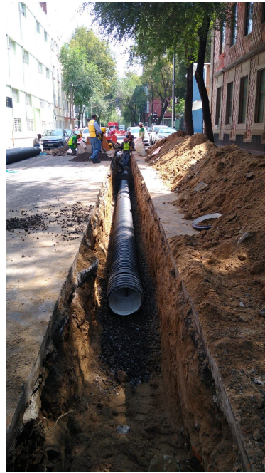
INSTALACIÓN DE TUBERÍA DE DRENAJE
