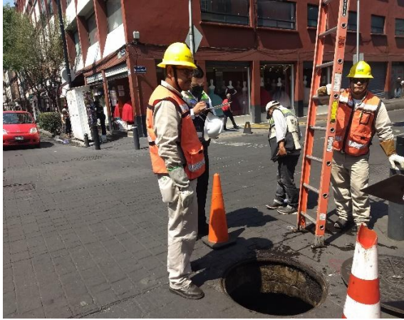
RECORRIDO CON PERSONAL DE CFE, PARA VERIFICAR FÍSICAMENTE SU INFRAESTRUCTURA
