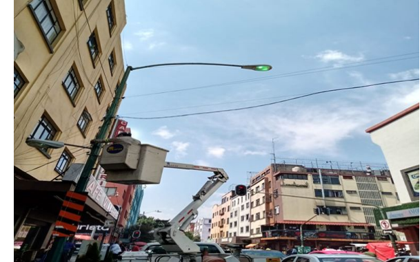
Reparación de circuito en la calle San Miguel, de Fray Servando a San Pablo, quedan funcionando 8 luminarias
