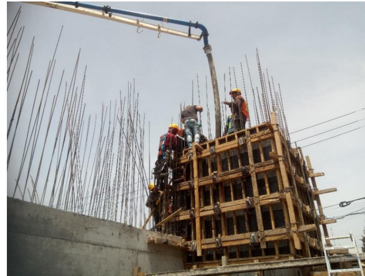
COLADO CON CONCRETO PREMEZCLADO F´C=250KG/CM2 PARA CUBO DE ELEVADOR PRIMER NIVEL (EJE B/1-6)
