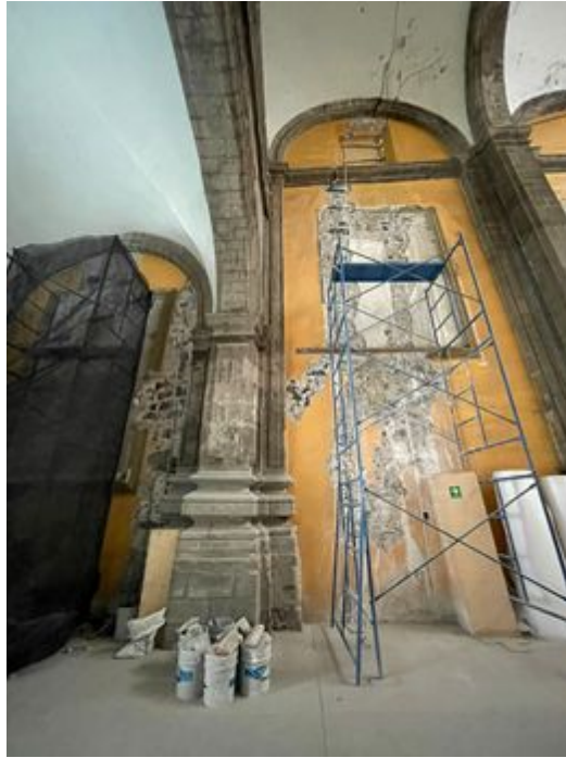
Consolidación de grietas en interiores del templo.
