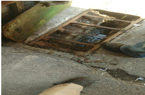
Se realiza dezasolve en la calle de República de Perú # 23. Se limpian 2 coladeras y se sondean 4 mts de drenaje
