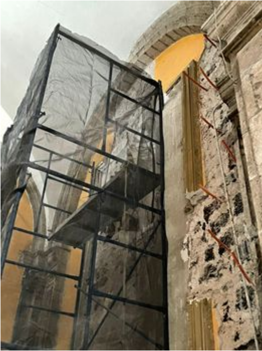
Consolidación de grietas en interiores del templo.
