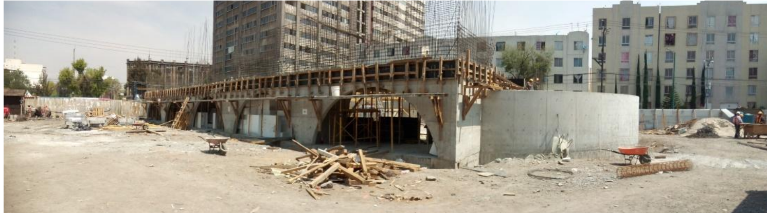
VISTA PANORAMICA NORESTE
