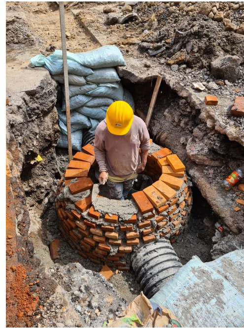
CONSTRUCCIÓN DE POZOS DE VISITA
