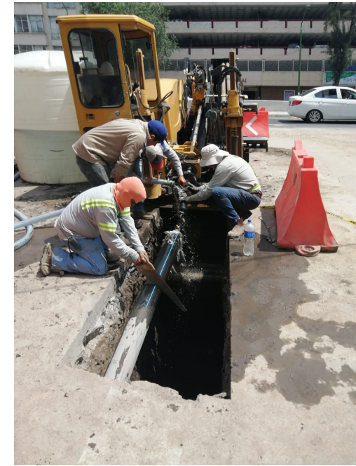
INSTALACIÓN DE TUBERÍA DE AGUA POTABLE POR EL MÉTODO DE PERFORACIÓN DIRIGIDA
