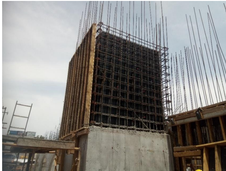
COLOCACION DE CIMBRA DE MADERA Y ARMADO CON ACERO DE REFUERZO PARA CUBO DE ELEVADOR PRIMER NIVEL (EJE B/1-6)
