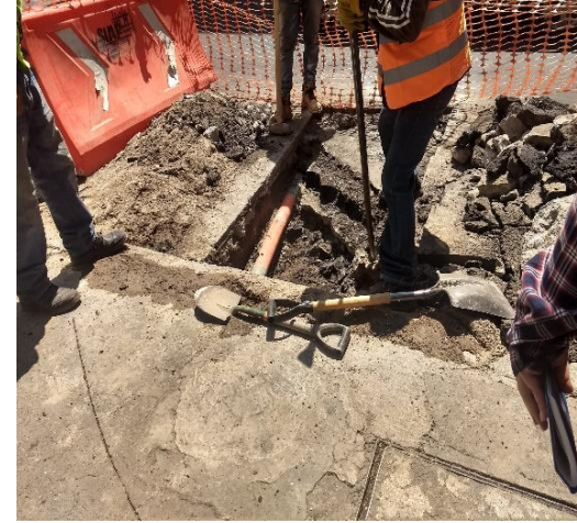
CALA PARA VERIFICAR LA TRAYECTORIA DE LA TUBERÍA DE AGUA POTABLE
