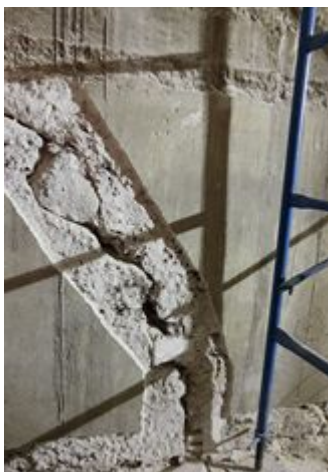
Exploración de grietas en muro interno de fachada principal.
