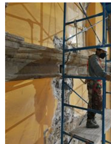
Inyecciones en muro sur del templo.
