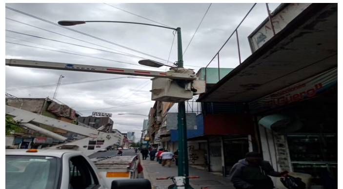
Se repara 1 circuito en Artículo 123. Quedan funcionando 10 Luminarias.
