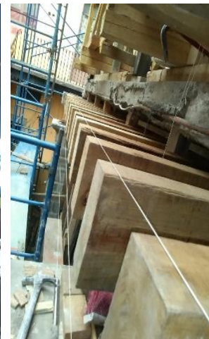
NIVELACIÓN DE VIGAS DE PASILLO.
