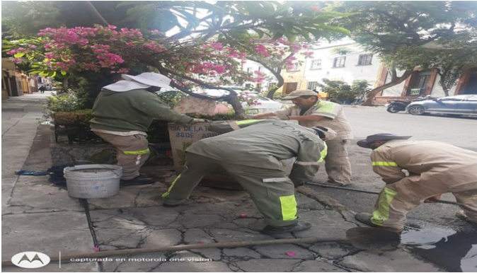
Se realizó desazolve en Berriozabal No. 24. Se limpian 3 coladeras y se sondean 7 mts. de drenaje.
