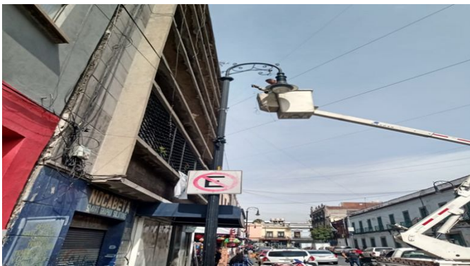
Se repara 1 circuito en República de Bolivia No. 7. Quedan funcionando 7 Luminarias.
