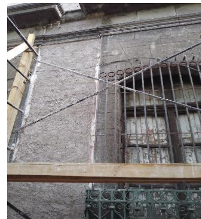
REINTEGRACIÓN DE APLANADOS (ZARPEADO) EN FACHADA
