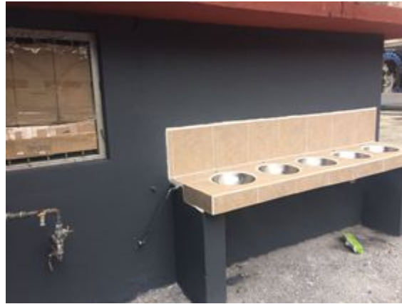
Proceso de reemplazo de acabado cerámico en zonas de bebederos.
