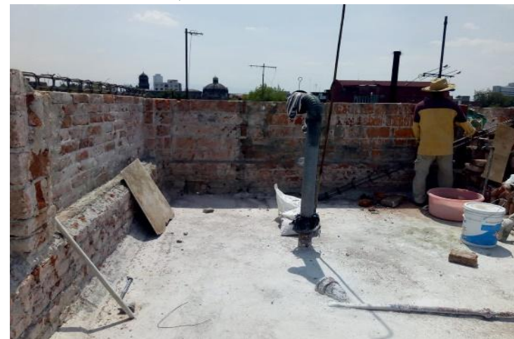
LIBERACIÓN DE APLANADOS Y COLOCACIÓN DE CADENA PERIMETRAL DE AMARRE
