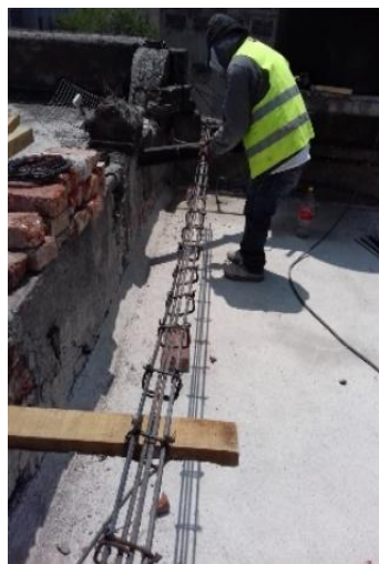
HABILITADO DE CADENA DE CERRAMIENTO EN MUROS DE AZOTEA
