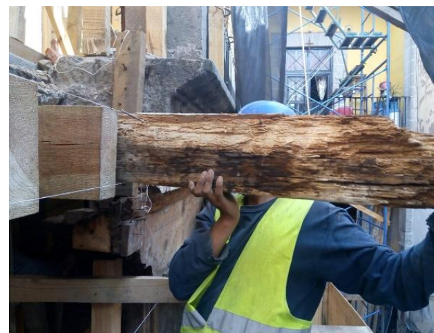
SUSTITUCIÓN DE VIGAS EN PASILLO.
