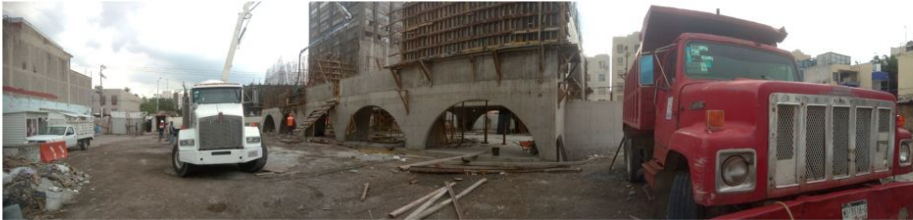
VISTA PANORAMICA NORESTE
