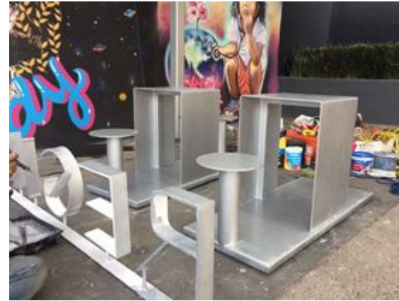
Rehabilitación de bancas y mesas.
