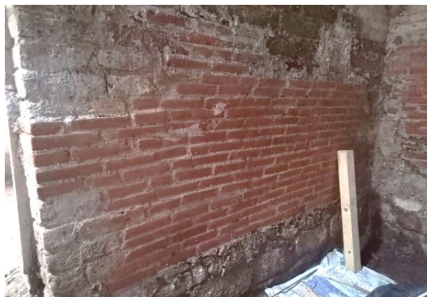
CONSOLIDACION DE MUROS DE UNA 3er. VIVIENDA
