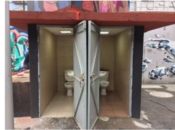
Atención a filtraciones en losa de sanitarios.
