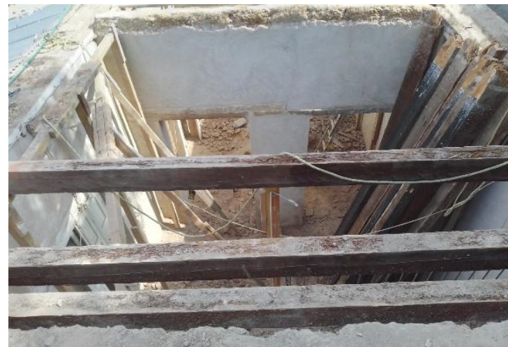
RETIRO DE CUBIERTAS EN 2DA. VIVIENDA
