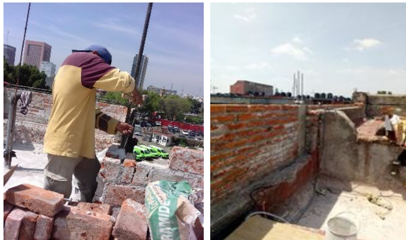
LIBERACIÓN DE MURO DE LADRILLO CON UN DESPLOME
