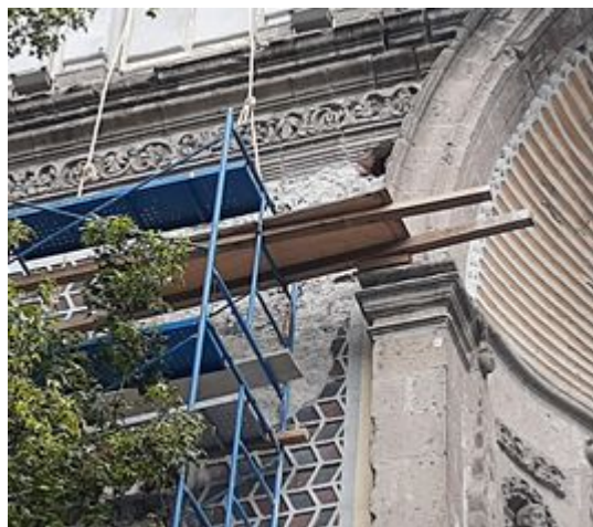
Exploración de grietas en torre campanario
