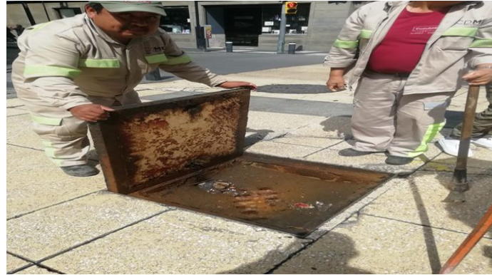
Se realizó desazolve en la calle Madero No. 70. Se limpian 4 rejillas y se sondean 12 mts. de drenaje
