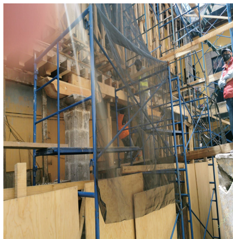
REINTEGRACIÓN DE COLUMNAS DE CANTERA
