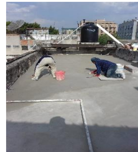
REINTEGRACIÓN DE ENTORTADOS CON PENDIENTE DEL 2%
