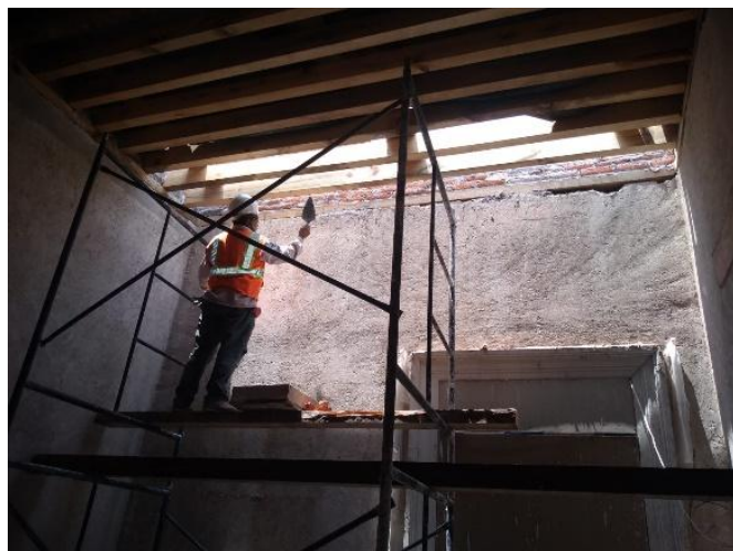
ENRASE DE MUROS, ELABORACIÓN DE MECHINALES, REINTEGRACIÓN VIGAS
