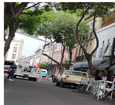
Se realizó reparación de comonfort, se dejó 1 circuito y 14 luminarias funcionando
