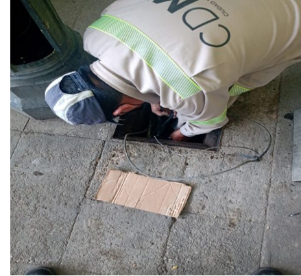
Se realizó reparación de Mariana R. del Toro de Lazarín, se dejó 1 circuito y 12 luminarias funcionando
