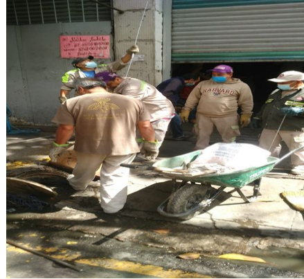
Se realizó desazolve en Peña y Peña No. 29, se limpian 5 coladeras y se sondean 14 mts. de drenaje
