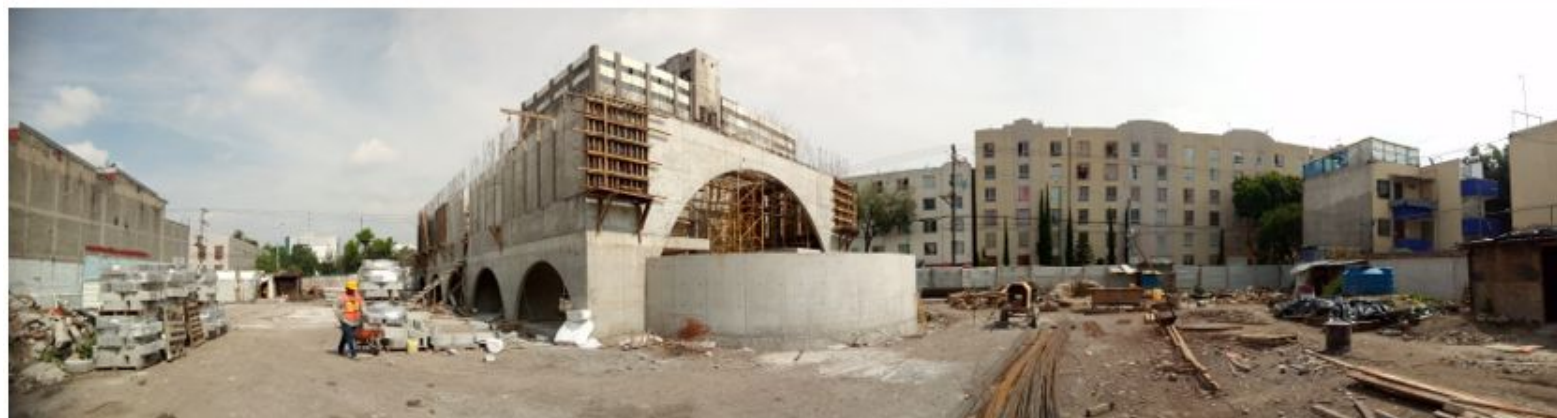
VISTA PANORAMICA NORESTE
