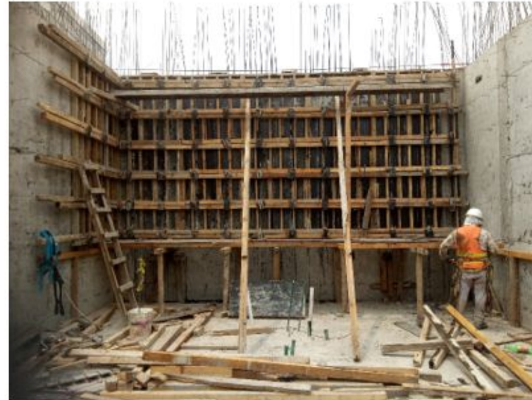
COLOCACION DE CIMBRA DE MADERA PARA MUROS Y ARCOS DEL PRIMER NIVEL (1-5/B-C)
