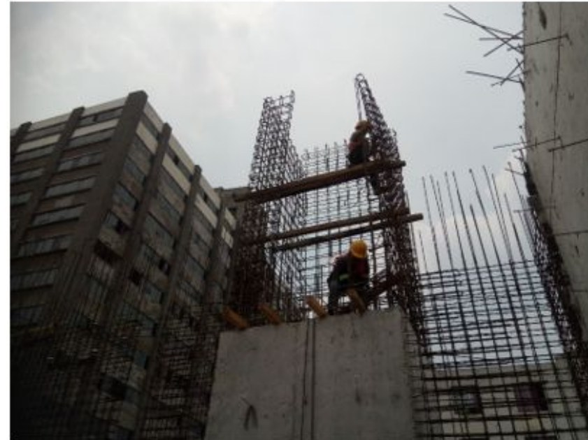
ARMADO CON ACERO DE REFUERZO PARA MUROS Y ARCOS DEL PRIMER NIVEL (1-5/B-C)
