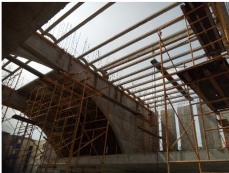
COLOCACION DE VIGUETAS Y DOVELAS PARA AZOTEA (EJES 4-6/B-C)
