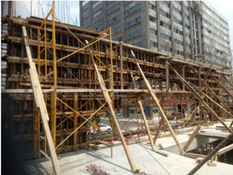
COLOCACION DE CIMBRA DE MADERA PARA MUROS Y ARCOS DEL PRIMER NIVEL (1-5/B-C)
