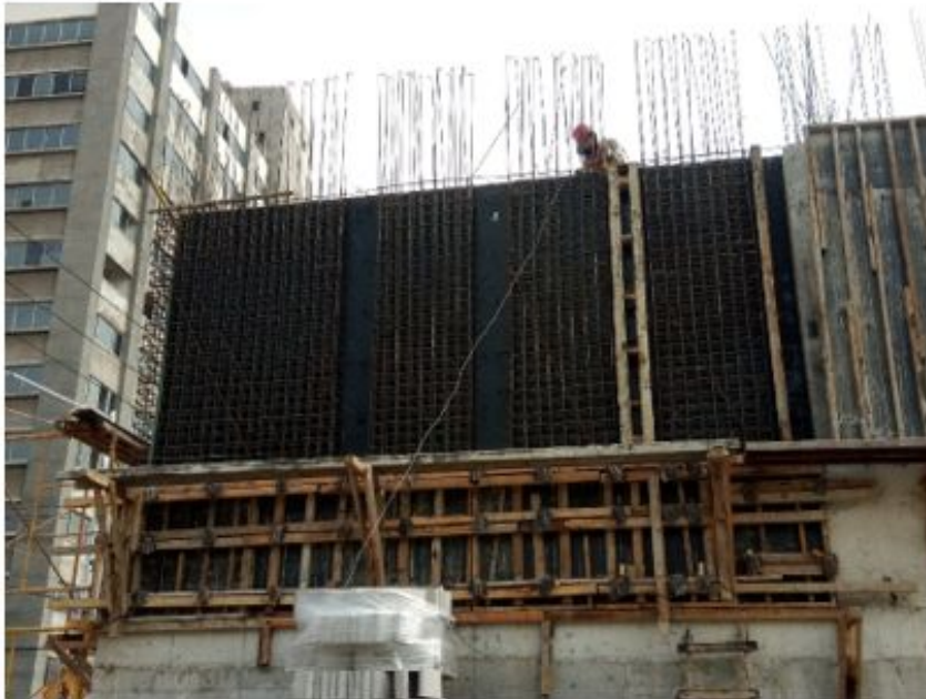
ARMADO CON ACERO DE REFUERZO PARA MUROS Y ARCOS DEL PRIMER NIVEL (1-5/B-C)
