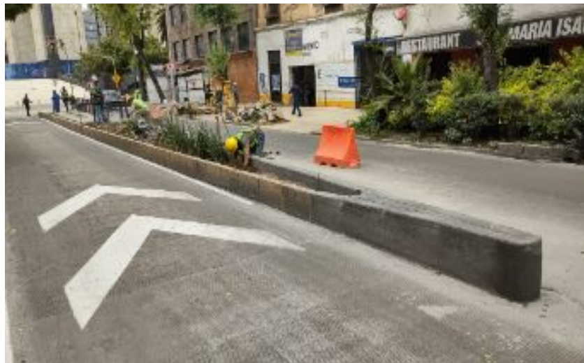
COLOCACIÓN DE ELEMENTOS DE CONFINAMIENTO
