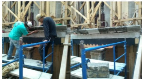
REINTEGRACIÓN DE SILLARES DE CANTERA
