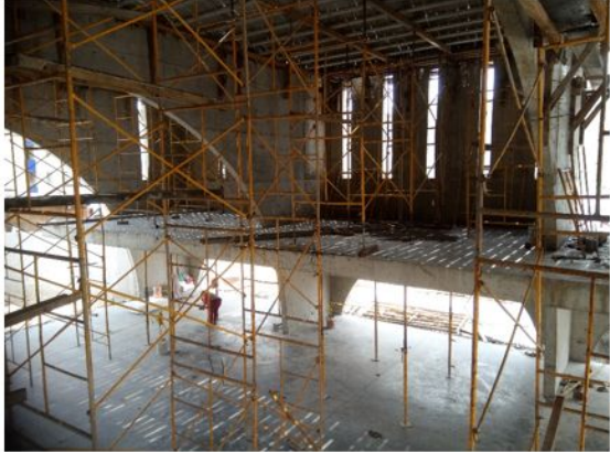
COLOCACION DE CIMBRA DE MADERA Y APUNTALAMIENTO PARA SISTEMA DE TECHUMBRE DE AZOTEA (EJES 3-6/B-C)
