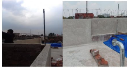
COLOCACIÓN DE CONCRETINA EN MURO COLINDANCIA PONIENTE Y APLANADOS EN PETRIL.
