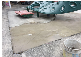
Rehabilitación de firmes para colocación de piso de hule en zonas de juegos infantiles.
