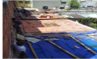
REINTEGRACIÓN DE LADRILLOS EN AZOTEA
