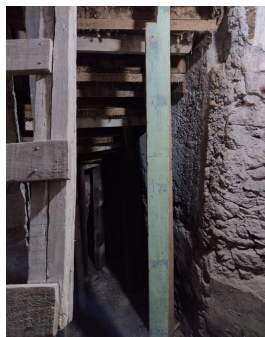
Retiro de relleno de 40 cm debajo de escalones de madera en arranque de escalera en torre campanario.
