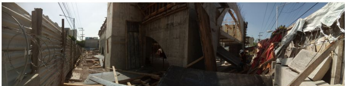
VISTA PANORAMICA SUOESTE
