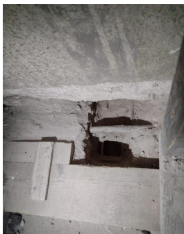
Calas en entresuelo del Coro. Se encontró losa de concreto doblemente armada de entre 19 y 23 cms de espesor.
