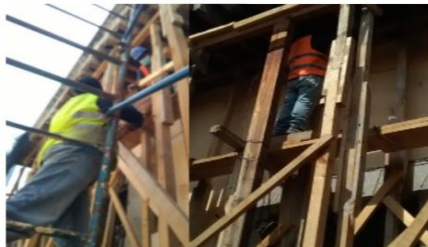
APLICACIÓN DE TRATAMIENTO ANTI INSECTOS XILÓFAGOS A LAS VIGAS
