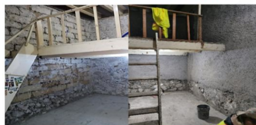
RETIRO DE APLANADOS SIN ADHERENCIA EN UNA CUARTA VIVIENDA.
