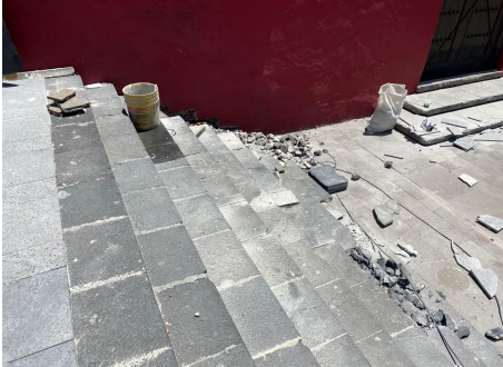
Liberación de recinto dañado en huellas de escalones, y reintegración del mismo.
