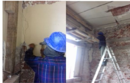
LIBERACIÓN DE APLANADO PARA CALAS DE GRIETAS EN MURO
