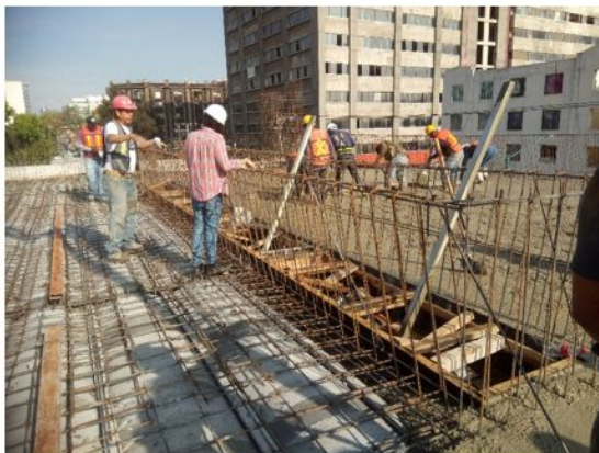
COLADO CON CONCRETO PREMEZCLADO F’C=250KG/CM2 EN PARA SISTEMA DE TECHUMBRE DE AZOTEA (3-6/B-C)
