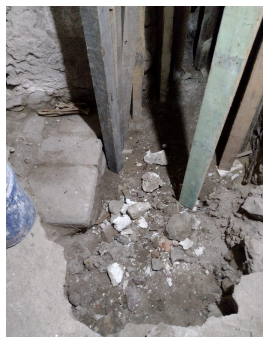
Retiro de relleno de 40 cm debajo de escalones de madera en arranque de escalera en torre campanario.
