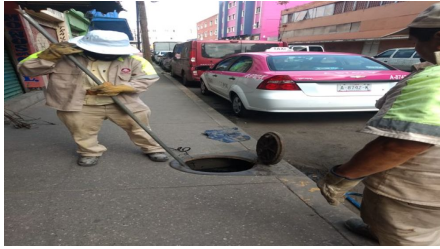
Se realizó desazolve en República de Ecuador No. 11, se limpian 2 coladeras y se sondean 8 mts. de drenaje
