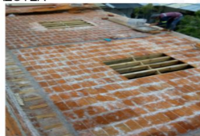
REINTEGRACIÓN DE LADRILLOS EN AZOTEA
