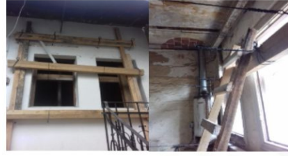
COLOCACIÓN DE APUNTALAMIENTOS EN DEPARTAMENTO
