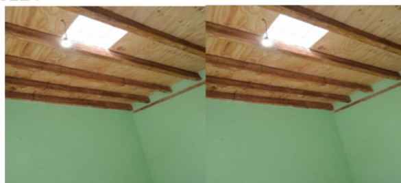
REINTEGRACIÓN DE CUBIERTA DE AZOTEA EN UNA TERCERA VIVIENDA
