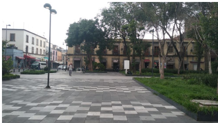
Se repara 1 circuito en Plaza Loreto, quedan funcionando 12 Luminarias
