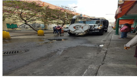
Se realizó desazolve en Arandas No. 58, se limpian 4 coladeras y se sondean 16 mts. de drenaje
