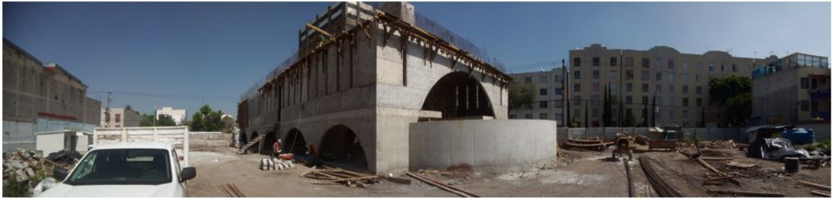
VISTA PANORAMICA NORESTE
