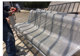
Mantenimiento a mobiliario metálico fijo.
