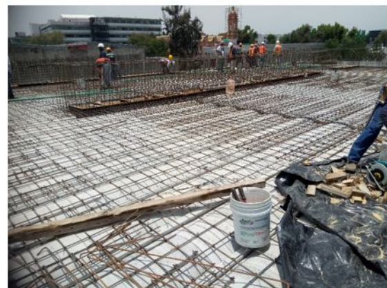
ARMADO CON ACERO DE REFUERZO PARA SISTEMA DE TECHUMBRE DE AZOTEA (3-6/B-C)
