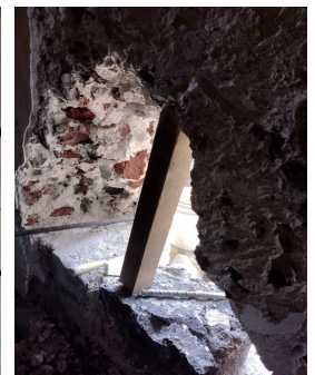
Re mamposteo de apertura.
