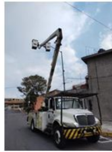
REPARACIÓN DE LUMINARIAS
