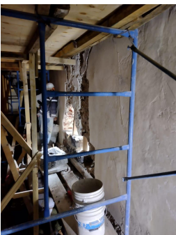
Apertura de caja en nicho de fachada oriente, con apertura por desprendimiento de material.
