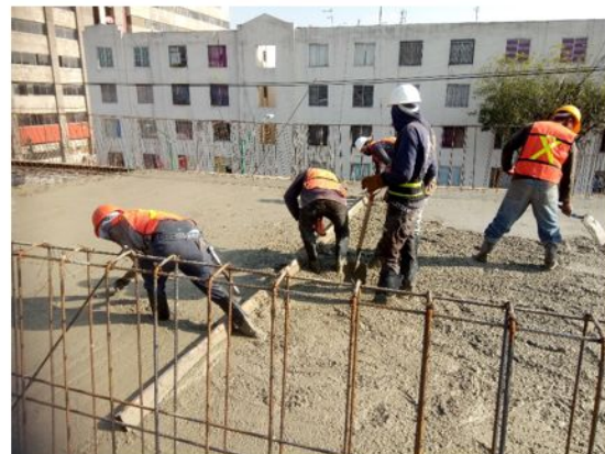
COLADO CON CONCRETO PREMEZCLADO F’C=250KG/CM2 EN PARA SISTEMA DE TECHUMBRE DE AZOTEA (3-6/B-C)
