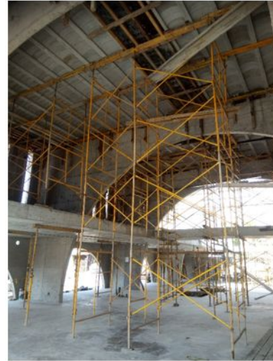
COLOCACION DE CIMBRA DE MADERA Y APUNTALAMIENTO PARA SISTEMA DE TECHUMBRE DE AZOTEA (EJES 3-6/B-C)
