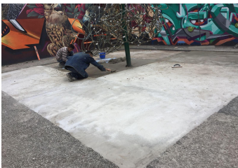
Rehabilitación de firmes para colocación de piso de hule en zonas de juegos infantiles.
