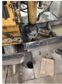
Realización de calas exploratorias y sondeos electrónicos del subsuelo.
