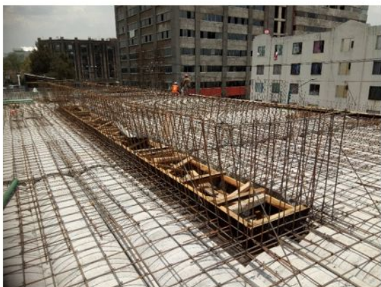
ARMADO CON ACERO DE REFUERZO PARA SISTEMA DE TECHUMBRE DE AZOTEA (3-6/B-C)
