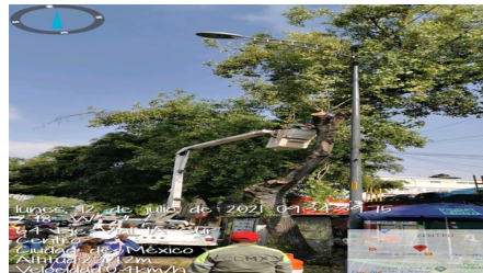
Se realizó poda para liberación de luminaria en Izazaga entre Isabel la Católica y Bolívar, 6 árboles con 6 m3 de poda
