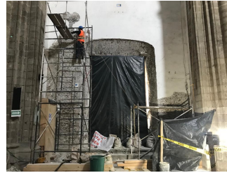
Liberación de aplanados en muros interiores.
