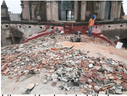
Liberación de enladrillado en extradós de bóvedas de nave principal.
