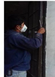
RETIRO DE PUERTAS EN DEPARTAMENTO
