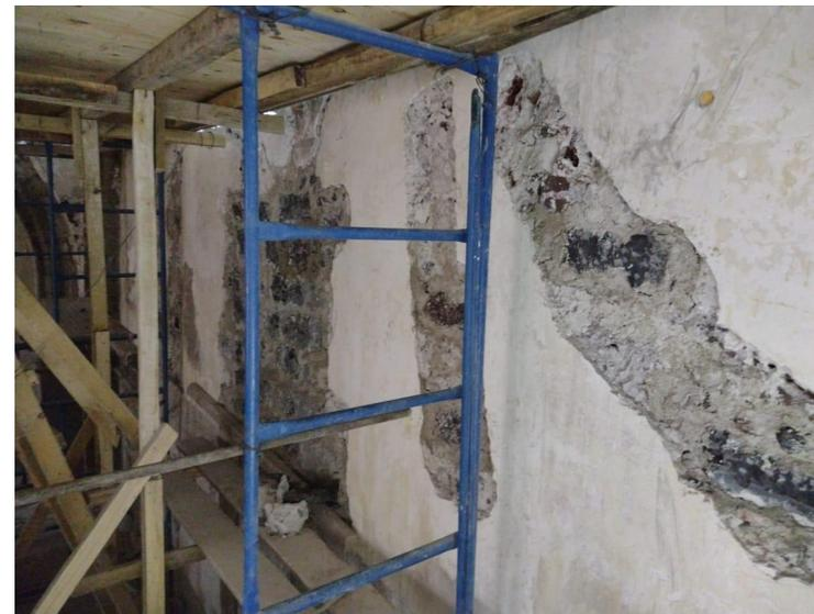
Consolidación de grietas en muro de fachada oriente.
