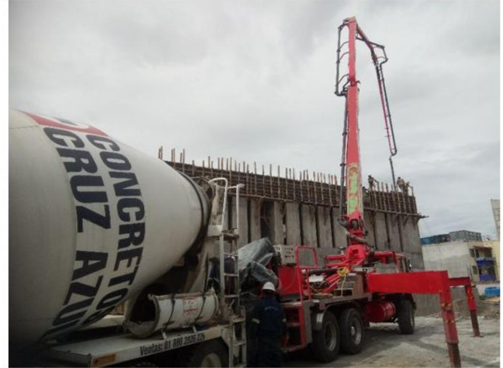
**ARMADO CON ACERO DE REFUERZO, COLOCACION DE CIMBRA DE MADERA
