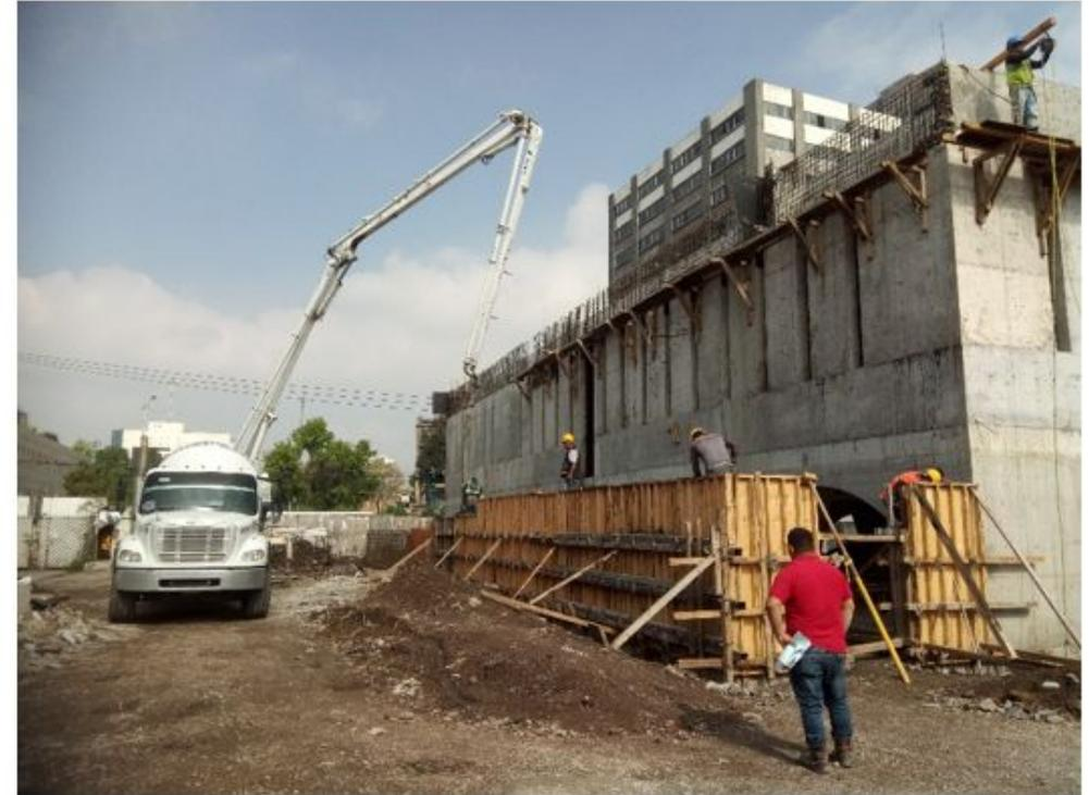
**ARMADO CON ACERO DE REFUERZO, COLOCACION DE CIMBRA DE MADERA Y COLADO CON CONCRETO PREMEZCLADO F'C=250KG/CM2 PARA PATIO DE RECREO (EJE C-D/1-6)**
