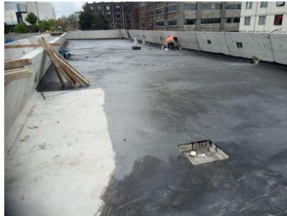
**APLICACIÓN DE PRIMARIO FESTER PARA IMPERMEABILIZACION DE AZOTEA (EJES 1-6/B-C)**
