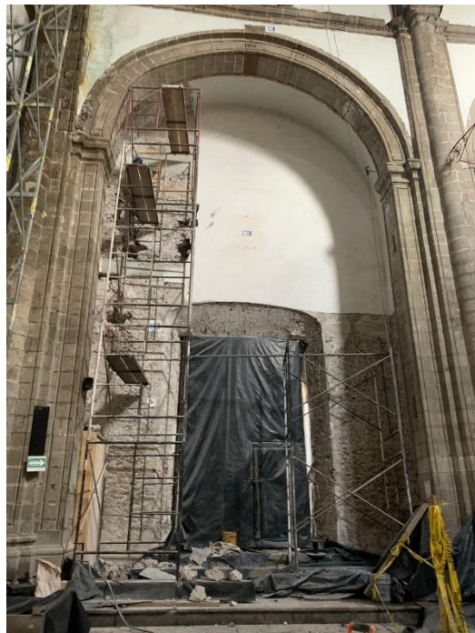
Liberación de aplanados en muros.
