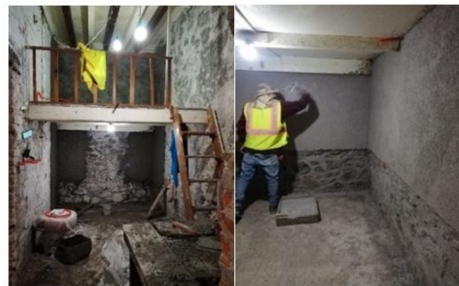
RETIRO DE APLANADOS SIN ADHERENCIA EN
