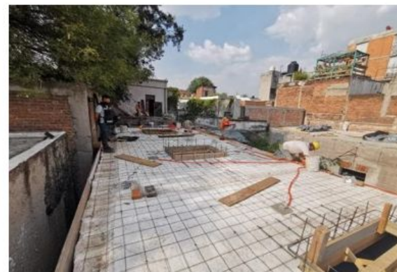
TRATAMIENTO DE VIGAS.
