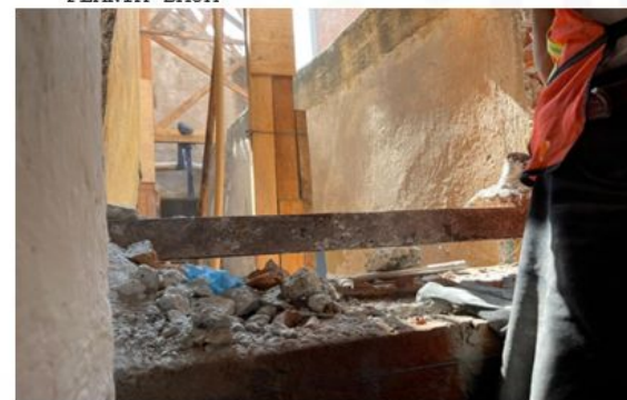
LIBERACIÓN DE MUROS DONDE SE INTEGRARÁN LOS CONTRAFUERTES EN PLANTA BAJA
