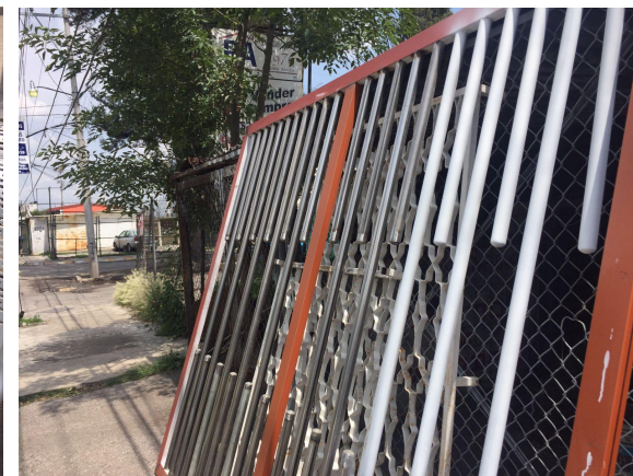
Fabricación de portón corredizo de barras, para sustitución del existente.
