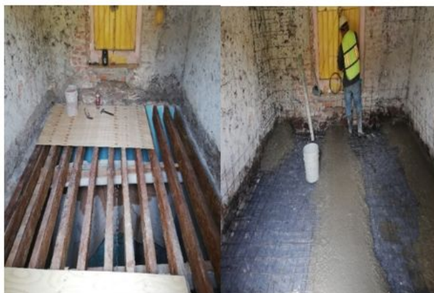
REINTEGRACIÓN DE CUBIERTA DE ENTRE PISO DE VIVIENDA
