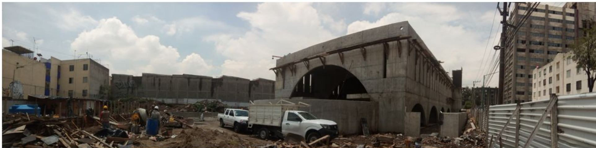
VISTA PANORAMICA SURESTE
