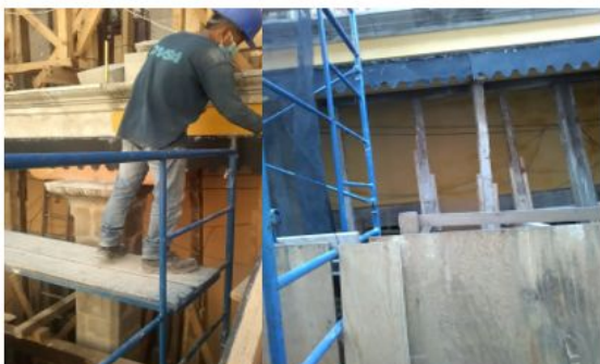
APLICACIÓN DE PINTURA EN PASILLO PLANTA BAJA
