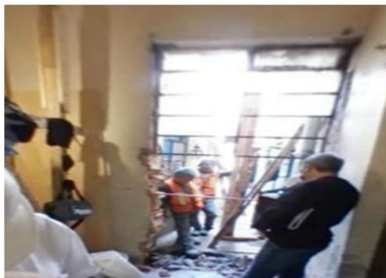
LIBERACIÓN DE MUROS DONDE SE INTEGRARÁN LOS CONTRAFUERTES EN PLANTA BAJA
