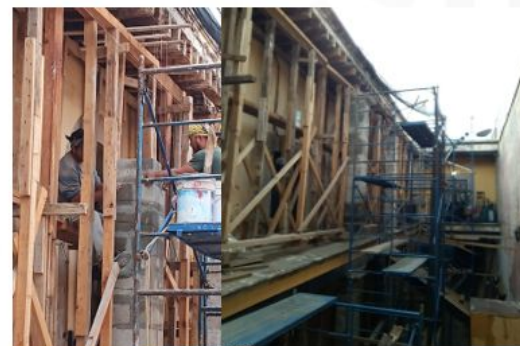
REINTEGRACIÓN DE CAJAS DE COLUMNAS EN PLANTA ALTA
