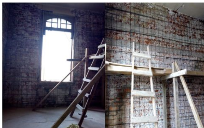
INTEGRACIÓN DE GRAPAS Y MALLA ELECTROSOLDADA EN MUROS.
