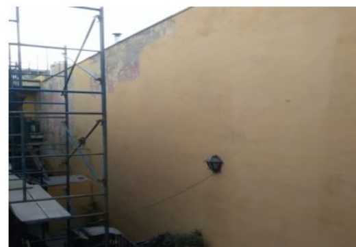
APLICACIÓN DE PINTURA EN MURO DE COLINDANCIA
