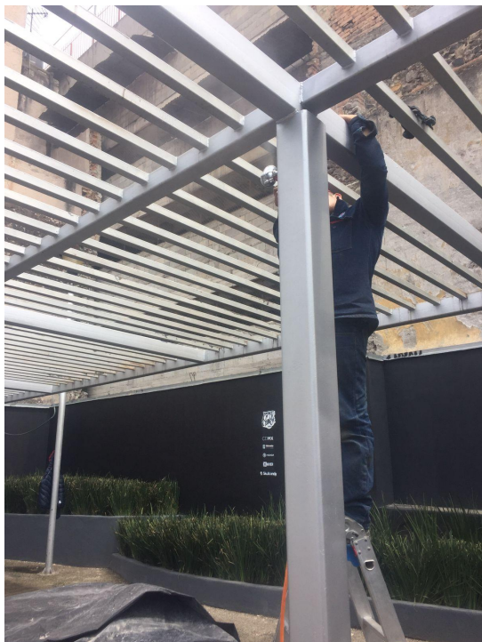
Mantenimiento de estructura metálica de cubierta.
