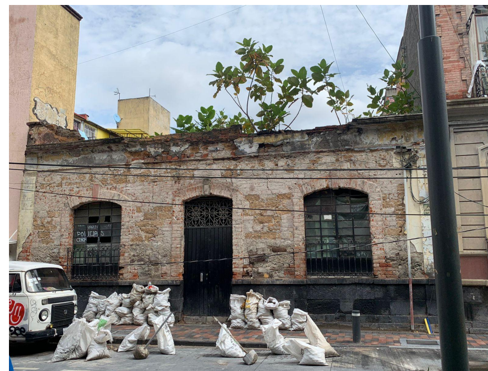
Obraje No. 7. Liberación de aplanados.
