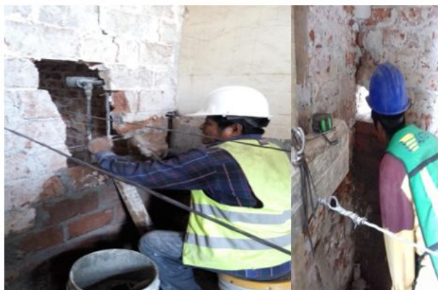
REMAMPOSTEO Y COSTURAS EN MUROS
