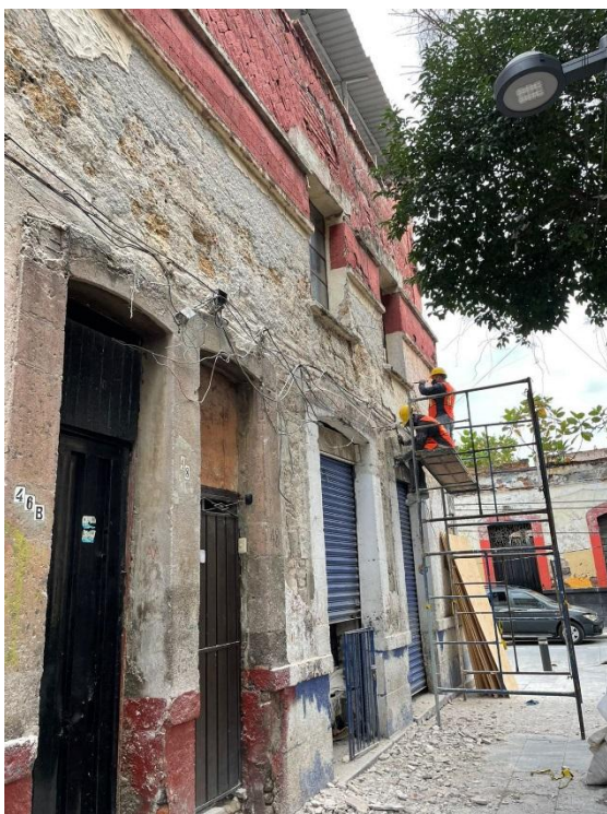
Riva Palacio No. 46-48. Liberación de aplanados en mal estado y retiro de cables en desuso.
