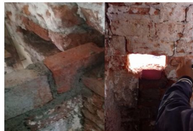
REMAMPOSTEO Y COSTURAS EN MUROS
