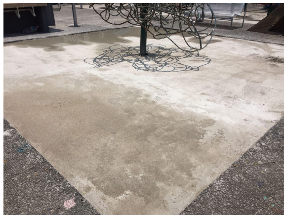
Terminación de firmes para asentamiento de piso de caucho reciclado.
