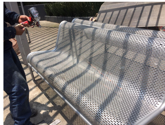
Mantenimiento de Mobiliario Urbano fijo .
