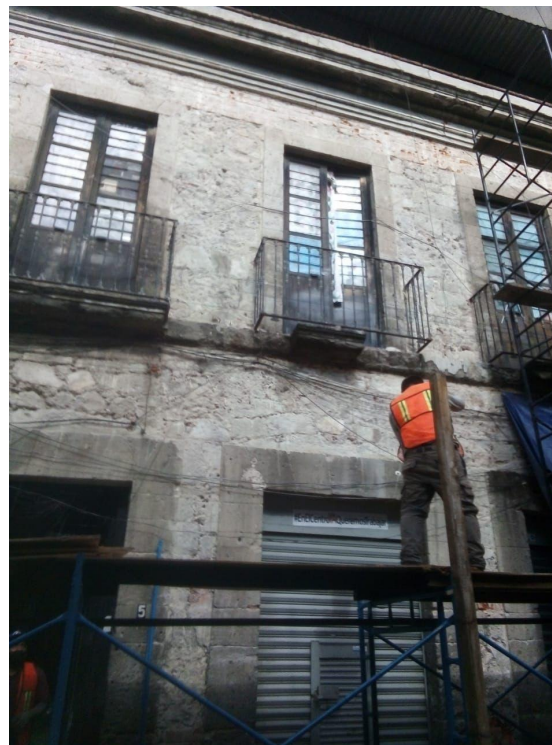
Las Cruces No. 5. Liberación de aplanados y empastes en cantera.
