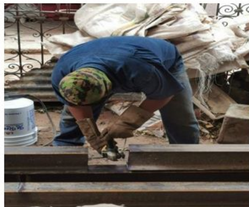
TRATAMIENTO DE VIGAS.
