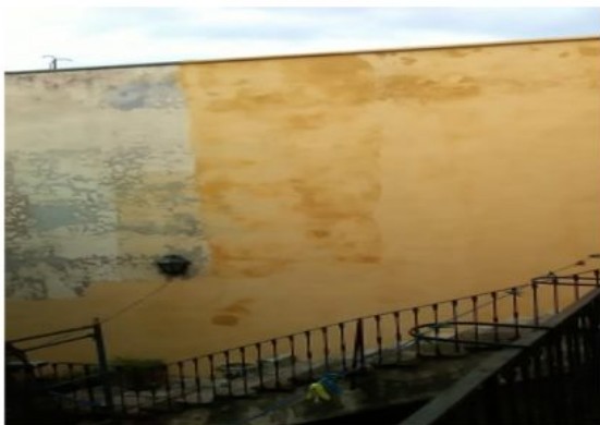
APLICACIÓN DE PINTURA EN MURO DE COLINDANCIA
