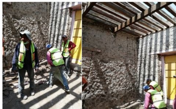
RETIRO DE APLANADOS SIN ADHERENCIA EN VIVIENDA Y REINTEGRACIÓN DE LOS MISMOS.
