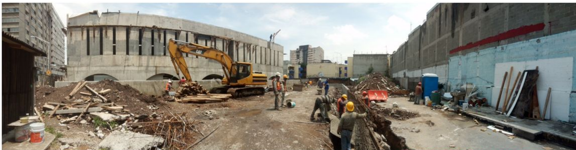
VISTA PANORAMICA NOROESTE
