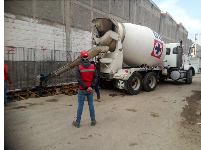
COLADO CON CONCRETO PREMEZCLADO EN CIMENTACION DEL MURO DE COLINDANCIA ORIENTE-PONIENE (EJES F/6-8)
