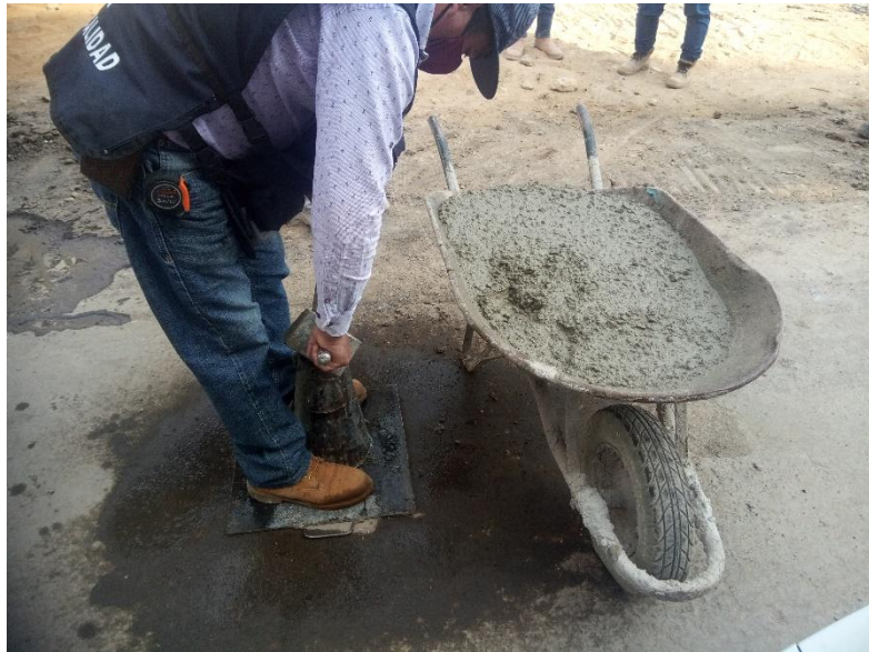
PRUEBAS DE REVENIMIENTO AL CONCRETO PREMEZCLADO
