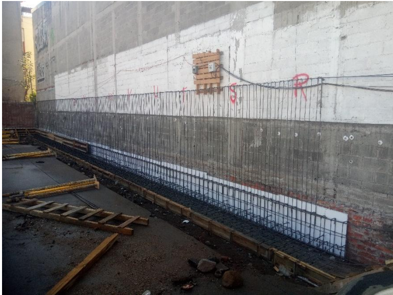
ARMADO CON ACERO DE REFUERZO Y COLOCACION DE CIMBRA DE MADERA PARA CIMENTACION DEL MURO DE COLINDANCIA ORIENTE-PONIENE (EJES F/6-8)
