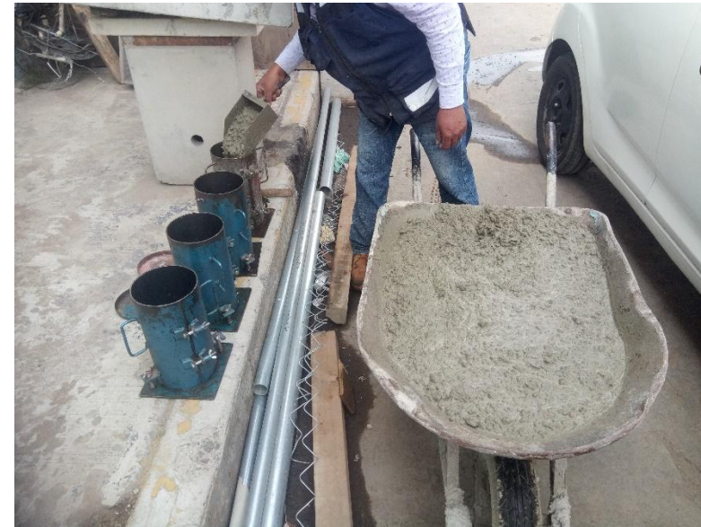
ELABORACION DE CILINDROS DE CONCRETO PARA PRUEBAS A COMPRESION
