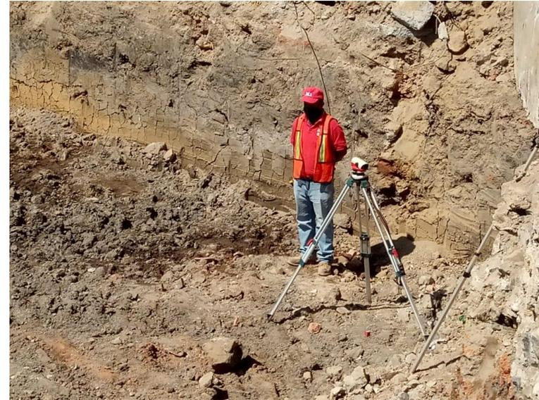
**TOPOGRAFIA VERIFICANDO LOS NIVELES DE LAS EXCAVACIONES PARA EL DESPLANTE DE LA CIMENTACION**
