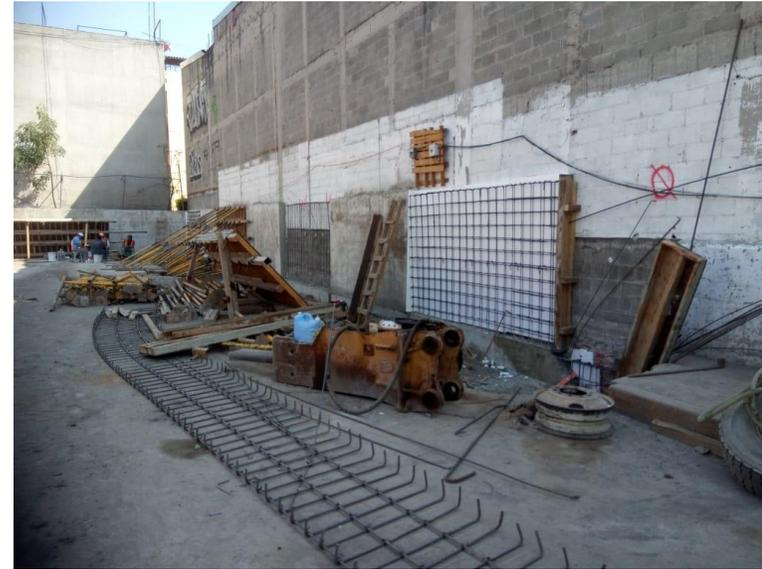
**ARMADO CON ACERO DE REFUERZO, COLOCACION DE CIMBRA DE MADERA Y COLADO CON CONCRETO PREMEZCLADO F'C=250 KG/CM2 PARA MURO DE COLINDANCIA ORIENTE-PONIENE (EJES F/6-8)**
