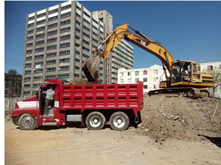
**RETIRO DE MATERIAL PRODUCTO DE LAS DIVERSAS DEMOLICIONES Y EXCAVACIONES**
