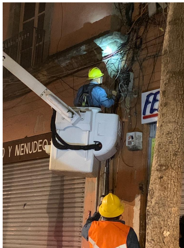
Retiro de conexiones irregulares
