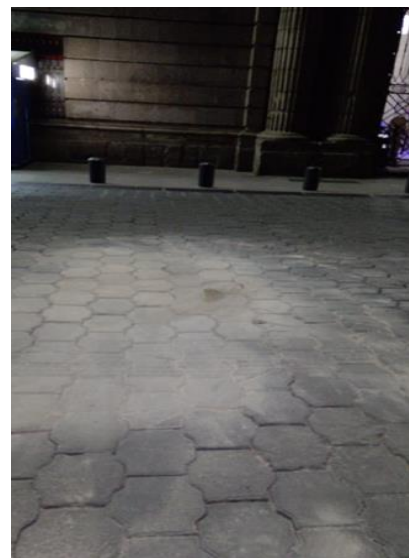
Colocación de adoquín
