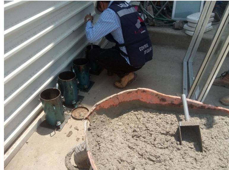
**ELABORACION DE CILINDROS DE CONCRETO PARA PRUEBAS A
