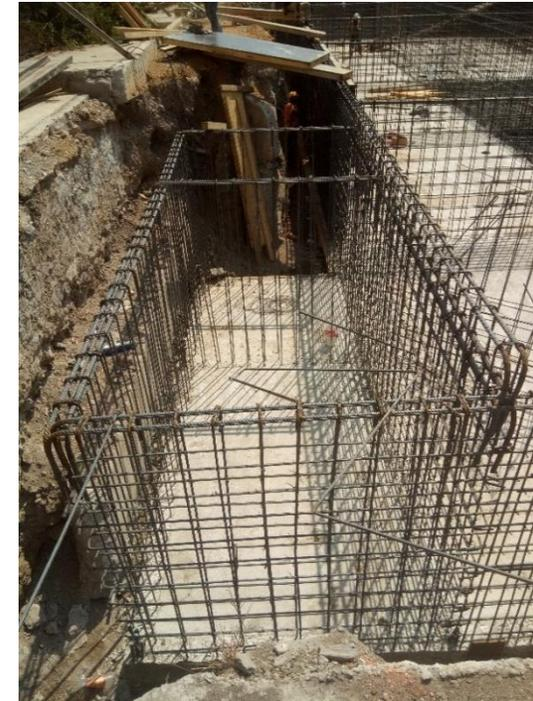
**ARMADO CON ACERO DE REFUERZO PARA MUROS MC-1/MC-2
