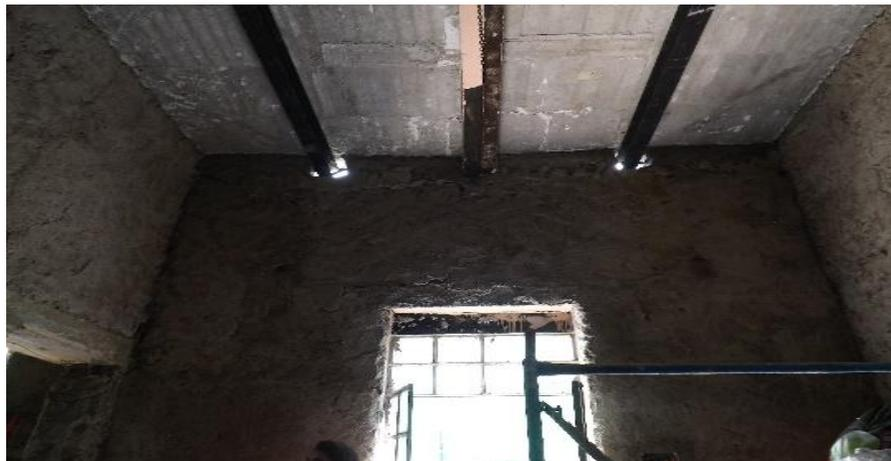
COLOCACIÓN DE VIGA PARA REFUEZO DE LOSA.
