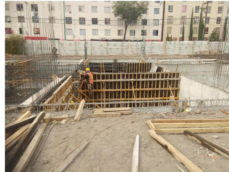
**COLOCACION DE CIMBRA DE MADERA PARA MUROS MC-1/MC-2
