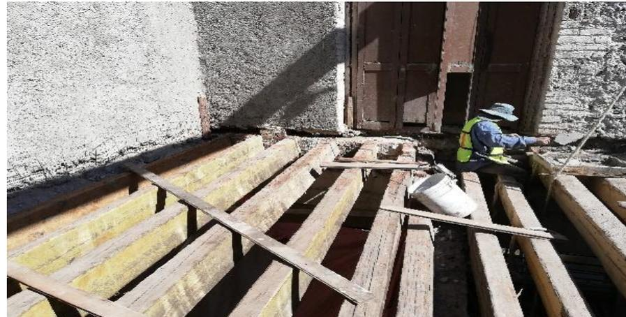
RETIRO DE CUBIERTA DE ENTREPISO EN MAL ESTADO Y LIMPIEZA
