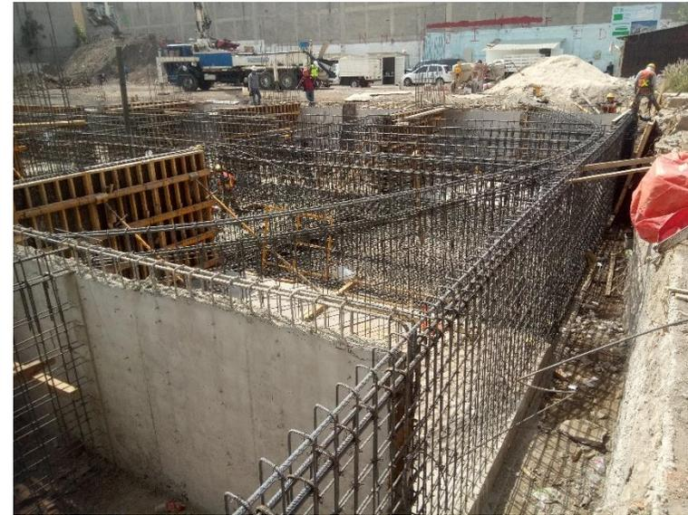
**ARMADO CON ACERO DE REFUERZO PARA MUROS MC-1/MC-2
