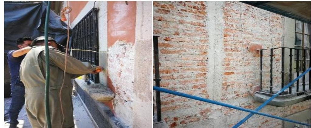
RETIRO DE APLANADO EN FACHADA PARA DETERMINAR GRADO DE DAÑO.
