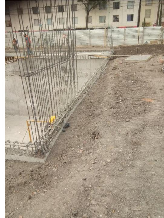
**TRABAJOS DE LIMPIEZA Y RELLENOS EN CEPAS DE CIMENTACION CON MATERIAL PRODUCTO DE EXCAVACION
