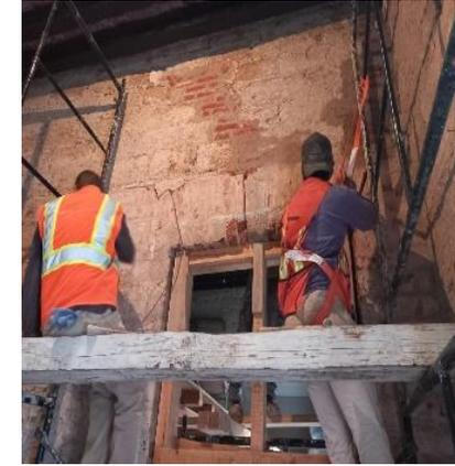
CONSOLIDACIÓN DE MUROS A TRAVÉS DE LA SUSTITUCIÓN DE MATERIALES DAÑADOS
