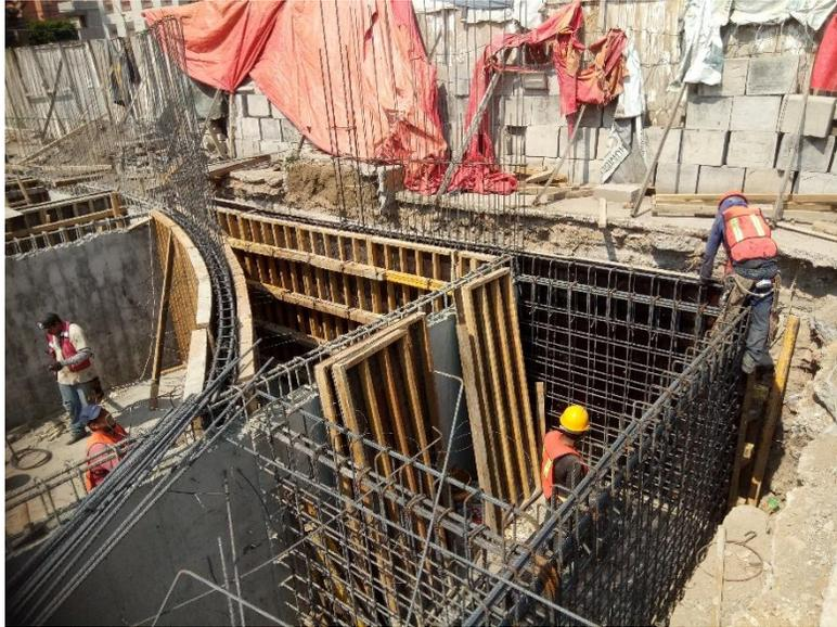
**ARMADO CON ACERO DE REFUERZO Y COLOCACION DE CIMBRA DE MADERA PARA MUROS MC-1/MC-2 DE LA CIMENTACION DEL EDIFICIO PRINCIPAL (EJES 1-2/B-C)**
