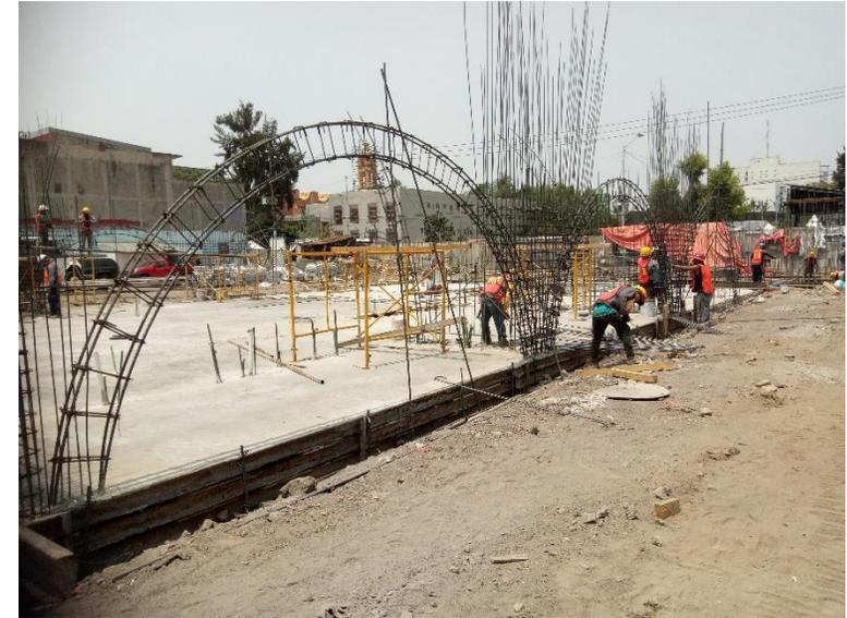
**ARMADO CON ACERO DE REFUERZO PARA ARCOS Y MUROS MC-1
