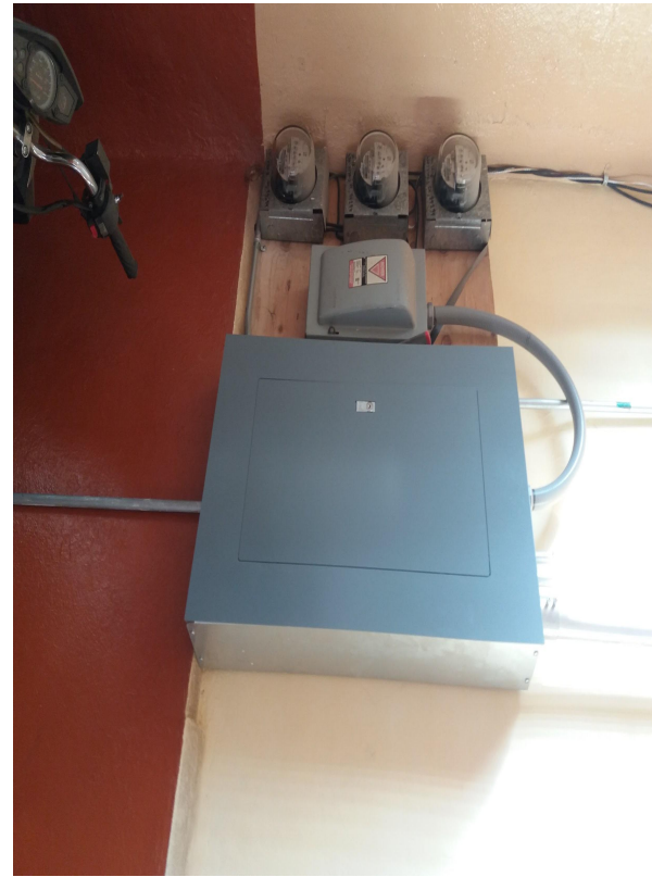
Rehabilitación de instalación eléctrica, tablero general, luminarias y apagadores.
