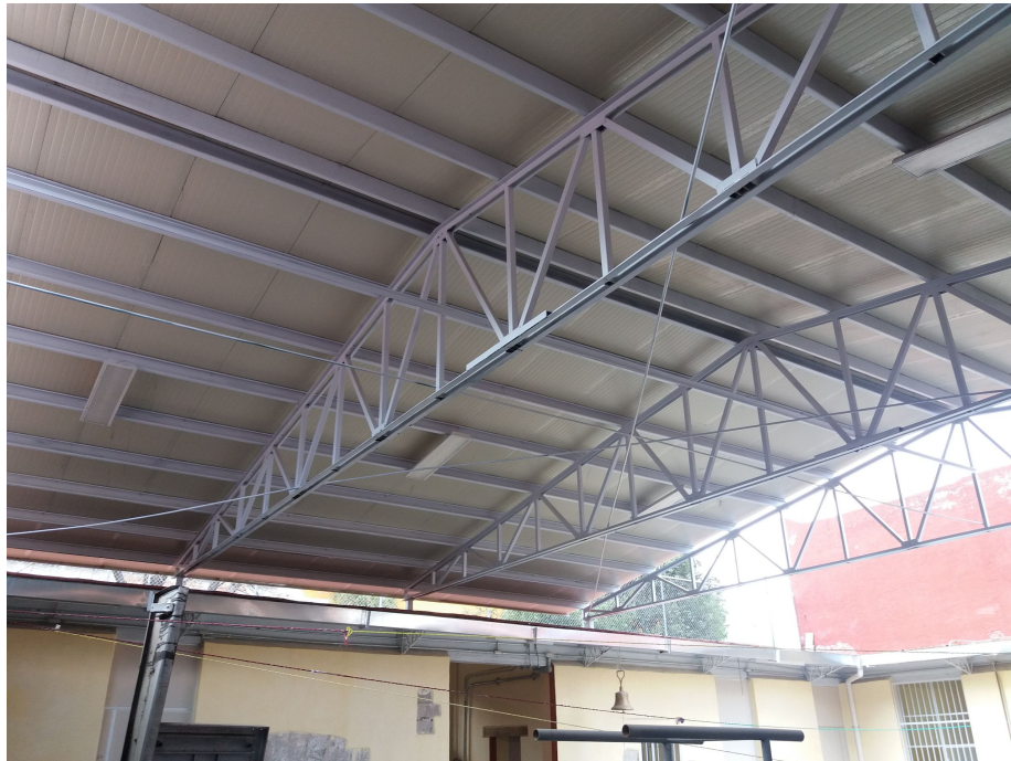
Colocación de techumbre de estructura metálica y multi-panel, colocación de canalones, bajadas pluviales y luminarias.
