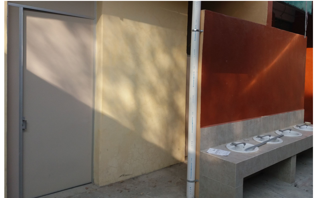
Rehabilitación de modulo de baños niñas y niños y lavamanos en patio principal.
