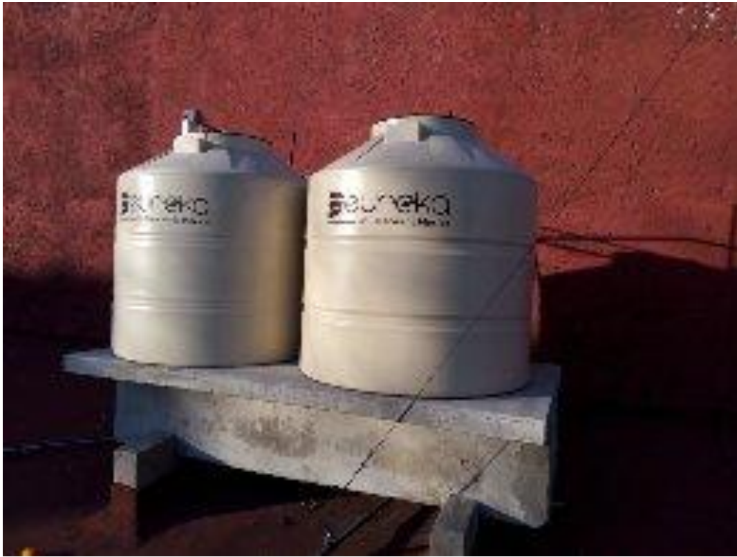
Colocación de tinacos y red hidráulica, bomba de agua para módulos sanitarios.
