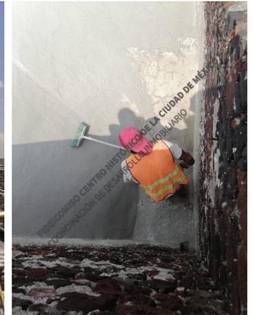
Trabajos en extradós de bóveda principal, colocación de capa de compresión.
