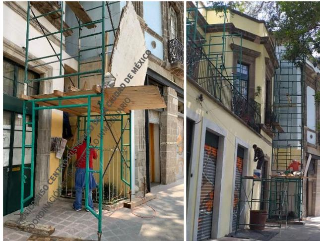
**Bucareli No. 73: Aplicación de pintura vinílica según muestra autorizada por INAH.**
