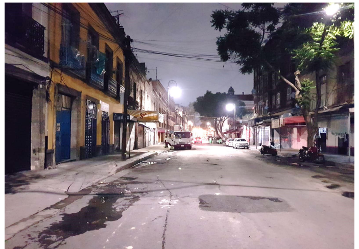
RECONEXIÓN DE LÍNEAS.
