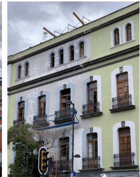
Brasil No. 67: Aplicación de pintura vinílica.
