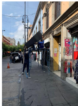
Leona Vicario No. 10, Retiro de toldos para montaje de andamios.
