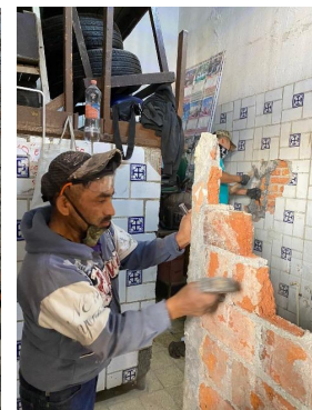
Liberación de muretes en núcleo de sanitarios.
