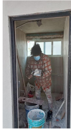
▶ Trabajos de colocación loseta de porcelanato en sanitarios de terraza en azotea.
