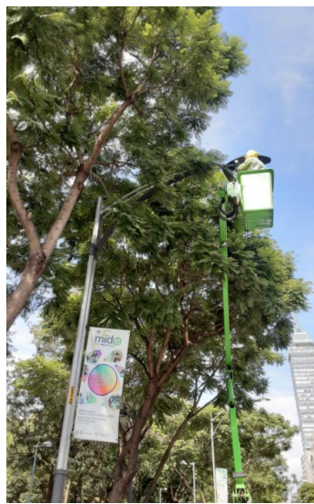
SE REALIZA INSTALACIÓN DE BALASTRO.
