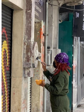
Bucareli No. 66: Retiro de pintura de elementos ornamentales de granito.
