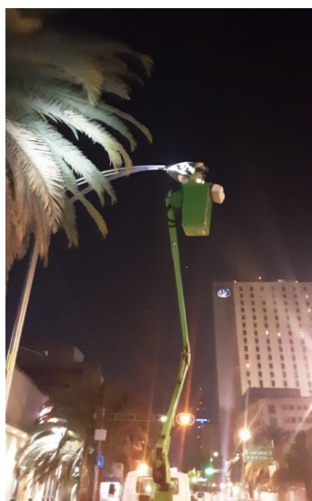
SE REALIZA INSTALACIÓN DE LAMPARA.
