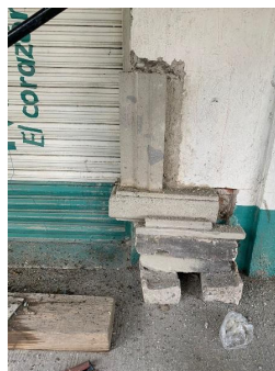
Bucareli No. 154: Sustitución de sillares de cantera deteriorados.
