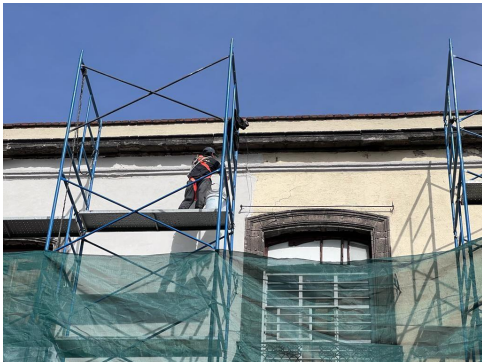
Brasil No. 60: Preparación para integrar pintura vinílica.
