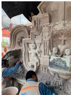
Ecuador No. 8 - 12, Restauración de portada.
