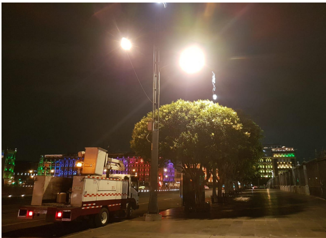
CAMBIO DE BALASTRO.
