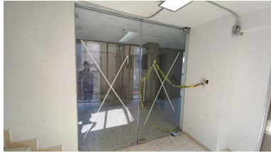
▲ Trabajos de colocación cancelas de aluminio y vidrio templado en fachadas internas y vestíbulo de acceso de nivel dos.
