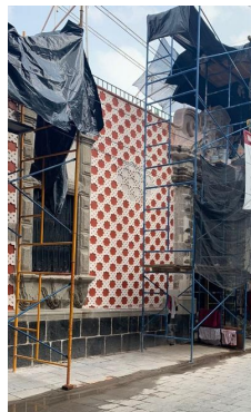
Ecuador No. 8 - 12, Aplicación de pintura a la cal.
