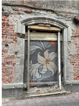
Bucareli No. 53: Sustitución de sillares de cantera en arcos.
