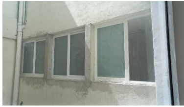
▲ Trabajos de colocación cancelas de aluminio y vidrio templado en fachadas internas y vestíbulo de acceso de nivel dos.
