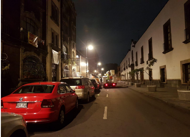
RECONEXIÓN DE LÍNEAS.
