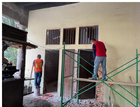
Retiro de aplanados por presentar pérdida de adherencia en muros exteriores del núcleo de sanitarios.
