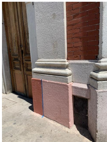
Bucareli No. 157: Muestras de capa de protección anti grafiti base cal.
