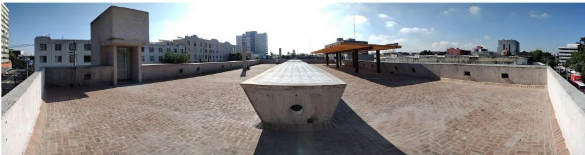
VISTAS PANORAMICA DE LA AZOTEA
