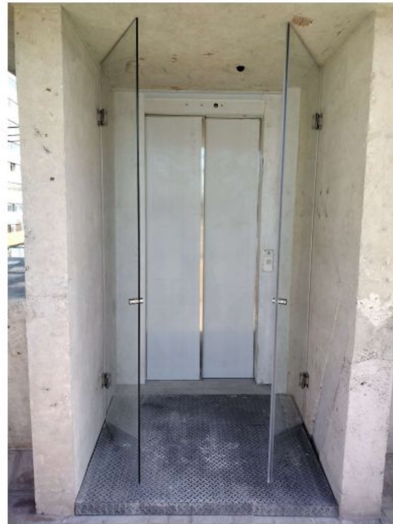
COLOCACIÓN DE PUERTA DE CRISTAL EN ELEVADOR, NIVEL AZOTEA
