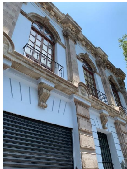
Bucareli No. 40: Aplicación de pintura vinílica.
