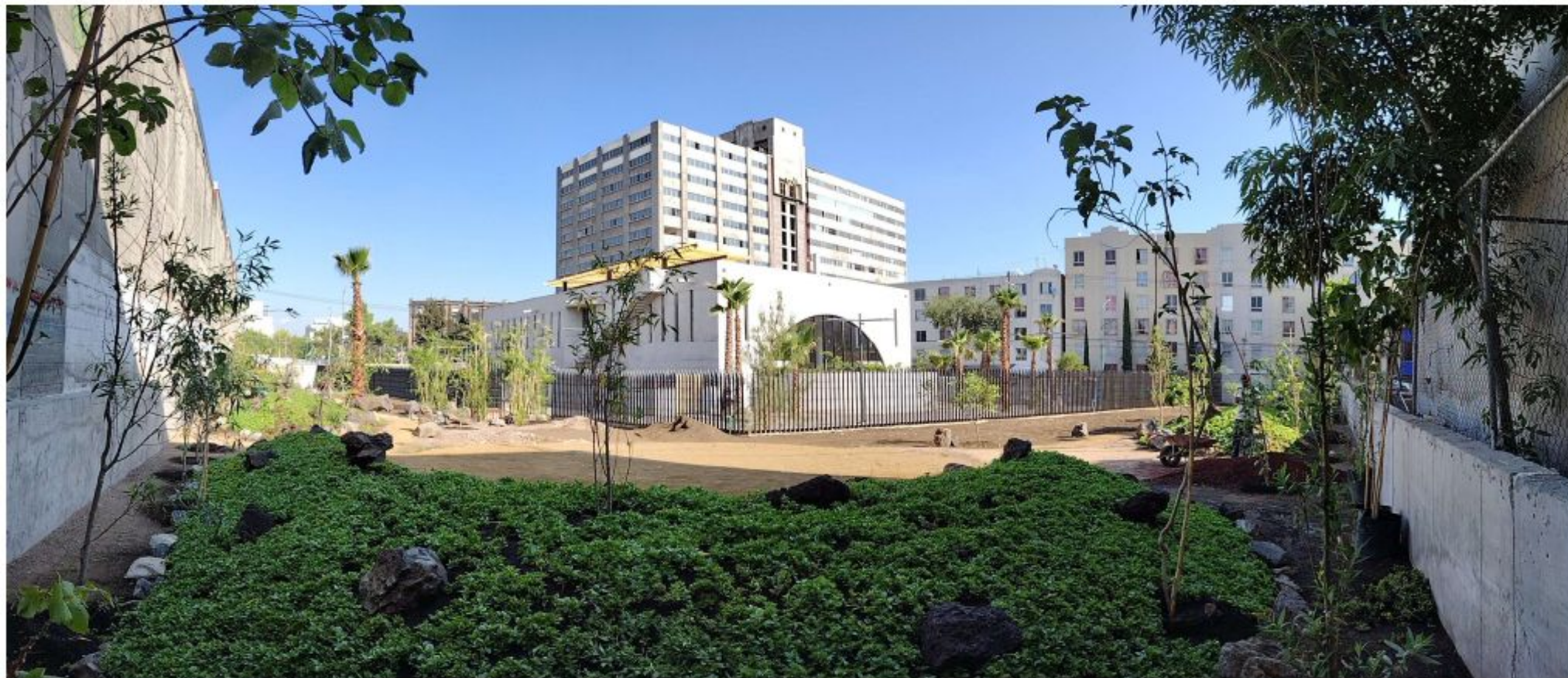
VISTA PANORAMICA NORESTE
