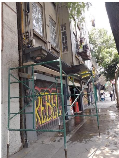
Bucareli No. 66: Trabajos preliminares de montaje de andamios y hamacas.
