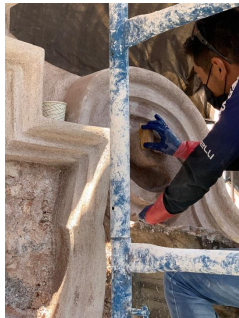
Ecuador No. 8 - 12, Restauración de portada del siglo XVII.
