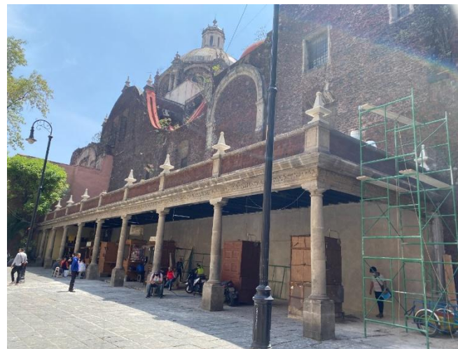
Restitución de pináculos labrados en cantera a partir de modelo existente en sitio.
