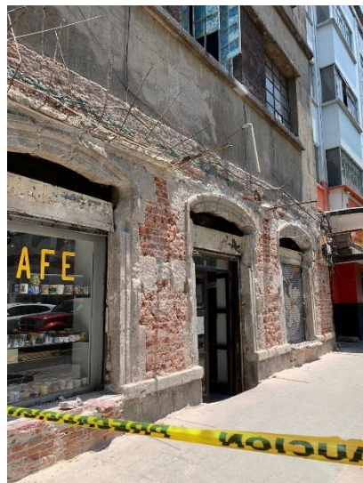
Bucareli No. 53: Demolición de marquesina y recuperación de marcos originales de cantera.
