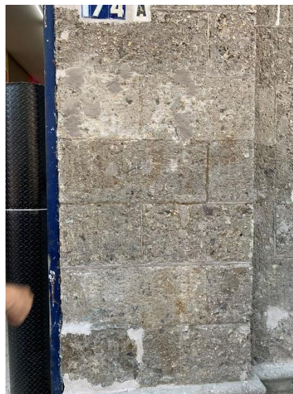
Bucareli No. 174: Aplicación de tratamiento hidrofugante en elementos de cantera.
