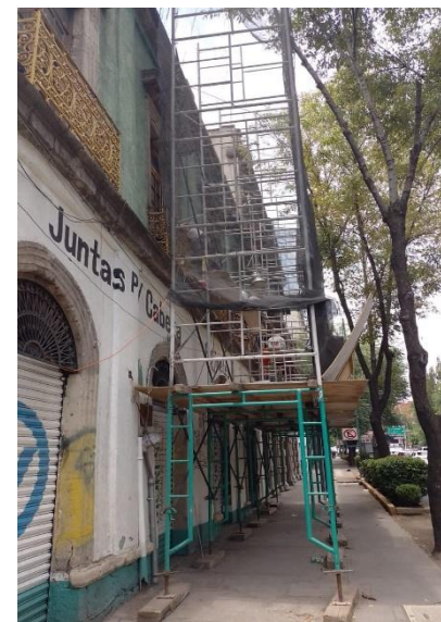
Bucareli No. 154: Trabajos preliminares de montaje de andamios.
