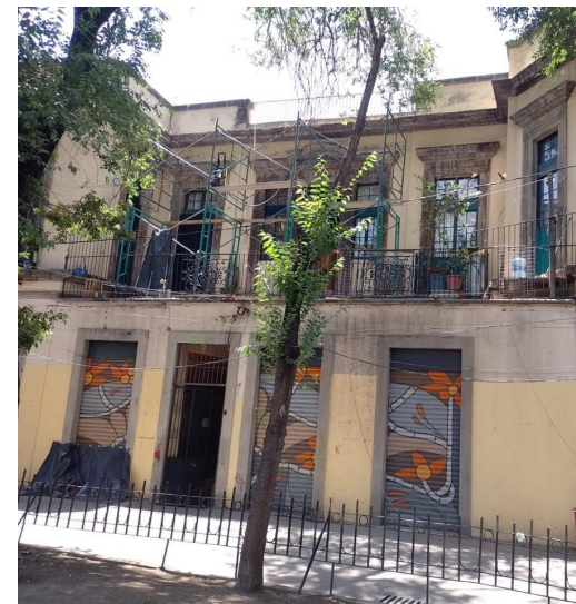
Bucareli No. 73: Trabajos preliminares de montaje de andamios.
