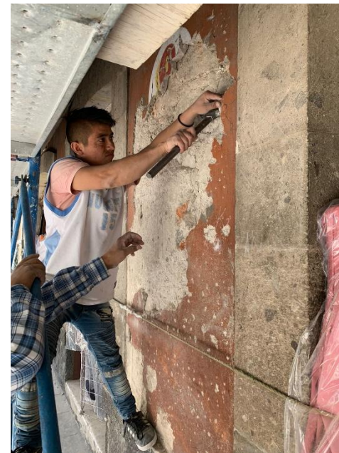
Leona Vicario No. 8, Liberación de aplanado en mal estado.
