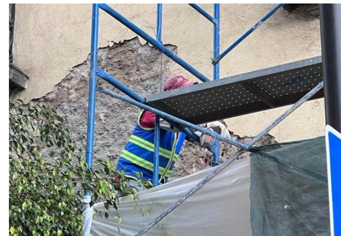
Brasil No. 60: Retiro de aplanado en mal estado.
