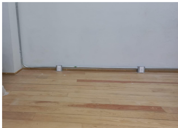
Trabajos de habilitado de canalizaciones y alimentadores en contactos y energía para proyección de video y sonido. Auditorio.
