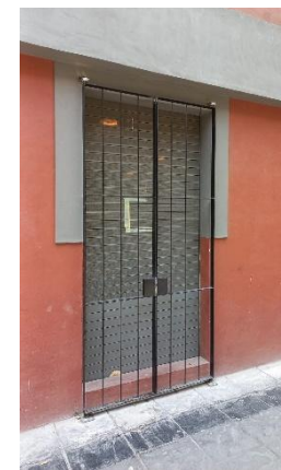
Habilitado y colocación de protecciones de herrería para vanos hacia fachada de planta baja.
