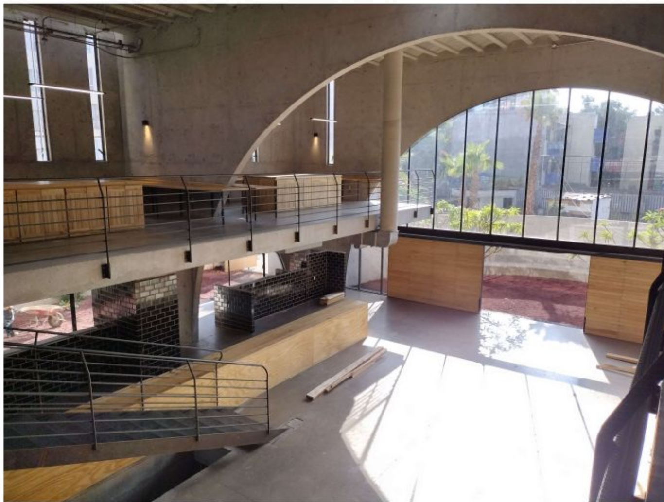
TRABAJOS DE MADERA
