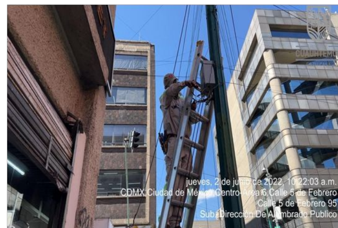
Reconexión a contactor en 5 de Febrero
