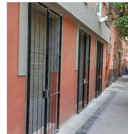
Habilitado y colocación de protecciones de herrería para vanos hacia fachada de planta baja.
