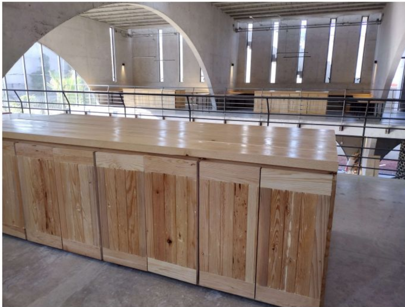
TRABAJOS DE MADERA
