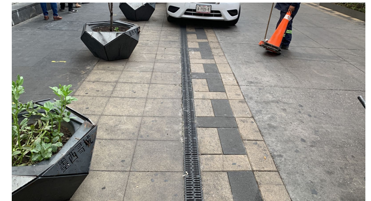
Reposición de rejillas de dren en Dolores
