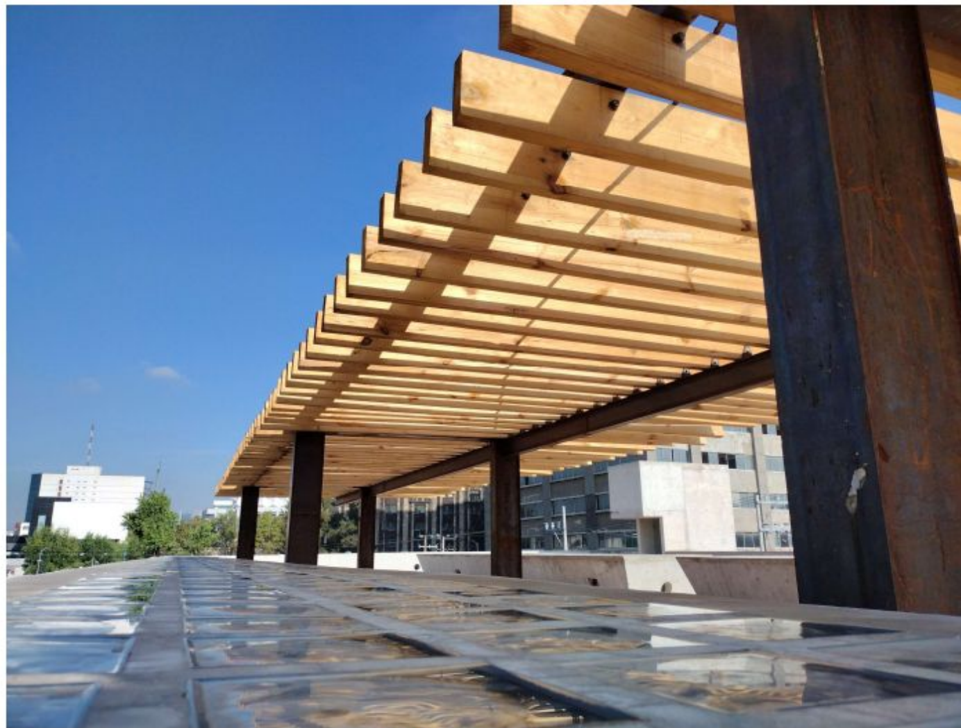
TRABAJOS DE MADERA
