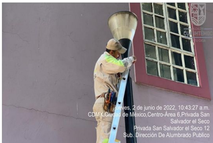
Cambio de luminaria en San Salvador el seco
