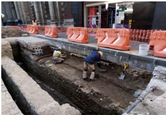
2. Se continúan trabajos de excavación por medios manuales para llegar al desplante del inicio de construcción de la caja de válvulas.
