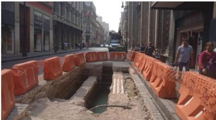
1. Se continuó con los trabajos de excavación a cielo abierto y ya han sido retiradas las canalizaciones de CFE que se encontraban fuera de servicio.
