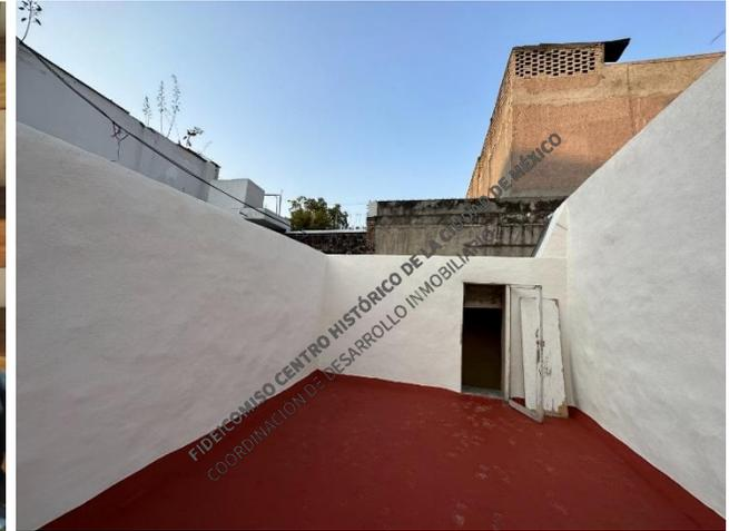
Liberación de columna de concreto adosada a estructura histórica, reintegración de aplanados en muros históricos, aplicación de biocida y tratamiento de conservación en elementos estructurales de madera y aplicación de pintura a la cal elaborada in situ (previa autorización de tonalidades por INAH).
