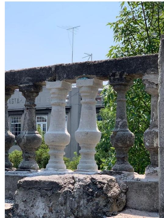
**Bucareli No. 69: Sustitución de elementos deteriorados en balaustrada.**
