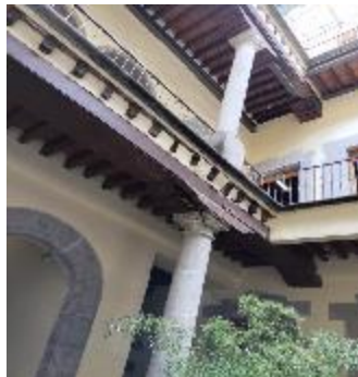
Daño en inmueble por sismo
