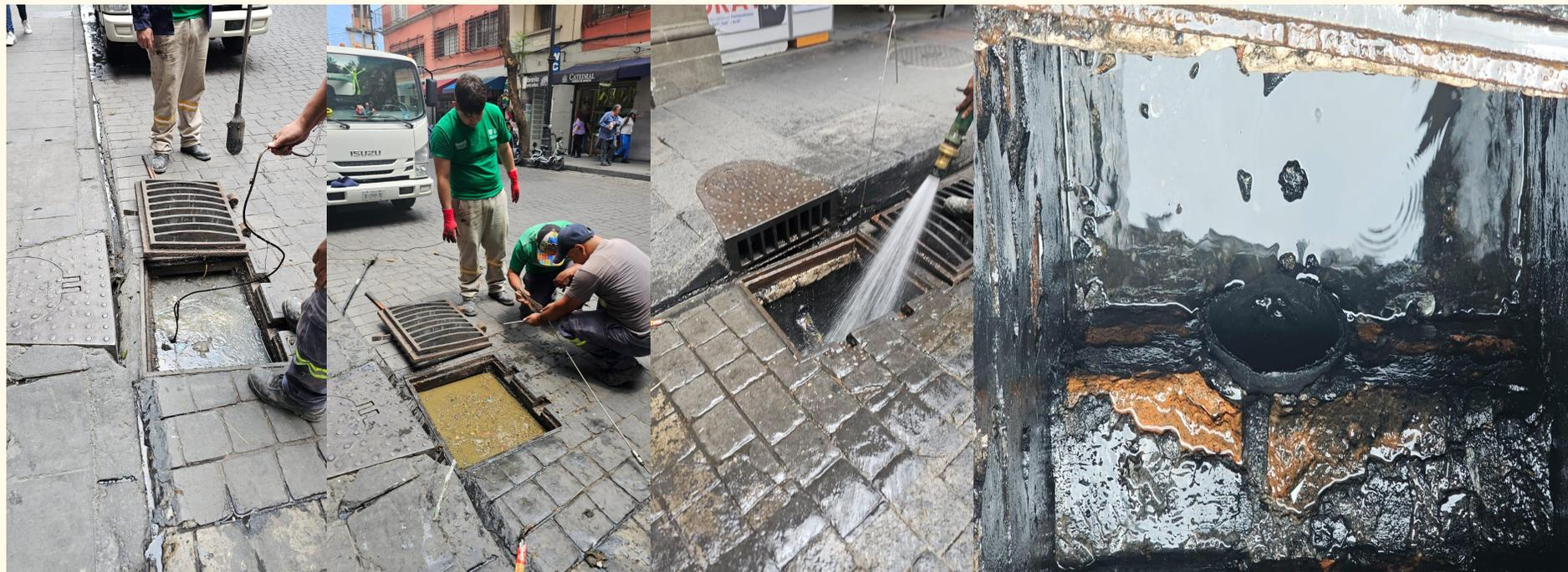
Se realizó limpieza y desazolve en dos accesorio pluviales (rejilla de piso y coladera de guarnición), así mismo desazolve 5 metros lineales de atarjea retirando aproximadamente .20 M<sup>3</sup> desazolve.
