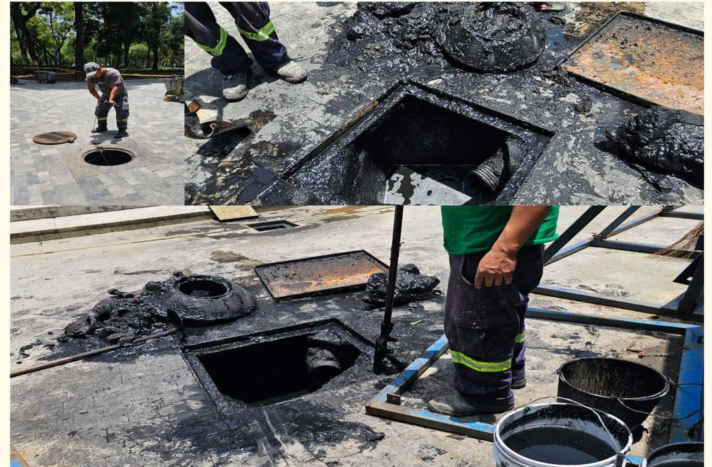
Se realizó desazolve en 14 Metros lineales de atarjea, retirando .20 M<sup>3</sup> de azolve, se realizó limpieza de un registro pluvial
