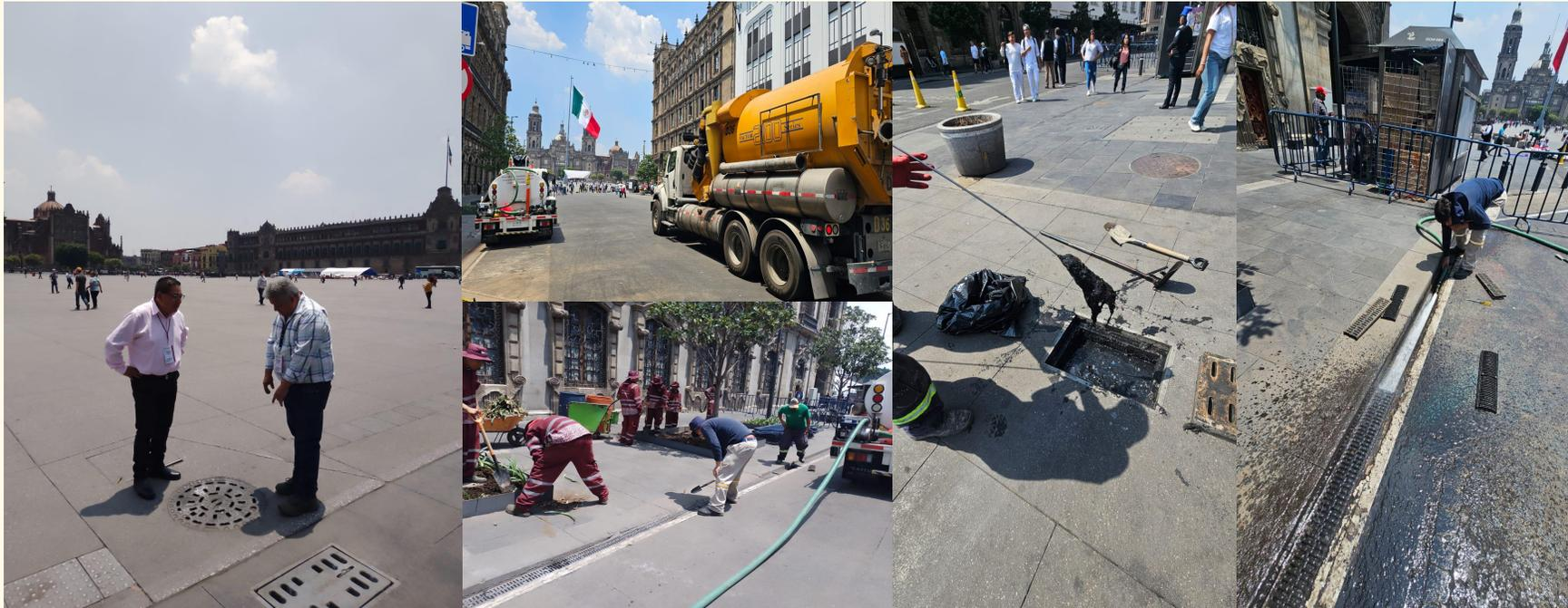
Se realiza desazolve en dren pluvial 34 Metros lineales retirando .20 M<sup>3</sup> de azolve, se realizó limpieza de dren Pluvial 34 metros lineales y por último se realizó limpieza y desazolve de tres registros pluviales en dos turnos
