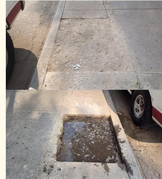
Se realiza retiro de residuos en cajete; se retiró tierra vegetal y pedacería de azulejo en cajete con un volumen total de 0.096 m<sup>3</sup>
