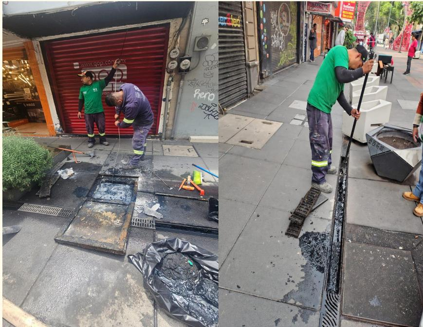
Se realizan trabajos de desazolve en el dren pluvial 40 metros lineales, retirando .50M cúbicos de azolve y se realiza el desazolve de dos registros pluviales
