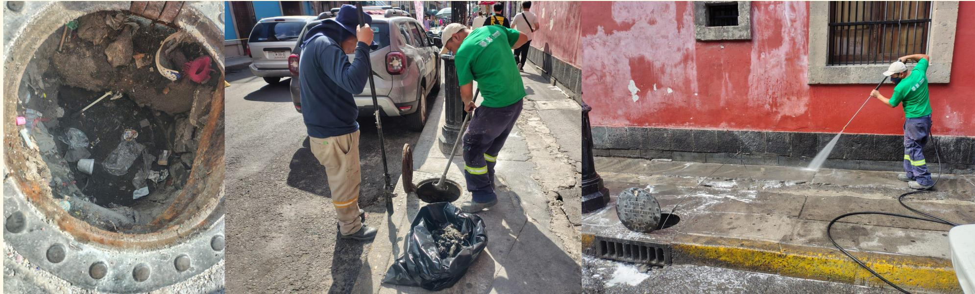
Se realizó desazolve y limpieza de un registro pluvial y se realizó limpieza de 4 metros lineales de atarjea, así mismo se realizó lavado del registro pluvial y se realizó lavado de 15 M<sup>2</sup> de banquetta
