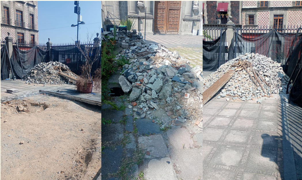
intervención con cuadrillas y camiones de carga para el retiro de cascajo Catedral Metropolitana CDMX
