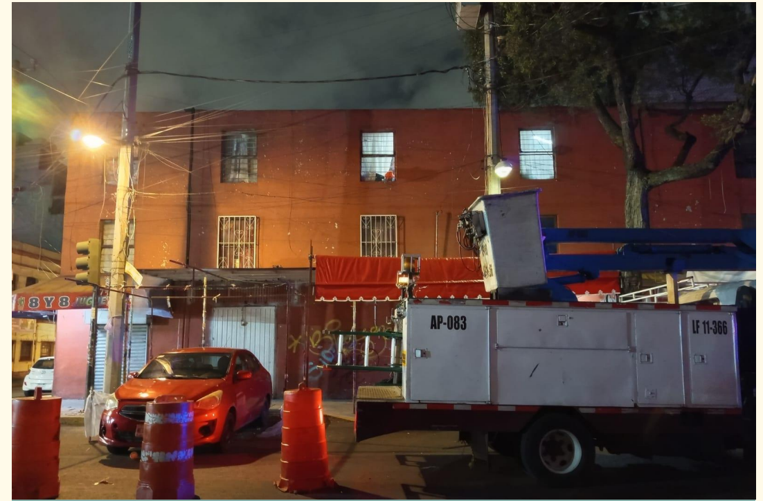
RECONEXIÓN DE LÍNEAS DE ALIMENTACIÓN
