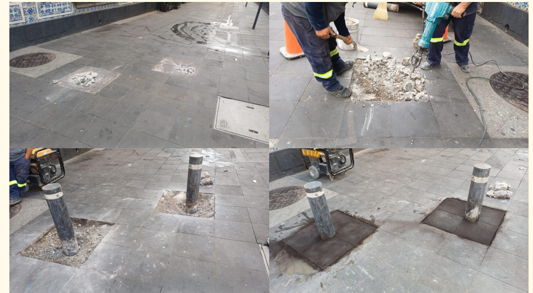
demolición de área para alcanzar nivel, retirando material y se colocan 2 bolardos Calle Condesa esq 5 de Mayo
