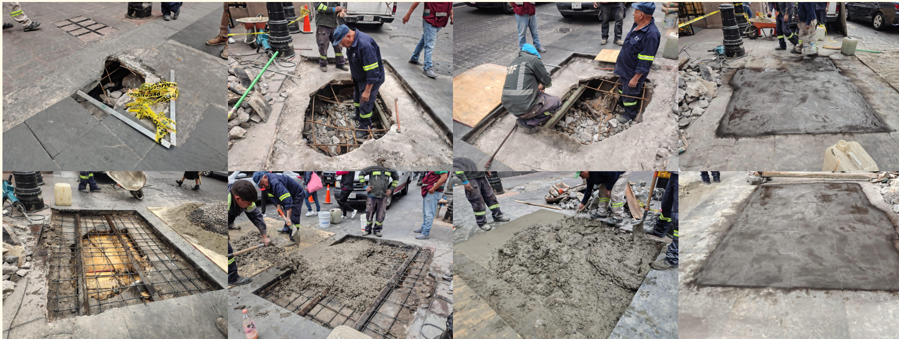
Reparación de losa de bóveda de CFE. Calle Donceles Esquina con calle Marconi
