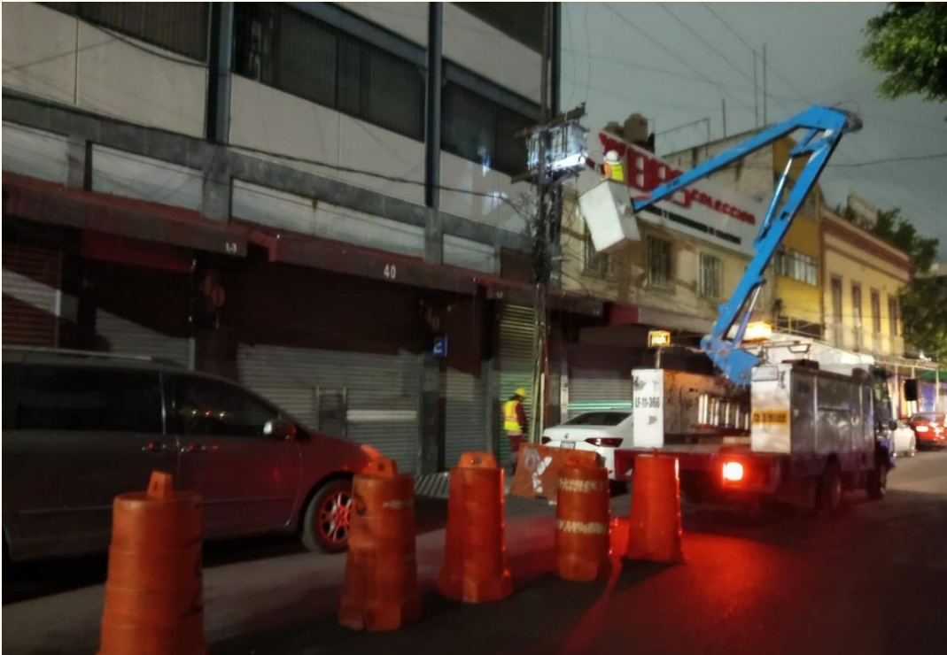
RECONEXIÓN DE LÍNEAS DE ALIMENTACIÓN
