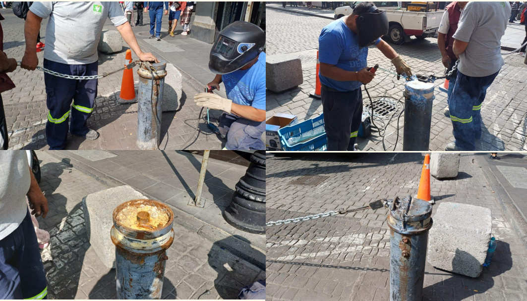
Se habilita tapa de 6" de diámetro soldado a la corona del bolardo y reforzando Calle Brasil esq Guatemala
