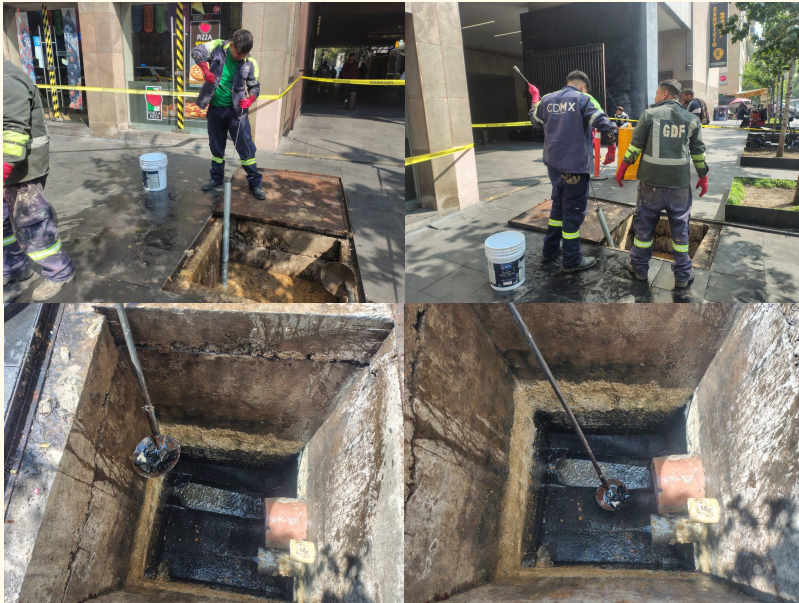
Limpieza y desazolve de un registro de descarga y retiró un taponamiento Calle Independencia esquina con calle Marroquí
