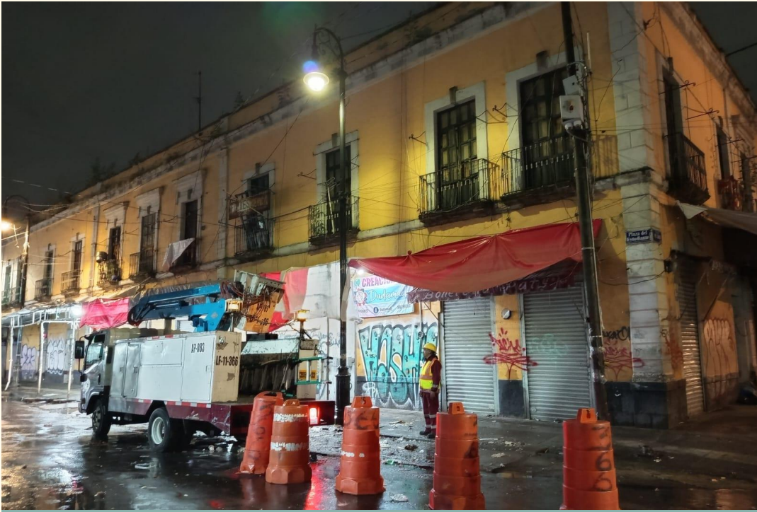
RECONEXIÓN A LÍNEAS DE ALIMENTACIÓN
