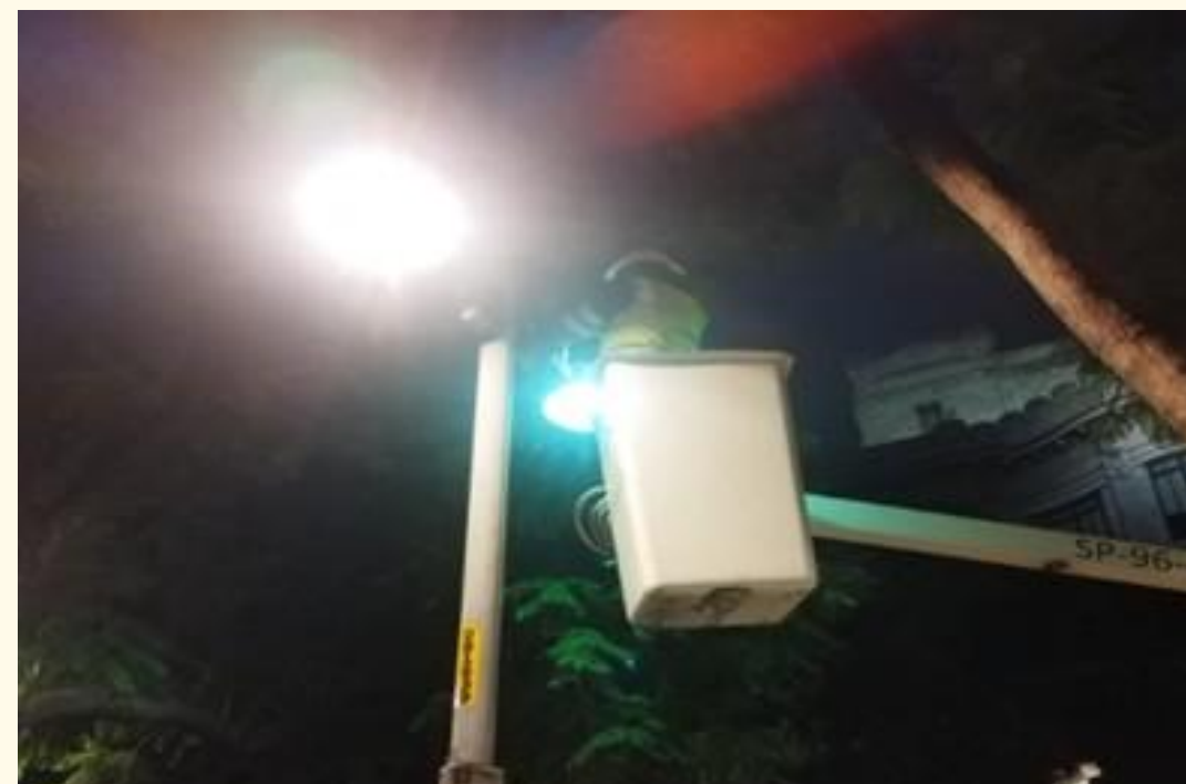
RECONEXIÓN EN BALASTRO ELECTRÓNICO
