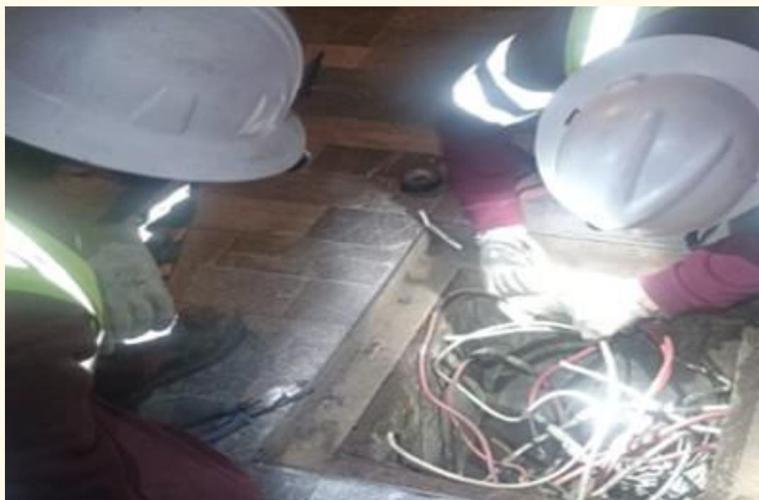
RECONEXIÓN DE LÍNEAS EN REGISTRO
