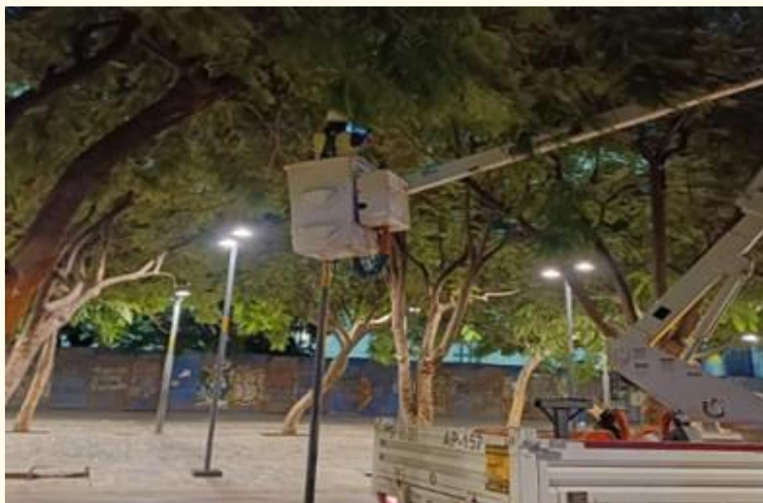
REEMPLAZO DE FOCO Y SOCKET
