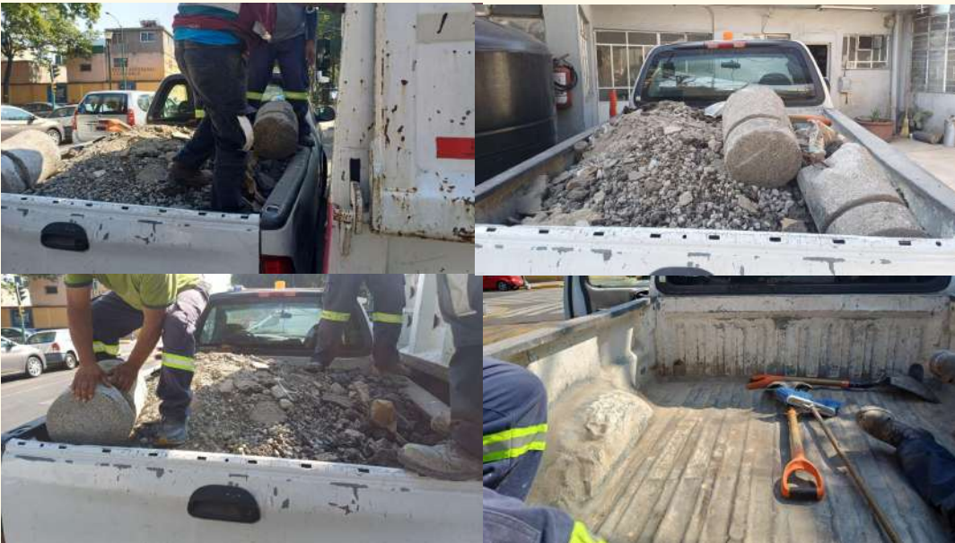
Carga y descarga de material (cascajo) producto de las obras realizadas por esta área San Antonio Abad # 65 a Plaza Ciudadela.
