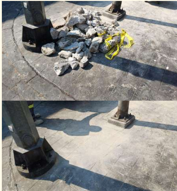
Retiro de material sobrante de obra Calle Roldan esq. Con calle Rep. De el Salvador
