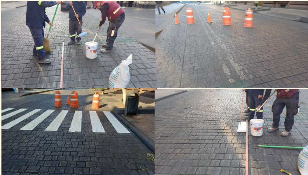
Trazado y aplicación de pintura en paso peatonal Calle 5 de mayo al cruce con calle Condesa
