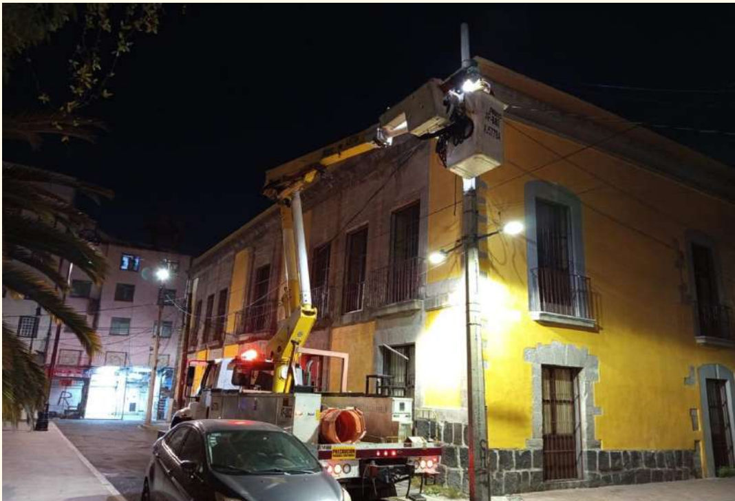
RECONEXIÓN DE LÍNEAS DE ALIMENTACIÓN
