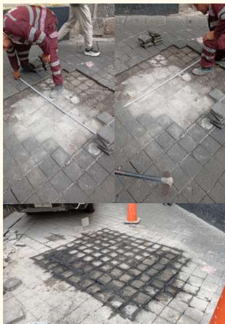
Colocacion de 70 losetas basaltin Calle República de Argentina y calle del Carmen
