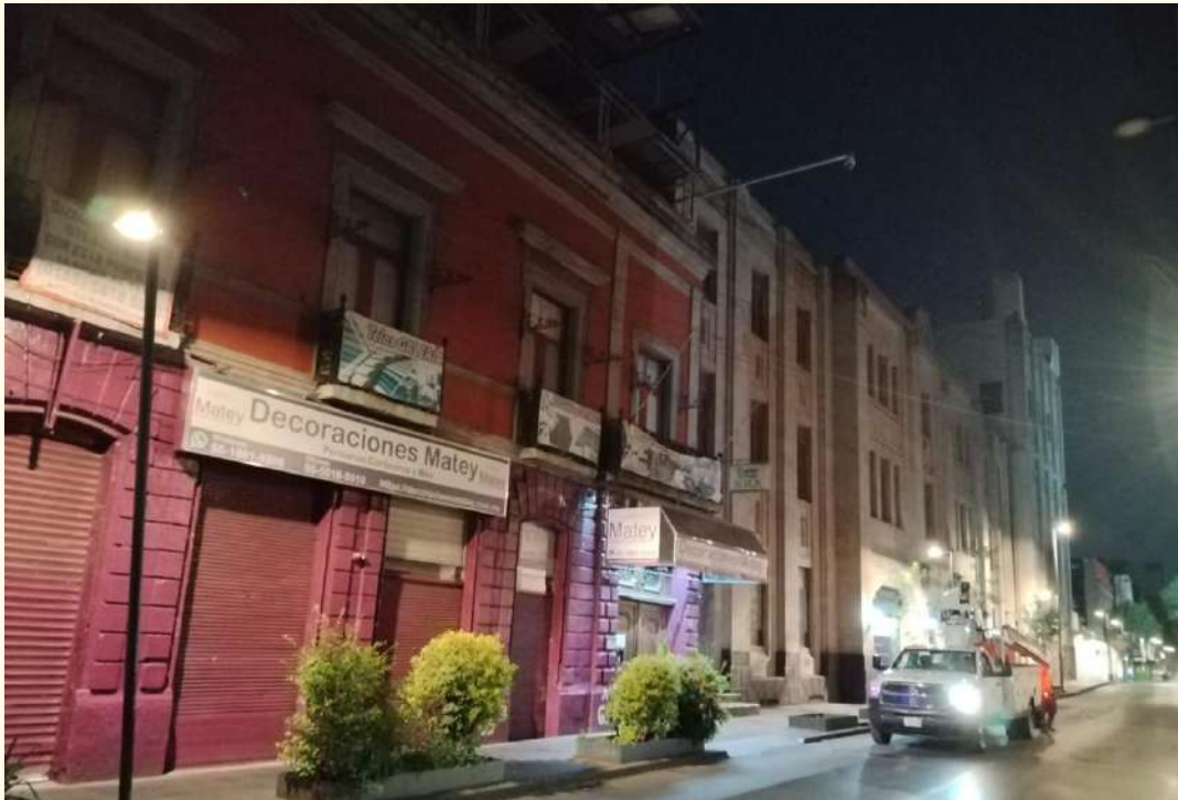
RECONEXIÓN DE LÍNEAS DE ALIMENTACIÓN
