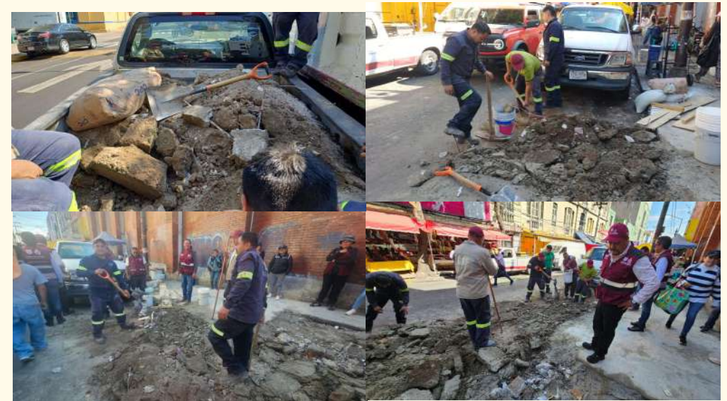
Retiro de cimbra y demolición de piso y se carga producto de la demolición Calle Aztecas
