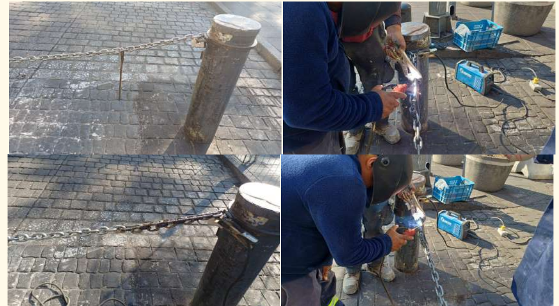
Soldadura en la cadena para control de acceso Calle Guatemala esquina con calle Monte de piedad.
