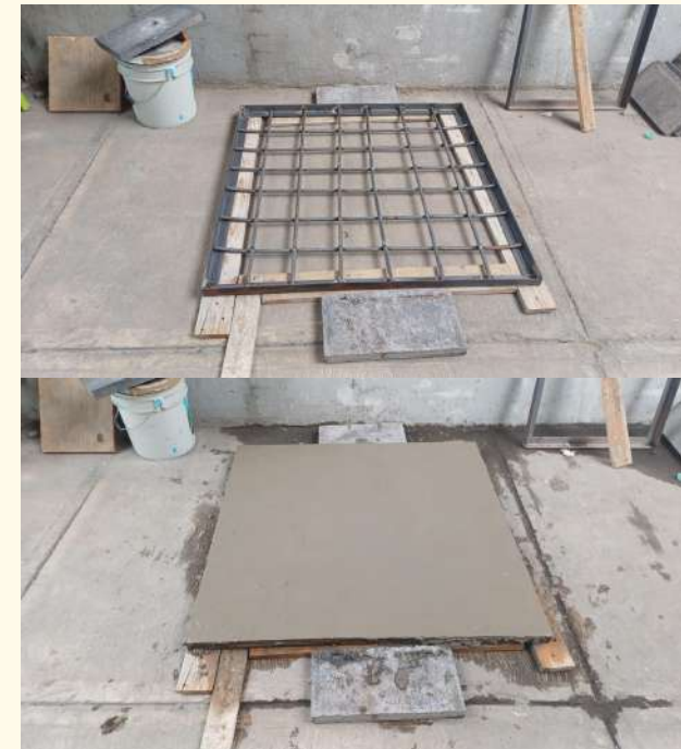
Colado de 1 tapa de registro San Antonio Abad # 65
