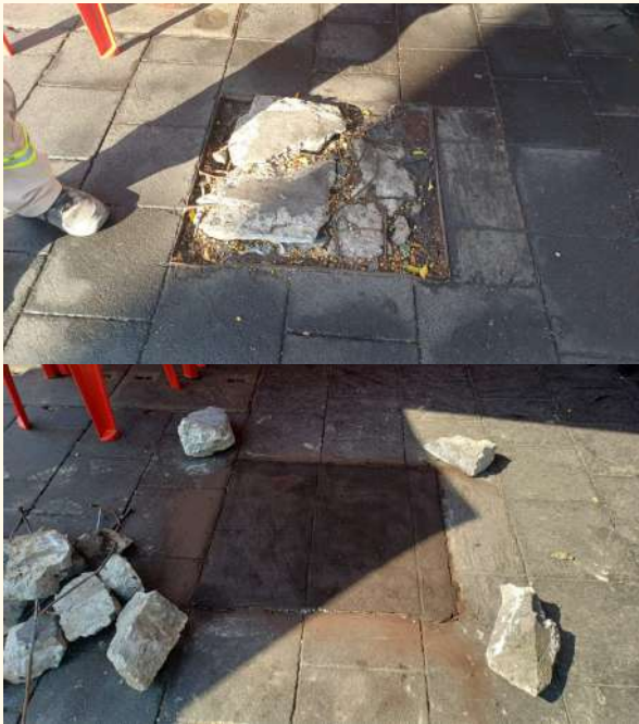
Demolicion de 1 tapa y colado en color negro estampado Calle Roldan entre Uruguay a Salvador
