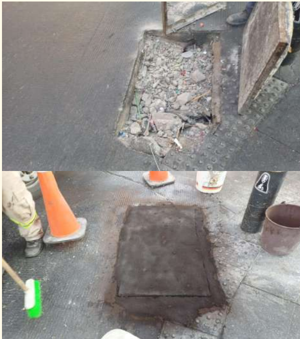
Demolición y colado de una tapa de registro de alumbrado público Calle Soledad esq con calle Correo Mayor.
