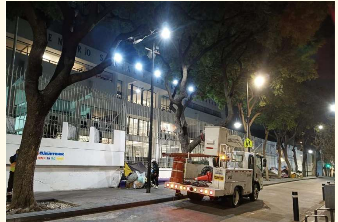
REHABILITADO DE CABLE
