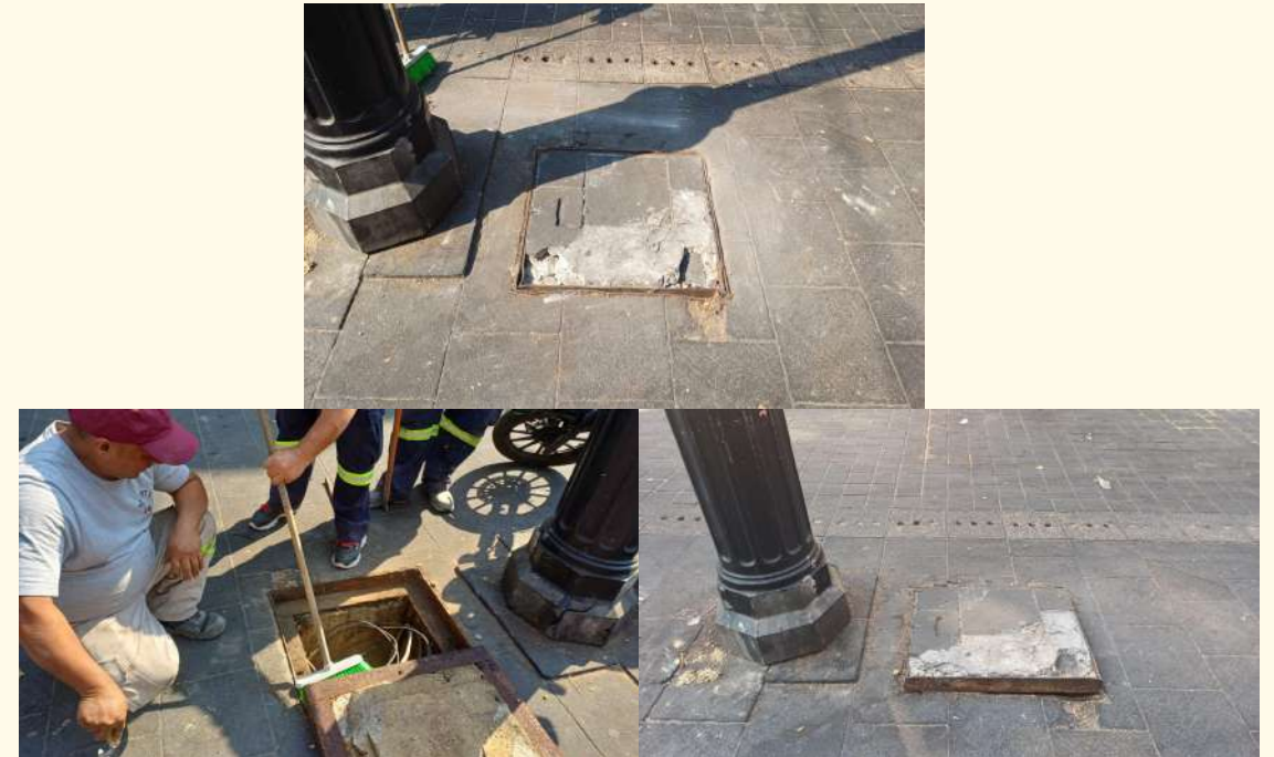
Renivelacion de 1 tapa de registro de alumbrado público Calle Calle Roldan entre Uruguay a Salvador
