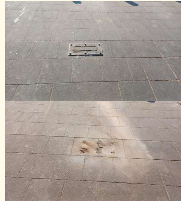
Retiro de una base, 6 pernos y una placa de teléfono Calle Roldan entre Uruguay y República de el Salvador.
