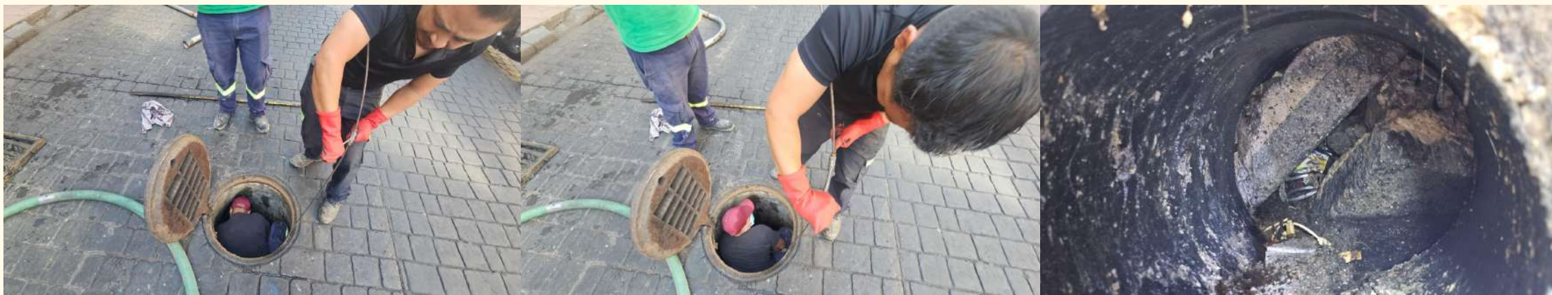
Limpieza y desazolve de una Coladera (rejillas de piso). Calle 5 de Mayo frente al.#23
