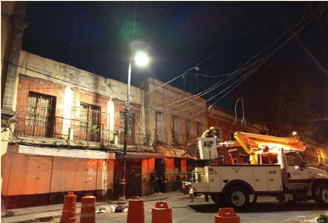
CABLEADO Y RECONEXIÓN DE LÍNEAS DE ALIMENTACIÓN
