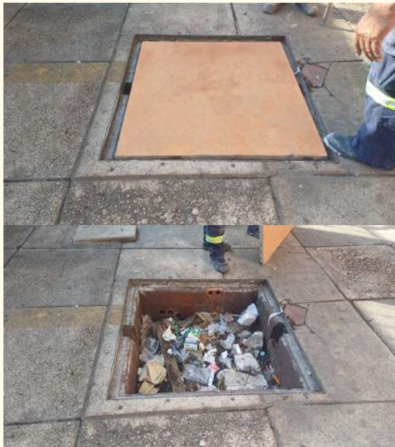
Colocación de tapa de alumbrado público Plaza de la Información entre en Av Hidalgo y calle José Badillo
