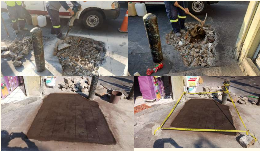
Perfilamiento del área, se hace demolición y retiro de material Calle Roldan esq Salvador
