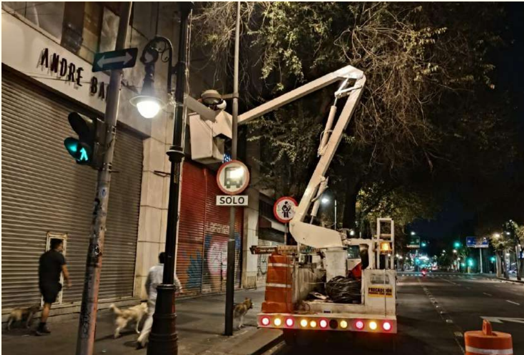
RECONEXIÓN DE LÍNEAS DE ALIMENTACIÓN
