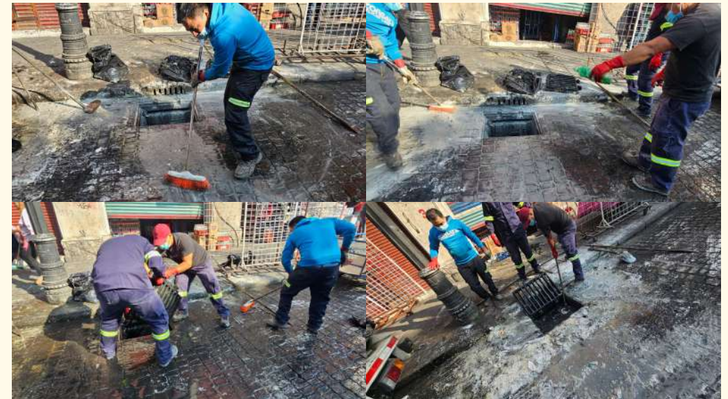
Limpieza y desazolve de cuatro Coladeras Calle República de Uruguay entre Eje 1 Oriente (Circunvalación) y 3º callejón de Manzanares
