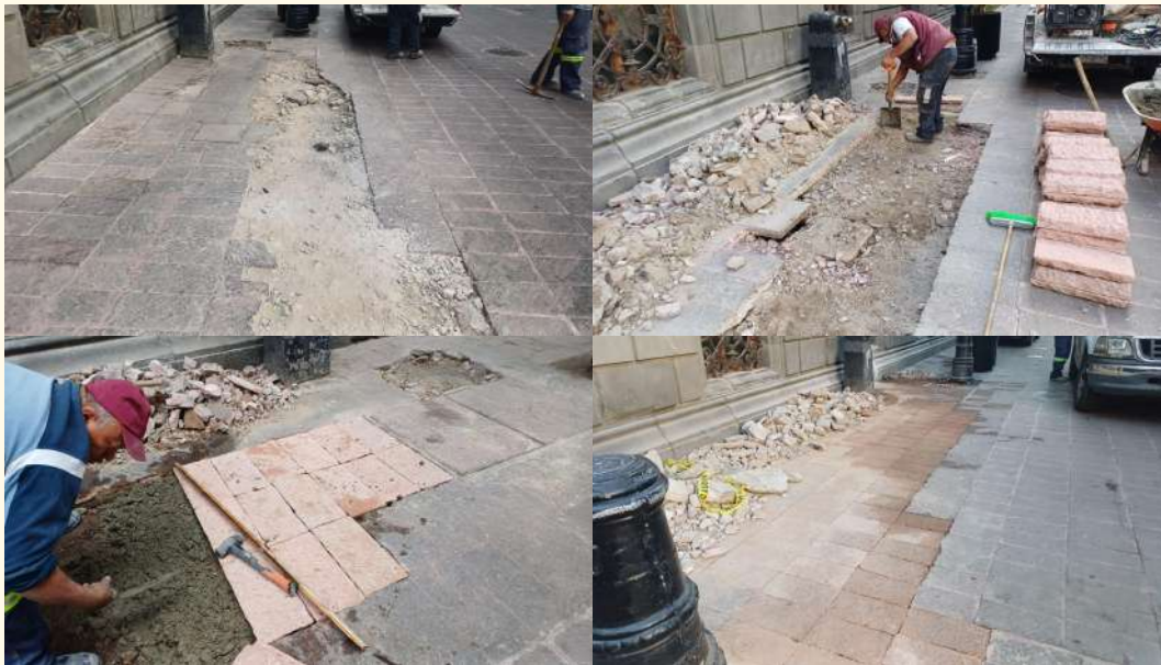
Retiro de retiró 21 losetas en mal estado y de material sobrante para alcanzar nivel, y colocación de 75 losetas Marconi entre Tacuba a Donceles
