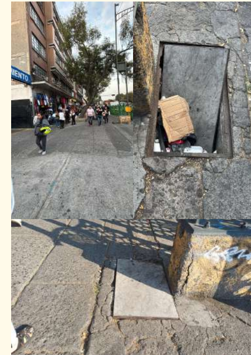
Colocacion tapa de registro en marco existente de Alumbrado Público Calle Circunvalación entre Guatemala a Zapata
