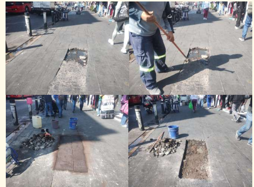
Retiro de material sobrante para alcanzar nivel y se hace colado en concreto negro estampado Calle Miguel Alemán y Circunvalación
