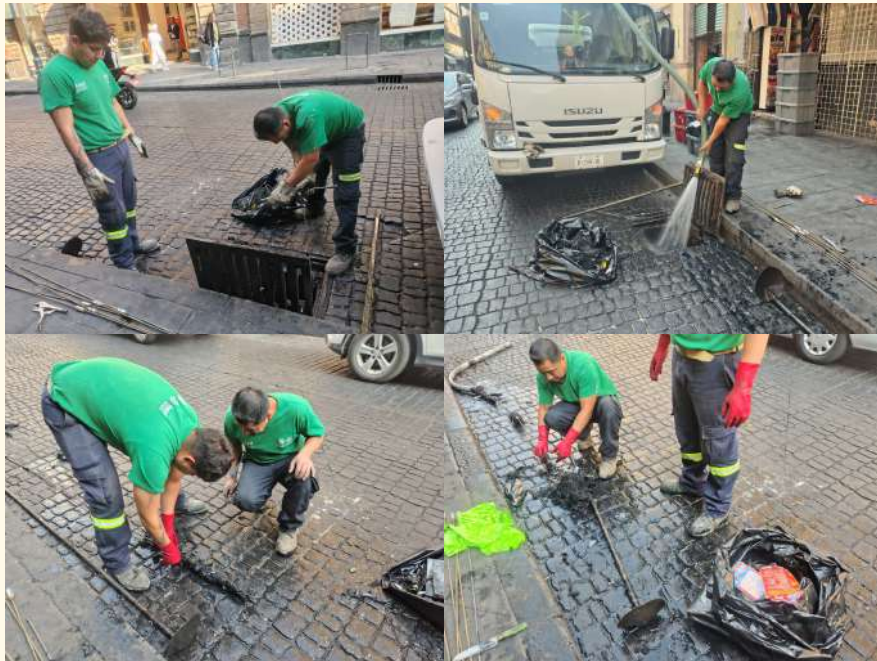
Limpieza y desazolve de una (Coladeras de rejillas de piso) Calle República de Uruguay frente al #75.
