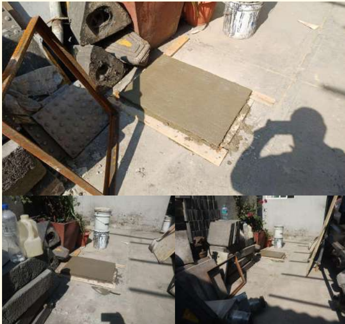
Fabricación de marco y contramarco de acero San Antonio Abad 65
