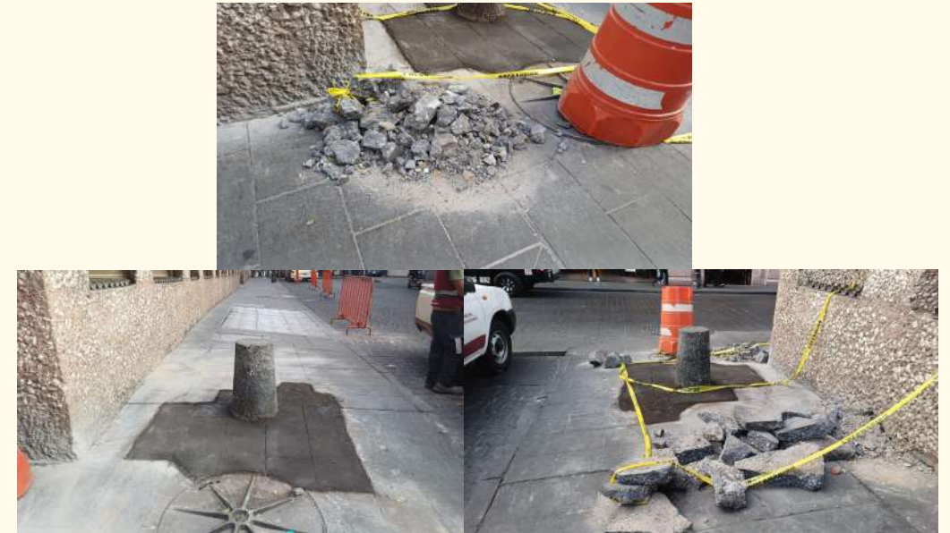
Reparación de la banqueta y retiro de cascajo Calle Palma esquina con calle Venustiano Carranza .
