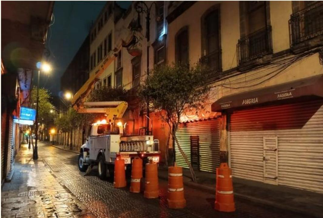
CAMBIO/INSTALACIÓN DE BALASTRO
