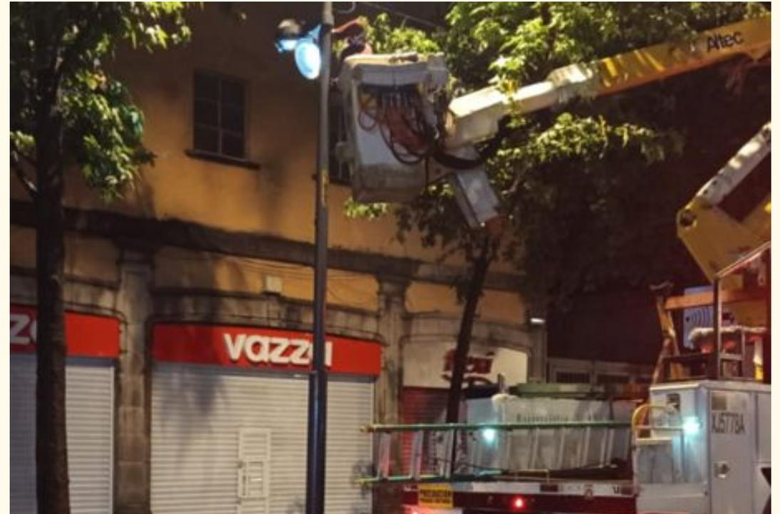
CAMBIO/INSTALACIÓN DE BALASTRO Y LÁMPARA PGZ
