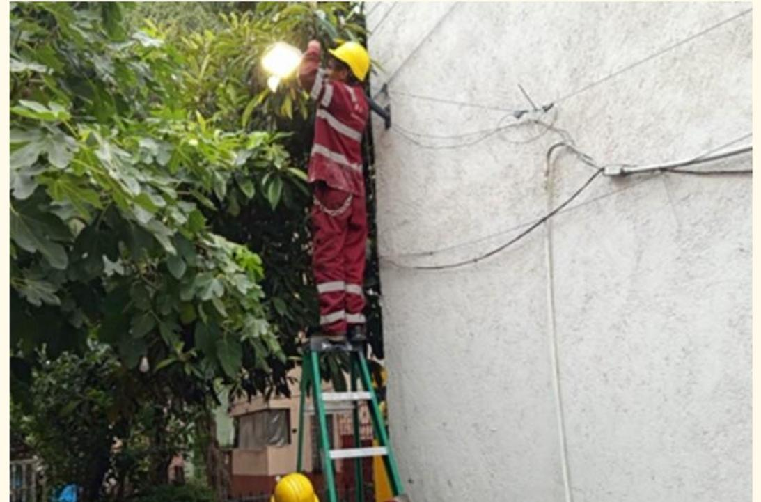
CAMBIO/INSTALACIÓN DE FOTOCELDA
