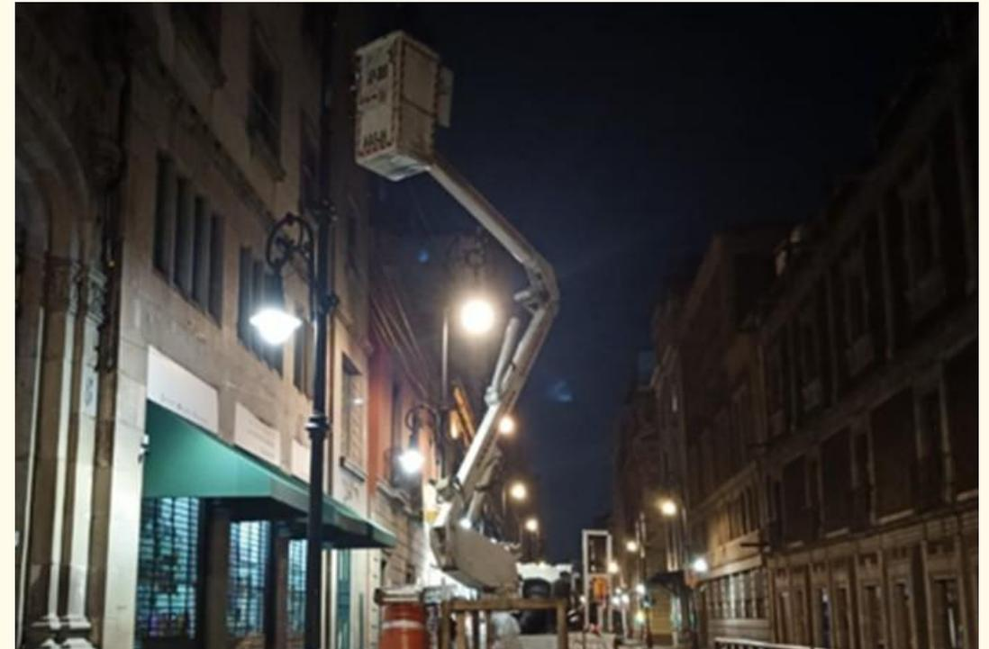
CAMBIO/INSTALACIÓN DE BALASTRO Y LÁMPARA PGZ
