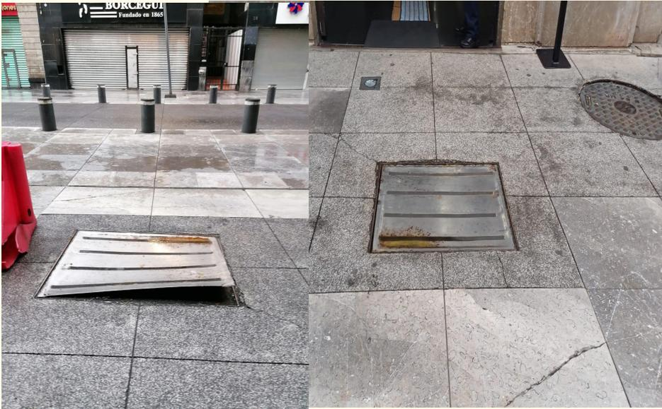
Reparación de tapa metálica
