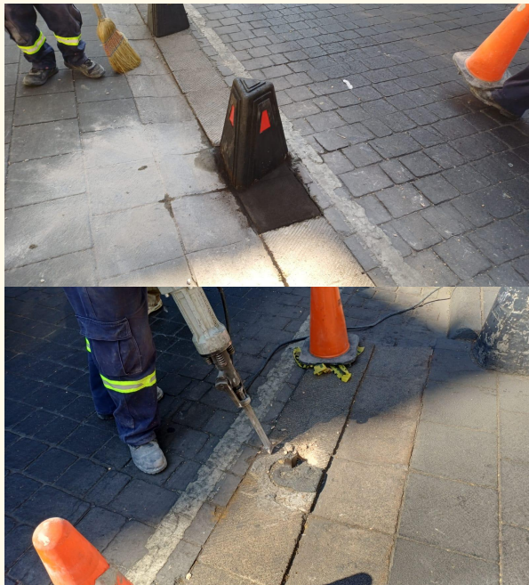
Demolición para el retiro de base de bolardo, se nivela se coloca un bolardo B. Dominguez esq Plaza la Conchita.
