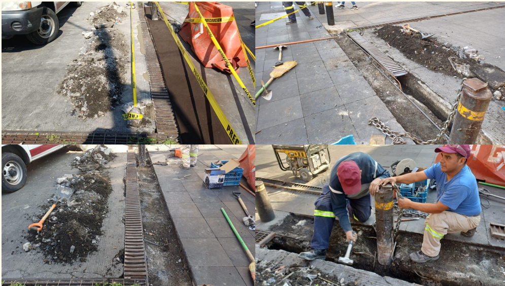
Reparación de rejilla de dren y reacomodo de Bolardo. Calle República de Argentina y calle San Ildefonso.
