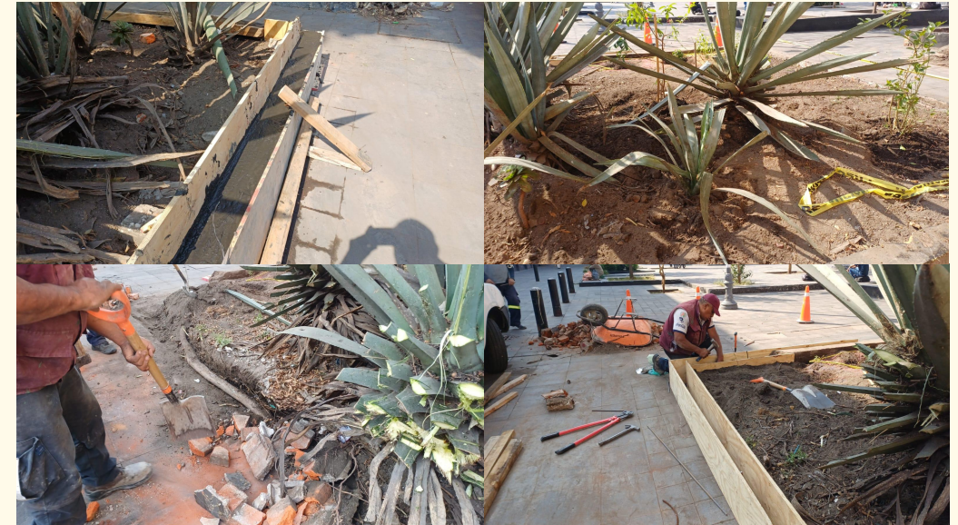
Demolición de murete de tabique rojo, rehubiucacion de magueyes, retiro de rjices y colado en concreto color negro plaza de la concepción cuepopan
