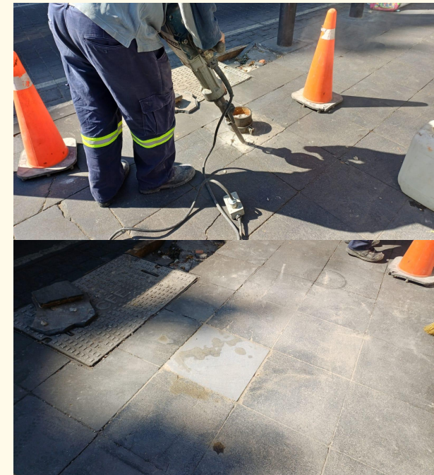
Demolición para el retiro de base metálica de bolardo y se coloca una loseta B. Dominguez esq Plaza la Conchita
