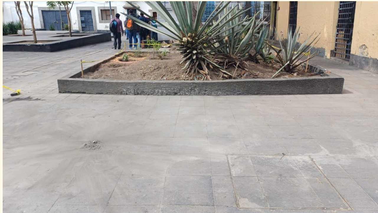
Desencofrado de concreto en jardinera Plaza La Conchita entre Perú a B. Dominguez
