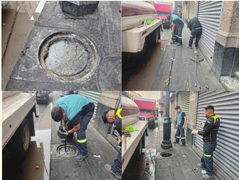
Limpieza y desazolve una coladera de Orilla de guarnición Calle República de Chile # 47
