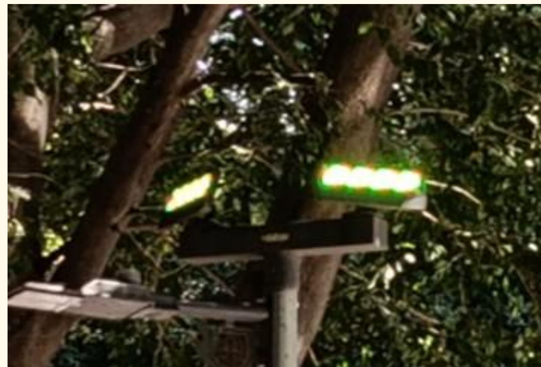
REPOSICIÓN DE CABLE
