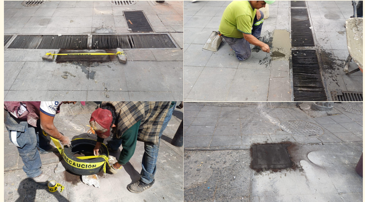
Retiro de base de bolardo se realiza colado en color negro estampado Plaza La Conchita entre Perú a B. Dominguez
