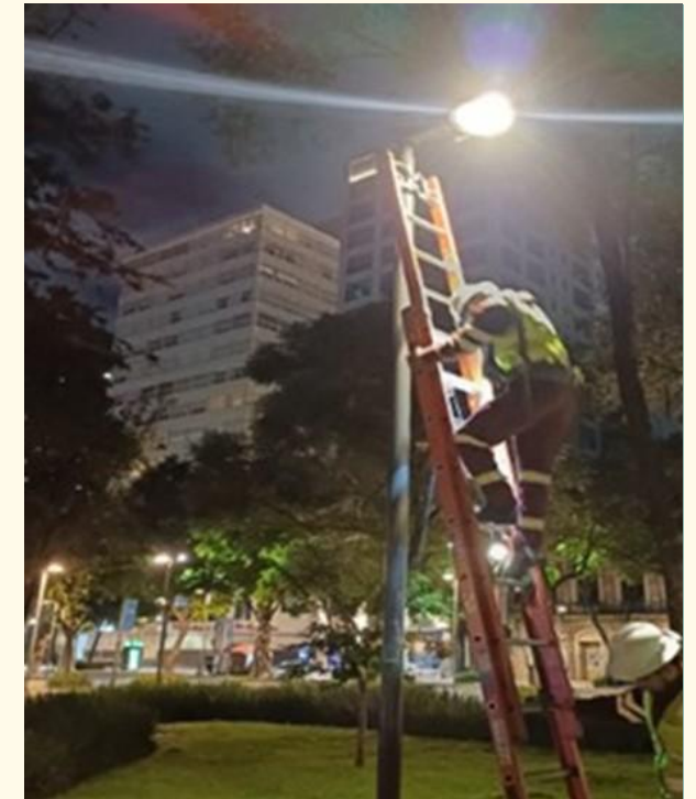
CAMBIO DE BALASTRO
