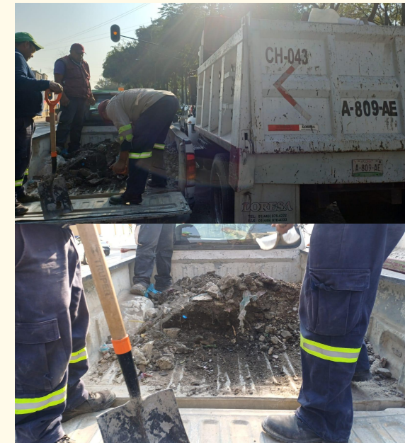
Se carga material producto de las obras San Antonio Abad 65 a la Ciudadela
