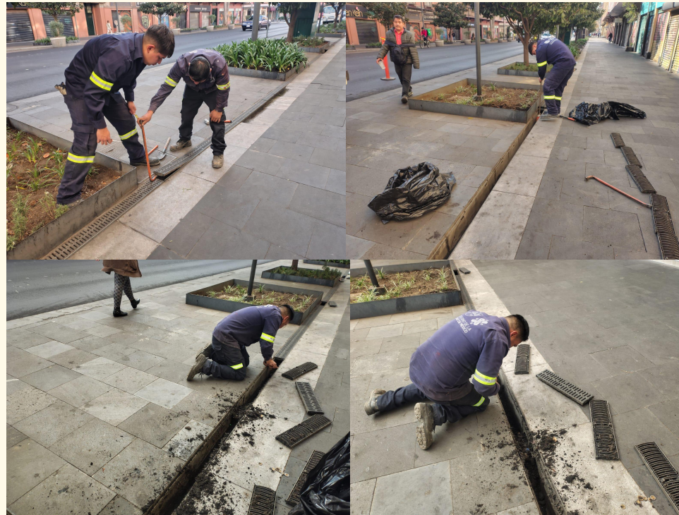
limpieza y desazolve en dren Pluvial Av. 20 de Noviembre entre calle Regina y calle Mesones
