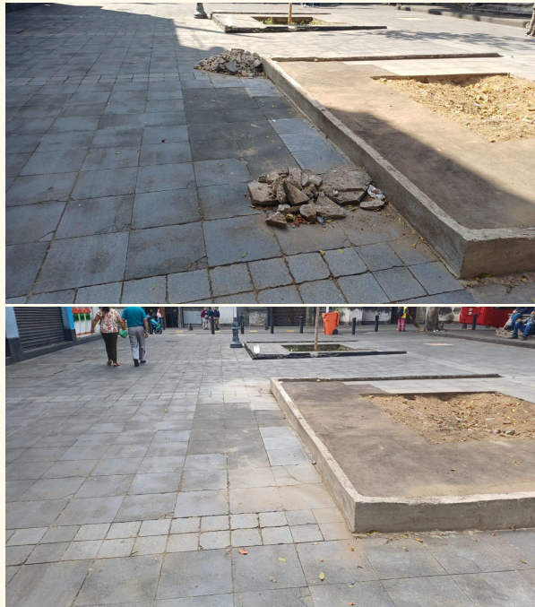
Retiro loseta en mal estado de dren y se colocan 2 losetas Plaza Empedradillo entre Guatemala a Plaza de la Constitución
