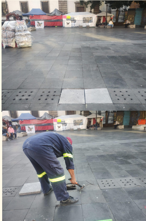
sustitución de 2 pzas. De losetas de recinto natural Plaza Empedradillo
