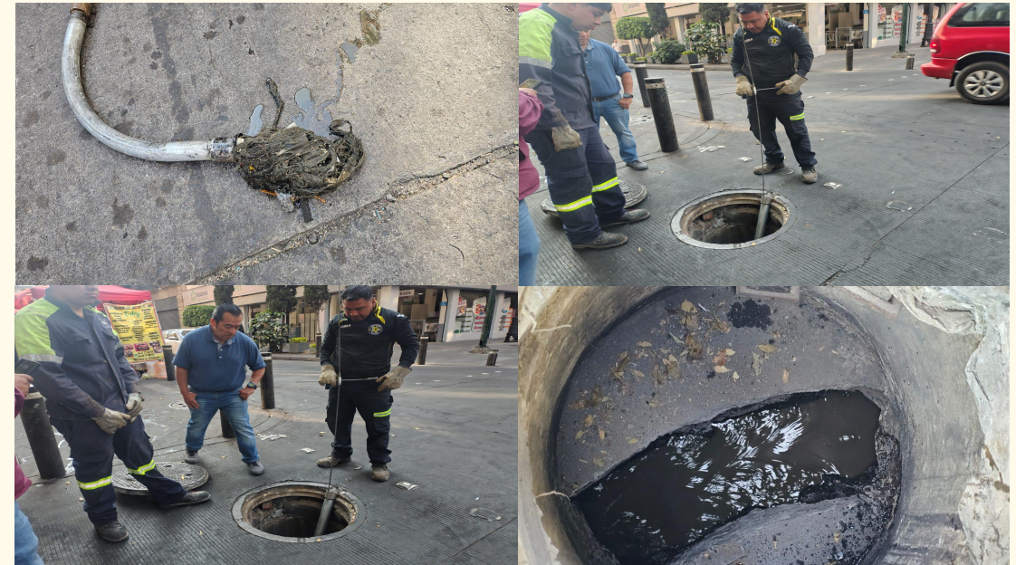
Limpieza y desazolve de tres pozos de visita Calle Palma entre calle Belisario Domínguez y calle República de Cuba.
