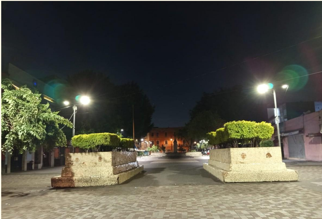
RECONEXIÓN DE LÍNEAS DE ALIMENTACIÓN
