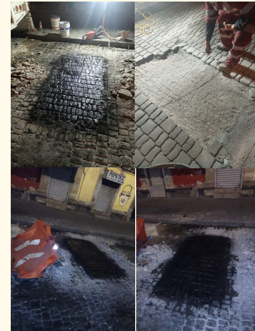
Reparación de bache ??????????
