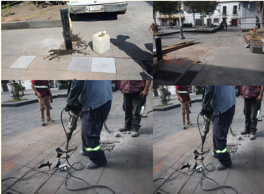
Demolicion y excavacion para colocar bolardo, retiro y colocación de 3 losetas Plaza La Conchita entre Perú a B. Dominguez
