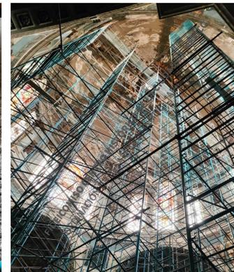
**ANÁLISIS PARA FORMULAR PROPUESTA DE BANDAS DE REFORZAMIENTO EN CÚPULA. ARMADO DE ANDAMIAJE EXTERNO. LIBERACIÓN DE APLANADOS EN GRIETAS DE MURO ORIENTE. ARMADO DE ANDAMIAJE INTERNO.**
