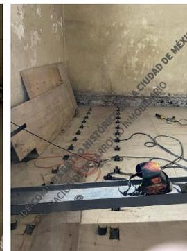
**APUNTALAMIENTO DE ENTREPISOS CON ESTRUCTURAS METALICAS Y VIGAS DE ARRASTE. SE CONTINÚAN LOS TRABAJOS DE LIBERACIÓN DE APLANADOS EN MUROS A LO LARGO DE LAS GRIETAS. SE CONTINÚAN LOS TRABAJOS DE REINTEGRACIÓN DE ENTREPISO DE PLANTA BAJA-PRIMER NIVEL, MEDIANTE LA COLOCACIÓN DE CIMBRAPLAY, MEMBRANA ASFÁLTICA, MALLA ELECTROSOLDADA Y CAPA DE COMPRESIÓN DE CONCRETO.**
