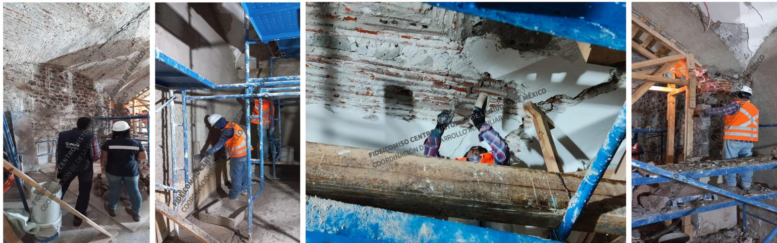
Trabajos en Sacristía del templo: Verificación de procesos y avances con supervisión de la CNMH-INAH, reintegración de aplanados de cal arena en muros y pilastras, liberación de aplanados en intradós de bóvedas y arcos; así como el remamposteo de pilastras con piedras de tezontle sano de mayor tamaño al encontrado originalmente.
