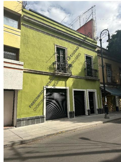
Intervención finalizada con la aplicación de pintura a la cal, según muestra autorizada por la supervisión técnica del INAH.
