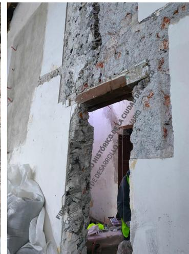
TRABAJOS DE EXPLORACIÓN Y LIBERACIÓN DE GRIETAS POR MÉTODOS MANUALES. LIBERACIÓN DE APLANADOS EN MUROS DE MAMPOSTERÍA MIXTA DE TABIQUE, TEZONTLE Y PIEDRA BRAZA PARA SU POSTERIOR CONSOLIDACIÓN MEDIANTE REMAMPOSTEO Y GRAPAS. TRABAJOS DE EXCAVACIÓN EN CALAS PARA ESTUDIO DE SUELO, SIN ENCONTRAR HALLAZGOS ARQUEOLÓGICOS. SE CERRARÁ VANO EXISTENTE MEDIANTE REMAMPOSTEO PARA SUSTITUIRLO POSTERIORMENTE EN MURO DE MAMPOSTERÍA DEL EJE F.
