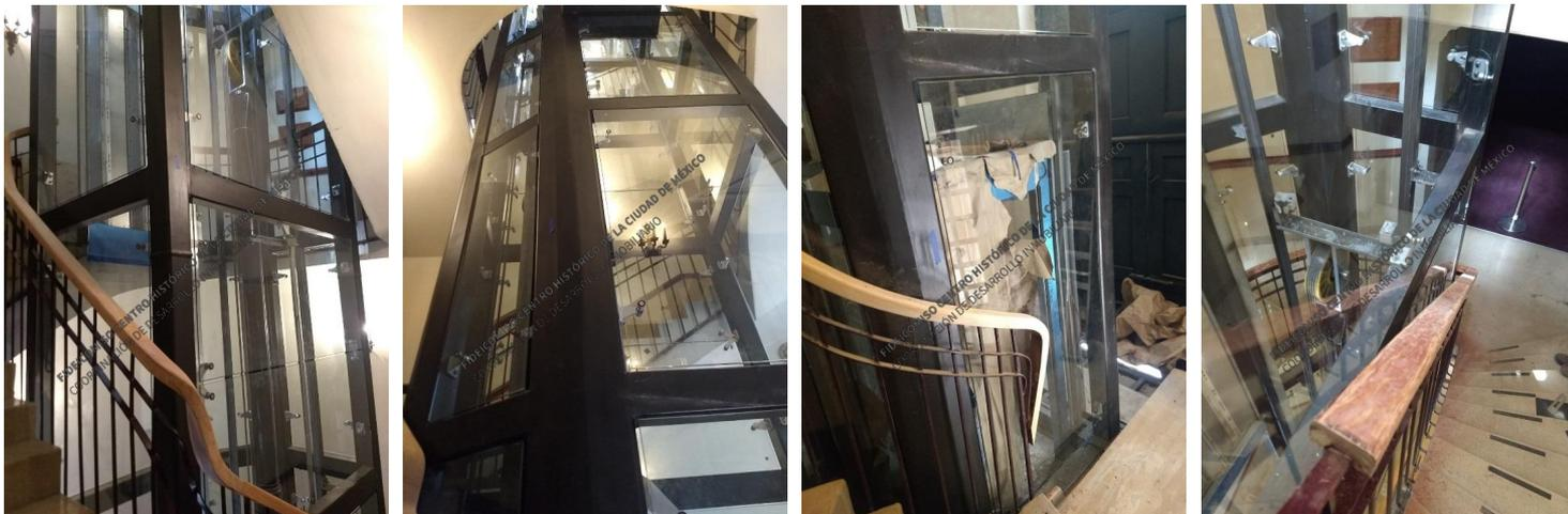
Colocación de revestimiento de vidrio templado y detallado de estructura principal.
