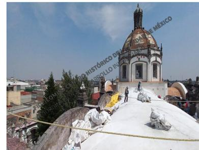
Trabajos en extrados de bóveda principal: Apertura de caja y colocación de grapas de recinto en grietas del tercer entre eje, remamposteos e inyecciones de lechada de cal sobre grietas del tercer entre eje, liberación de las dos capas de entortados deteriorados existentes, reintegración de entortado a base de mezcla de cal arena para re geometrizar el extrados de la nave principal y remamposteos de arcos botareles utilizando elementos de mayor granulometría que los originales.
