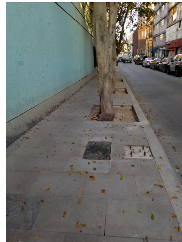
(ATENDIDO) Postes de alumbrado público.
