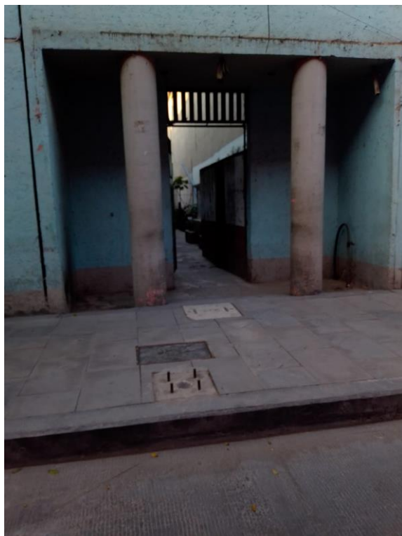
(ATENDIDO) colocación de tapa de registro
