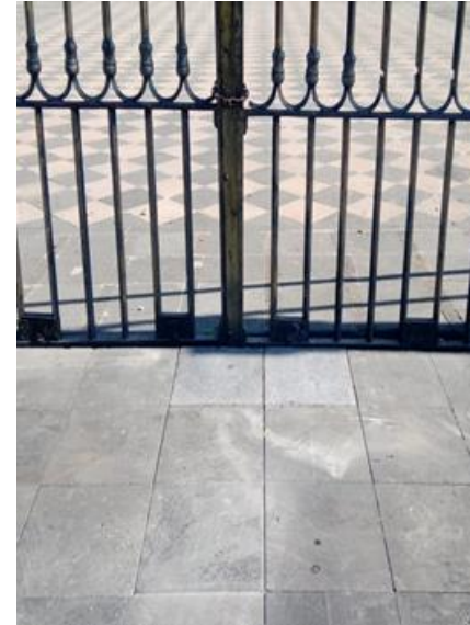
Colocación de loseta
