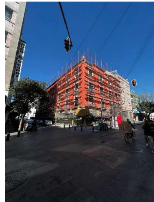
República de Paraguay No. 44. Aplicación de pintura a la cal.
