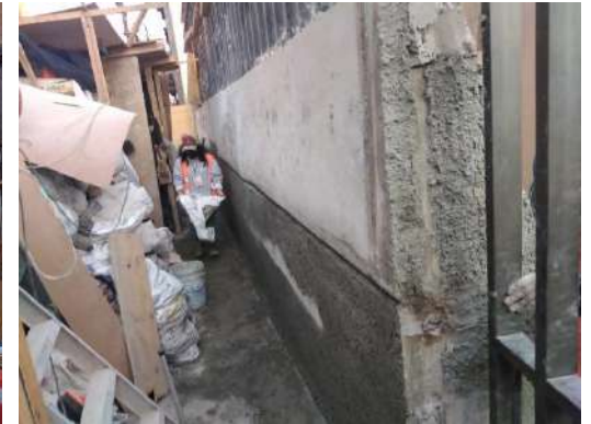
Descimbrado y aparentado de basamento en tramo 1.
