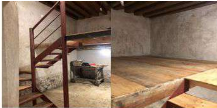
INTEGRACIÓN DE ESCALERA METALICA Y TAPANCO
