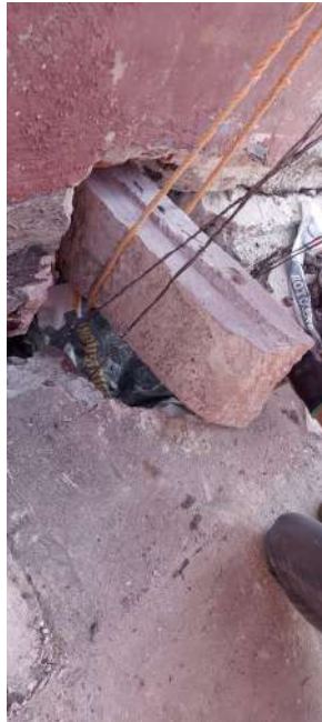
Trabajos de consolidación en fracturas en unión entre tambor y bóveda.
