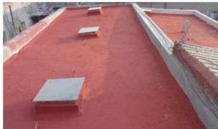
IMPERMEABILIZACIÓN Y COLOCACIÓN DE DOMOS EN CUBIERTA
