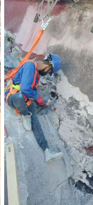
Trabajos de consolidación en extradós de bóveda.
