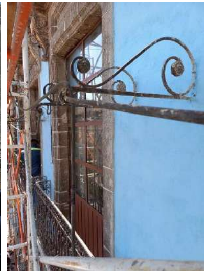
República de Brasil No.62. Tratamiento de herreras, re junteo en marcos de cantera y aplicación de pintura a la cal.
