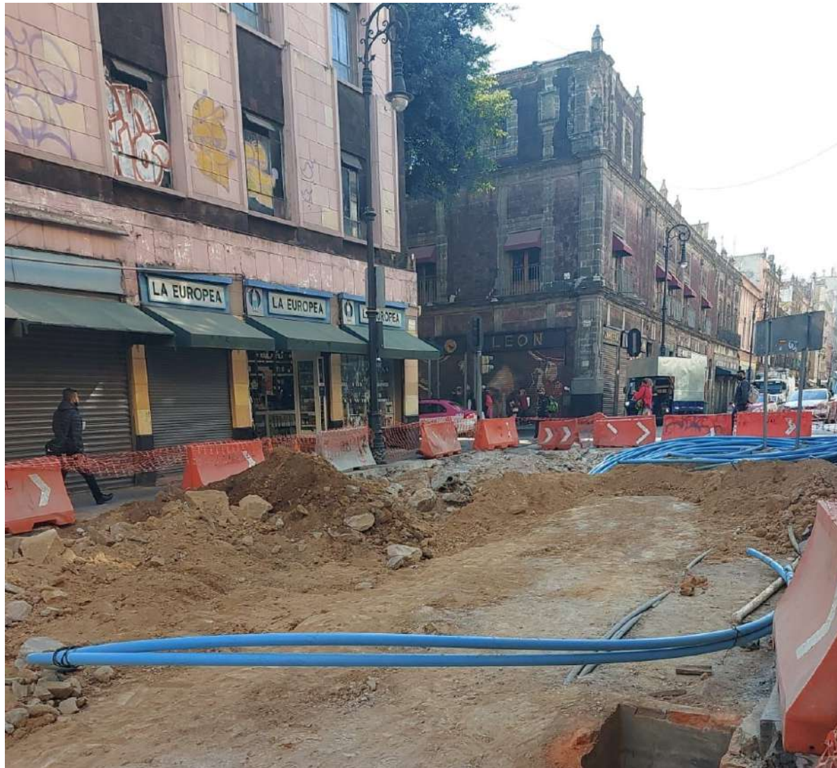
Continúan acciones de obra inducida de instalaciones de media y baja tensión, colocación de mr-45 en arroyo vehicular. Se colocan acabados y tapas de accesorios en zonas de mayor avance
