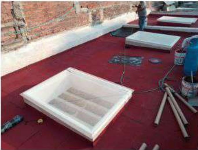
COLOCACIÓN DE DOMOS E IMPERMEABILIZACIÓN DE CUBIERTAS
