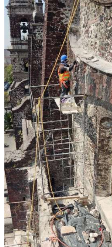
Trabajos de consolidación de grietas en exterior de muros.
