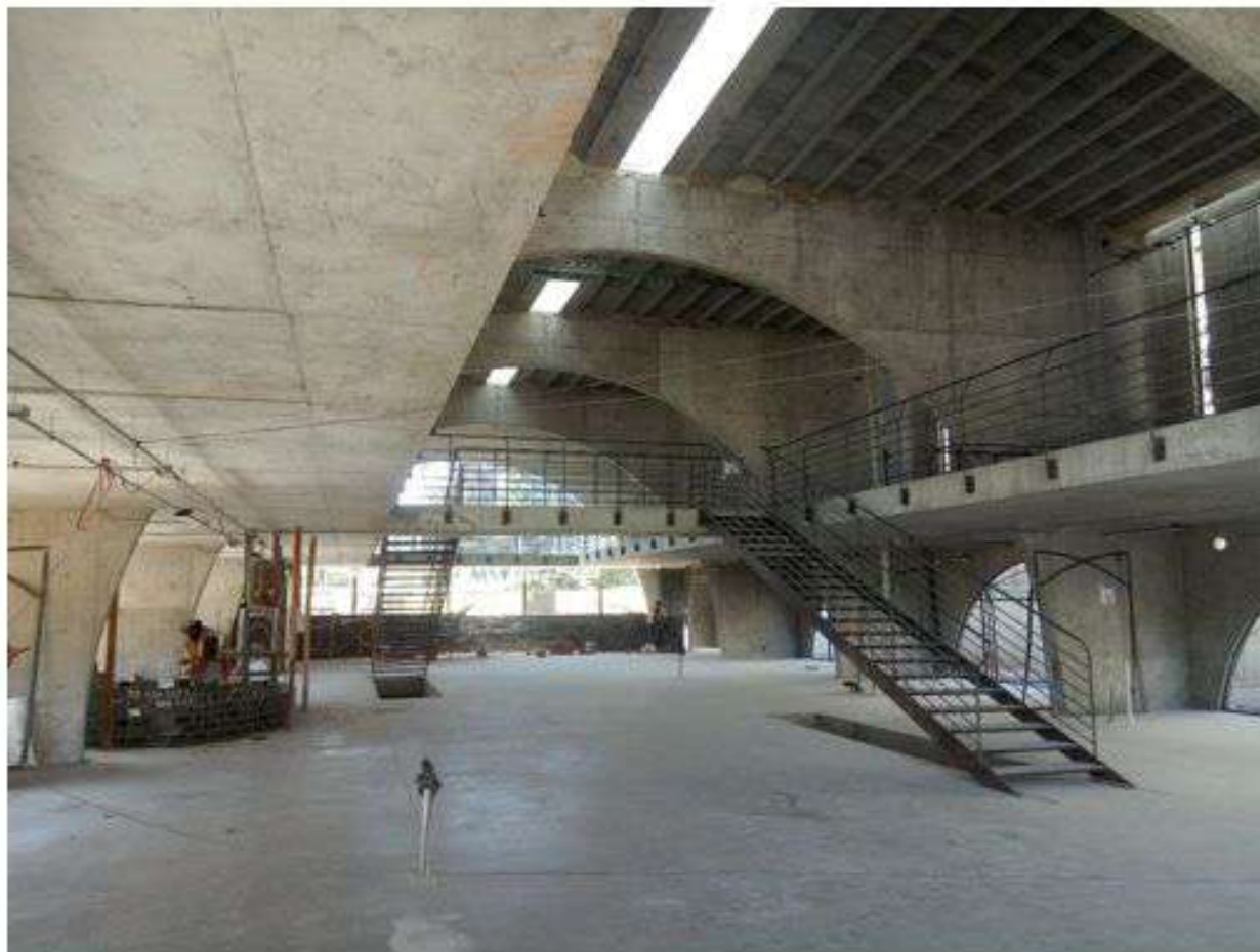
VISTA INTERIOR PLANTA BAJA DEL EDIFICIO
