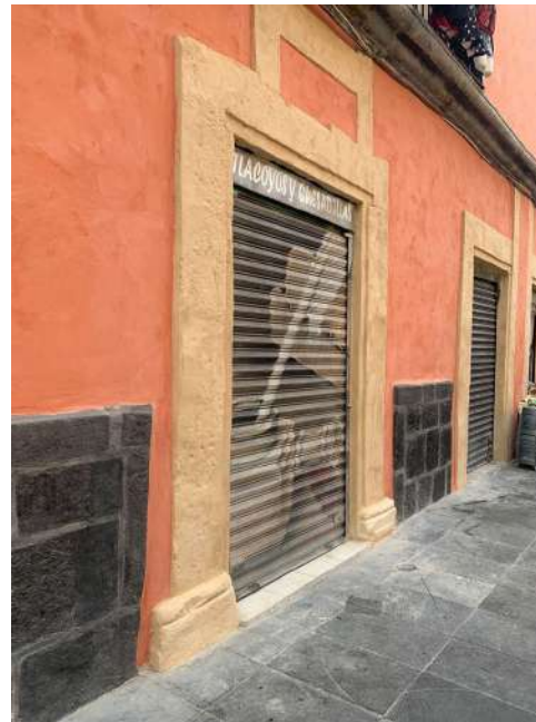
República de Brasil No. 29. Aplicación de pintura a la cal.
