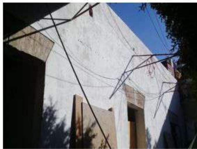
PINTURA DE FACHADAS DE LAS VIVIENDAS
