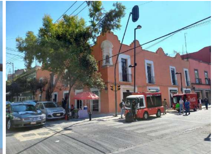
República de Ecuador No. 95. Aplicación de pintura a la cal.
