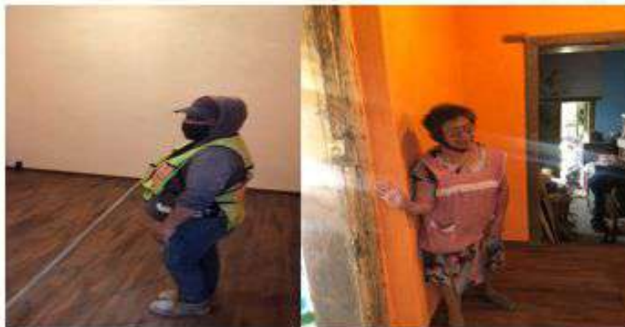
PINTURA DE MUROS Y COLOCACIÓN DE PISO LAMINADO
