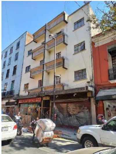
República de Brasil No.63. Aplicación de pintura vinílica.
