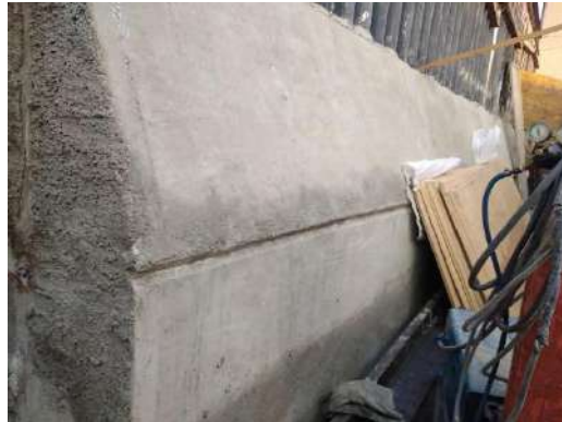
Descimbrado y aparentado para basamento piramidal en primer tramo.
