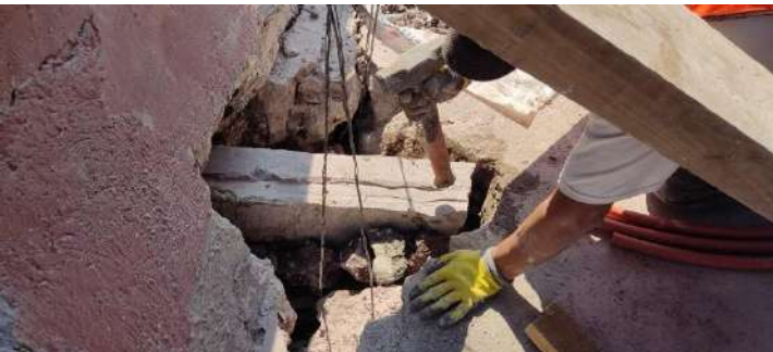
Trabajos de consolidación en fracturas en unión entre tambor y bóveda.
