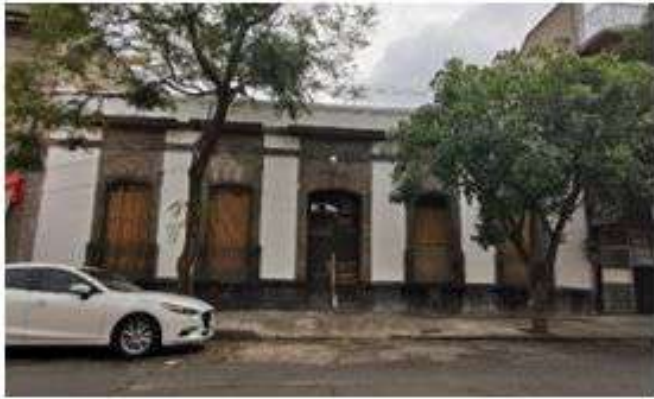
LIMPIEZA DE CANTERA Y PINTURA EN FACHADA
