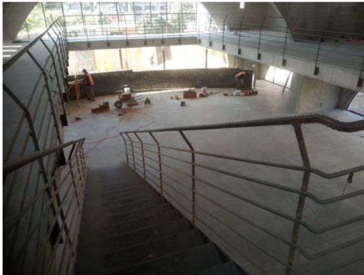
VISTA INTERIOR NIVEL PRIMERO DEL EDIFICIO
