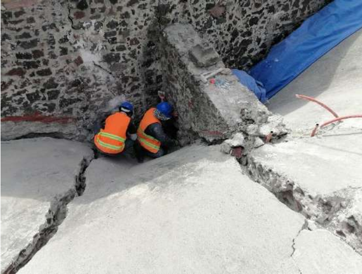
Consolidación de bóveda.
