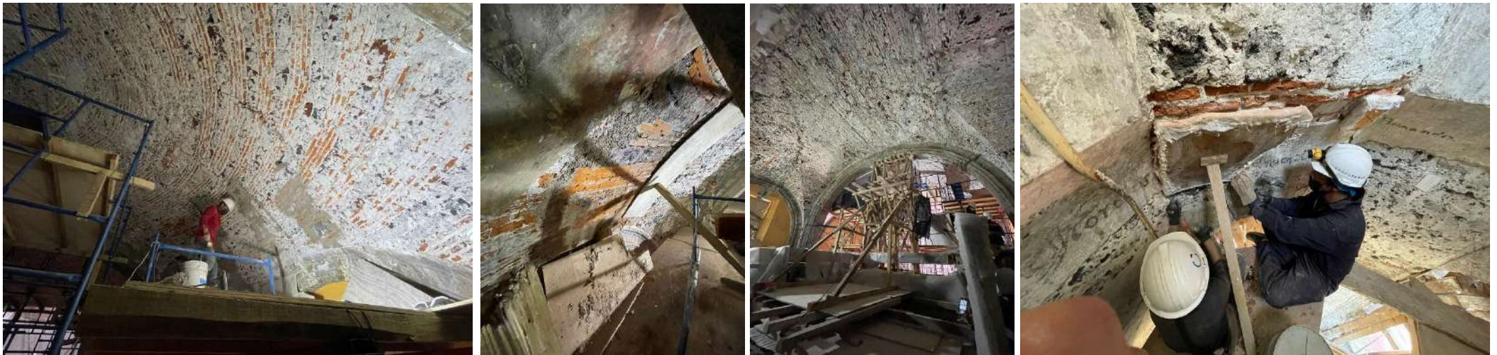
Exploración y cocido de grietas y fracturas en bóvedas.
