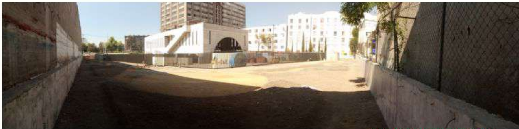
VISTA PANORAMICA NORESTE
