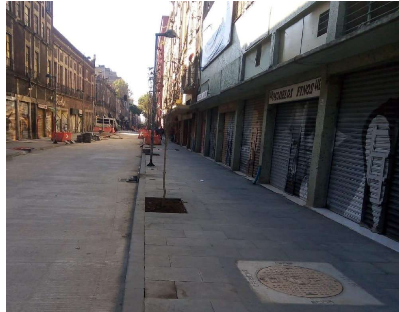
Continúan acciones de obra inducida de instalaciones de media y baja tensión, colocación de mr-45 en arroyo vehicular. Se colocan acabados y tapas de accesorios en zonas de mayor avance
