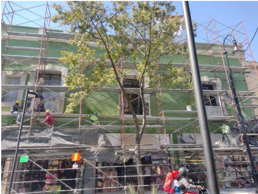
República de Brasil No. 46. Aplicación de pintura a la cal.
