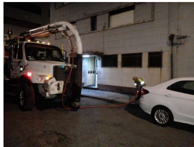
Desazolve de atarjea y coladeras pluviales en el callejón de Tizapán e Igualdad
