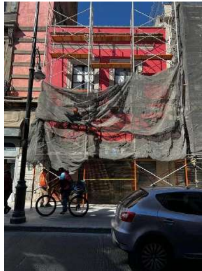
República de Brasil No.44. Aplicación de pintura a la cal.
