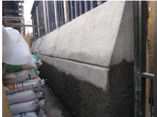
Descimbrado y aparentado para basamento piramidal en primer tramo.
