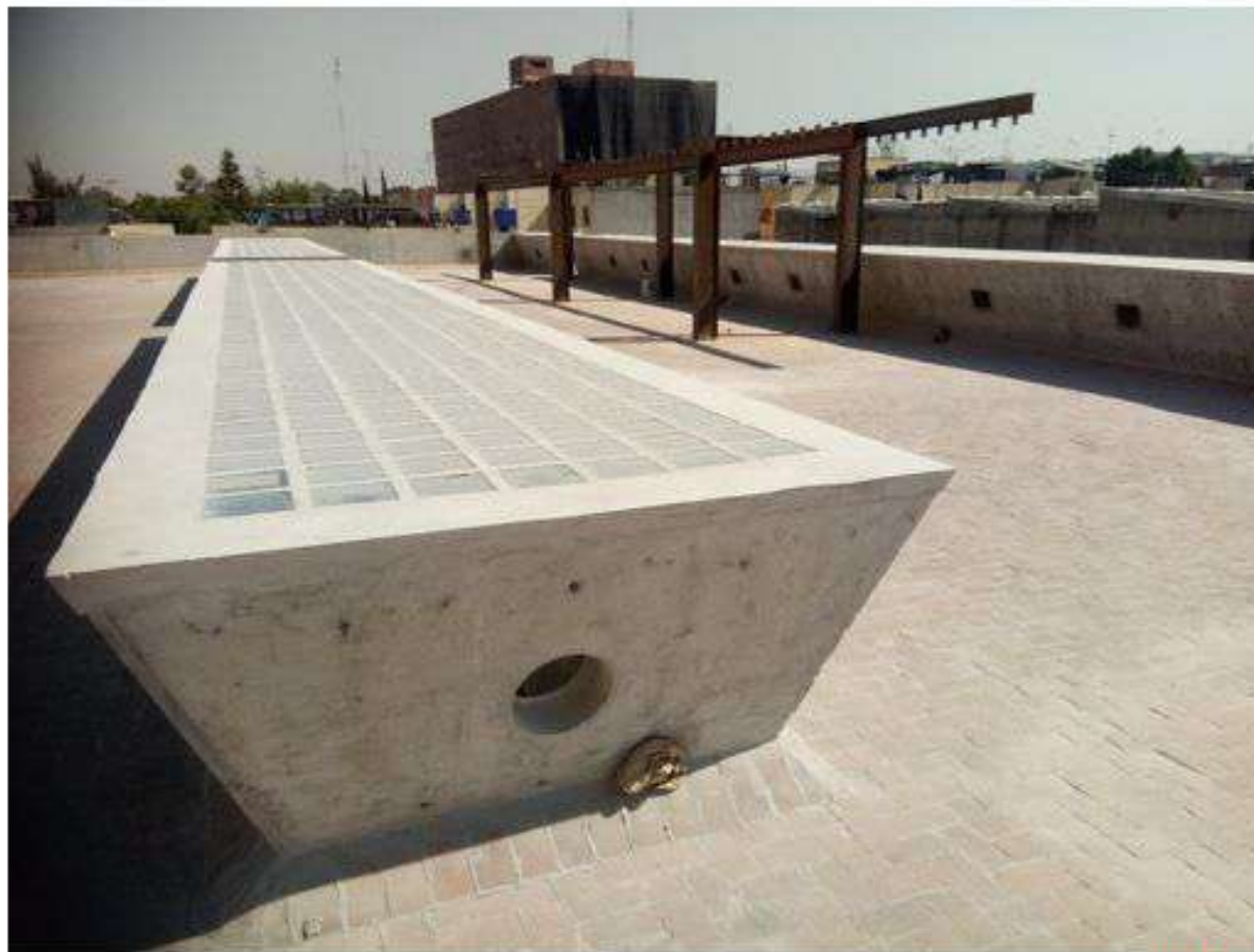
VISTA NIVEL AZOTEA DEL EDIFICIO
