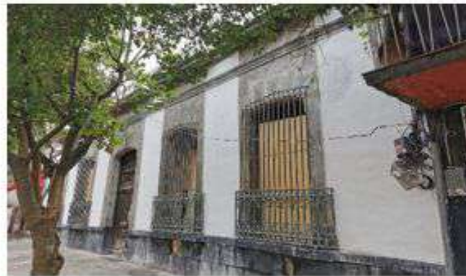
LIMPIEZA DE CANTERA Y PINTURA EN FACHADA
