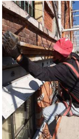
República de Brasil No.64. Tratamiento integral de elementos metálicos.
