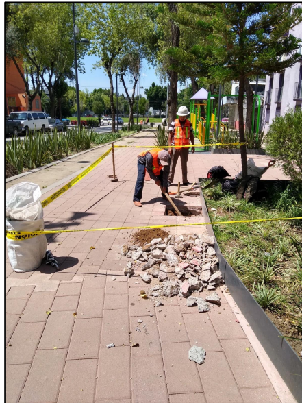
Estela para corredor peatonal- Trabajos de excavación para alojar cimiento de anclaje. Calle Violeta esquina con Galeana, Colonia Guerrero.
