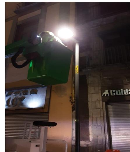
SE REALIZA CAMBIO DE BALASTRO/LÁMPARA/SOQUET .
