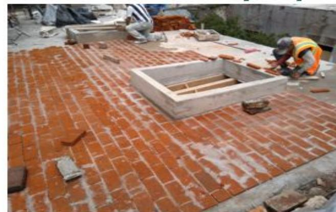
REINTEGRACIÓN DE ENLADRILLADO DE CUBIERTA
