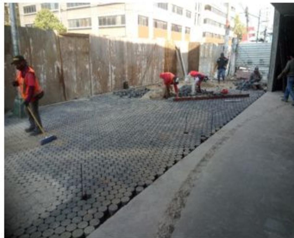
**COLOCACIÓN DE PISO DE ADOCRETO CIRCULAR NEGRO DE 10 CM. DE ESPESOR Y 10 CM. DE DIÁMETRO EN PLAZA (EJES 6-7/A-D)**
