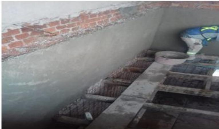
REINTEGRACIÓN DE APLANADOS EN MUROS REFORZADOA CON MALLA ELÉCTROSOLDADA
