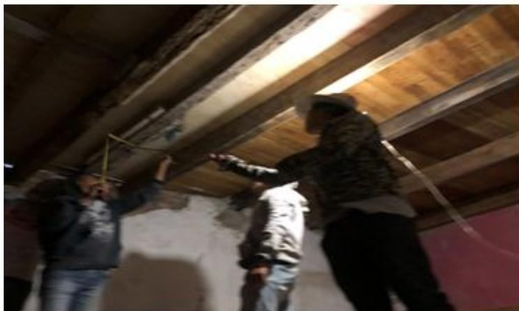
LIMPIEZA DE VIGAS EXISTENTES Y APLICACIÓN DE PRESERVADOR DE MADERA
