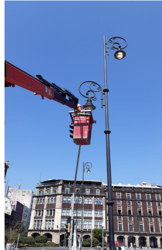
SE REALIZA CAMBIO DE LÁMPARA Y BALASTRO.
