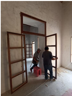
Recuperación y tratamiento de cancelerías de madera.
