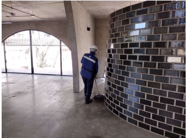
TRABAJOS DE LIMPIEZA
