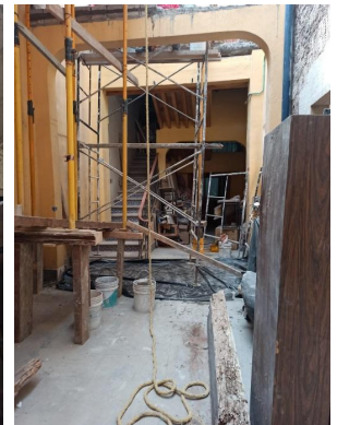
Apuntalamientos para proceso de reintegración de vigas de madera.
