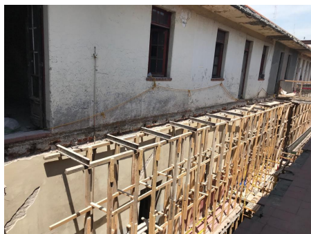
Liberación de pasillo central en segundo nivel.
