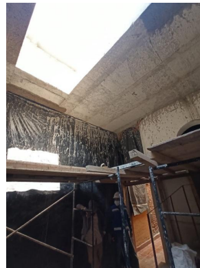
Reintegración de cubierta por medio de sistema de losa a base de vigueta y bovedilla.
