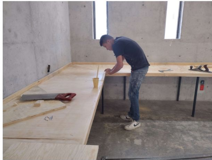
TRABAJO DE COLOCACIÓN, LIJADO, RESANADO Y SELLADO DE TAPAS DE MADERA PARA MESAS DE CIBERESCUELA
