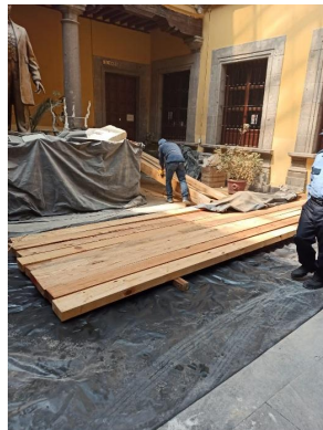
Preparación de vigas para reintegración en sistema de entresijo.
