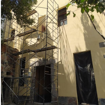
Aplicación de pintura a la cal en fachadas de patios interiores.
