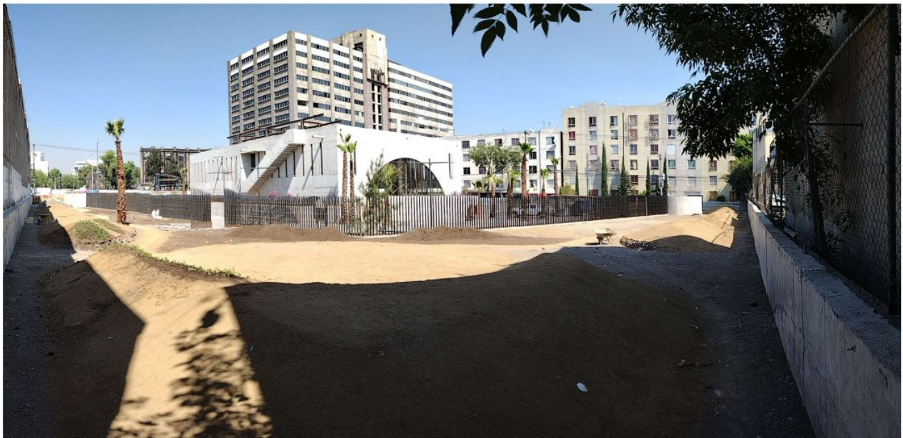
VISTA PANORAMICA NORESTE
