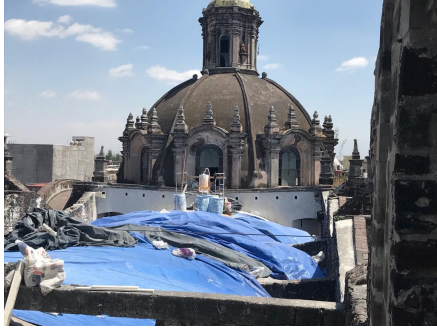
Integración de capa de compresión en extradós de bóveda.
