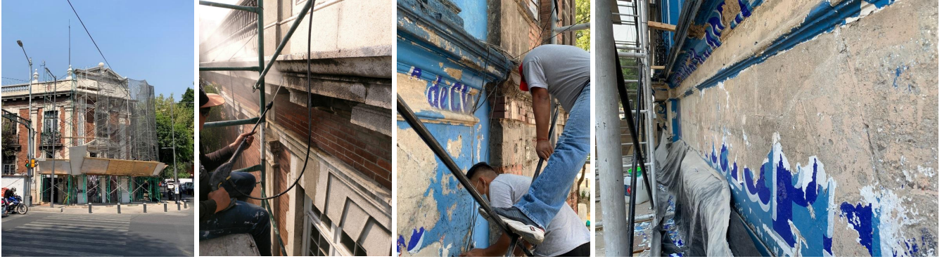
Colocación de andamios y limpiezas de elementos de piedra natural y prefabricados.
