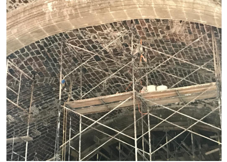
Inyecciones para consolidación de intradós de bóveda.
