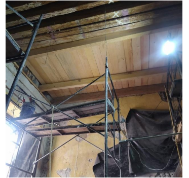
Reposición de Tablado y Vigas de entresijo.
