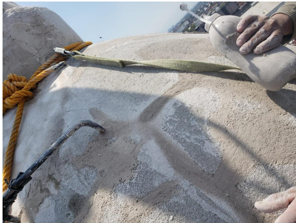
Trabajos de consolidación de cupulín.
