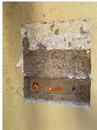
Realización de calas para identificación de fábricas en muros y posibles zonas con pintura mural.
