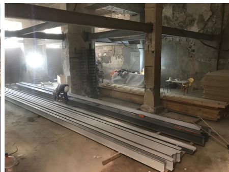
Habilitado de acero para entrepisos.
