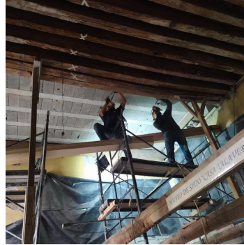
Retiro de Tablado y Vigas de madera de entresijo en estado de deterioro avanzado.
