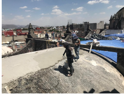
Integración de capa de compresión en extradós de bóveda.
