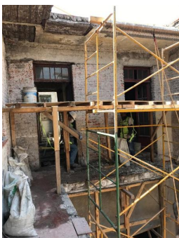
Consolidación de grietas y muros en segundo nivel.
