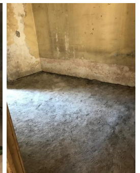
Liberación de duelas en segundo nivel.
