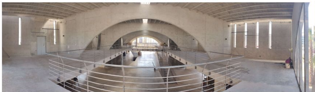
VISTA PANORAMICA DEL PRIMER NIVEL
