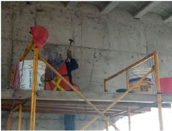
LAVADO EN MUROS DE CONCRETO ARMADO EN PRIMER NIVEL
