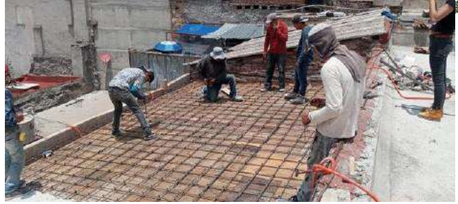
INTEGRACION DE CUBIERTA REFORZADA CON MALLA ELECTROSOLDADA
