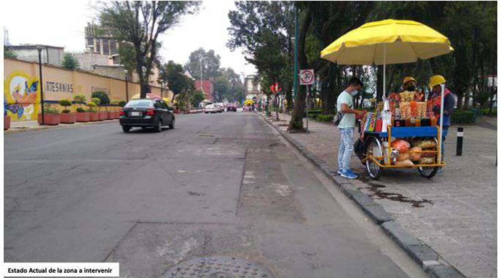
Estado Actual de la zona a intervenir
