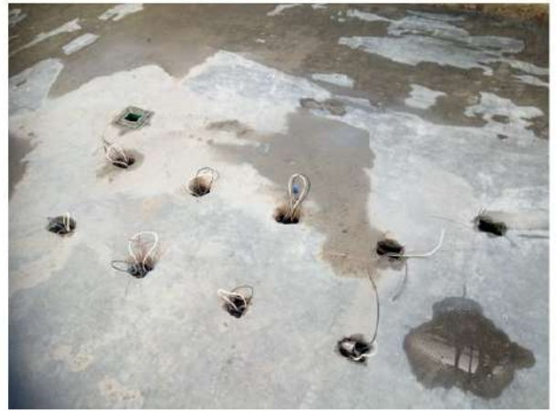
CABLEADO ELECTRICO EN CANALIZACIONES PARA CONTACTOS EN PRIMER NIVEL
