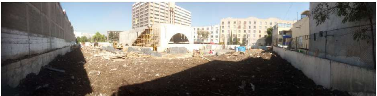
VISTA PANORAMICA NORESTE
