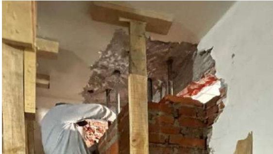
INTEGRACIÓN DE CONTRAFUERTE DE TABIQUE ROJO RECOCIDO EN PLANTA BAJA Y ALTA
