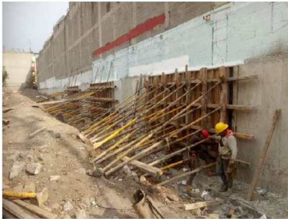
COLOCACION DE CIMBRA DE MADERA EN MURO DE COLINDANCIA (EJES F/5-6)
