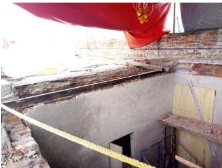
LIBERACIÓN DE CUBIERTA
