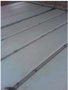
INTEGRACIÓN DE VIGETA Y BOVEDILLA E INSTALACIÓN ELECTRICA
