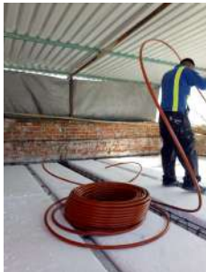
INTEGRACIÓN DE VIGETA Y BOVEDILLA E INSTALACIÓN ELECTRICA
