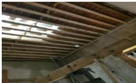
REINTEGRACIÓN DE VIGAS Y ENTABLADO, ASI COMO APLANADOS
