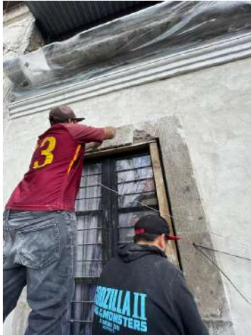
Las Cruces No. 5. Consolidación de marcos y cornisas de cantera.
