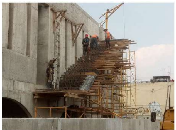
ARMADO CON ACERO DE REFUERZO PARA ESCALERA QUE CONDUCE AL NIVEL DE AZOTEA (EJES C/4-5)
