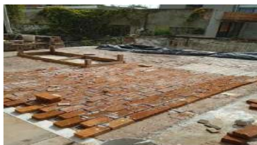
REINTEGRACIÓN DE ENLADRILLADO EN CUBIERTA
