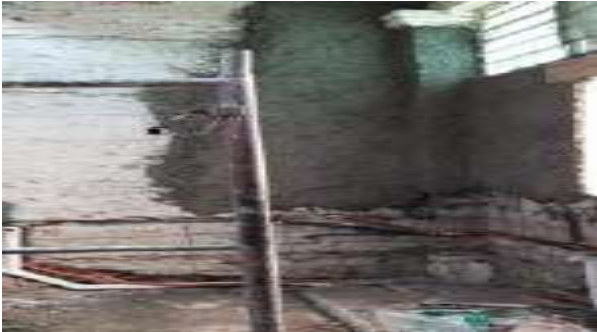
LIBERACIÓN DE APLANADOS EN MUROS Y REINTEGRACIÓN DE INSTALACIONES
