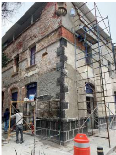
Riva Palacio No. 46-48. Reintegración de aplanados.
