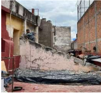
LIBERACIÓN DE CONTRAFUERTE EN PALTA ALTA
