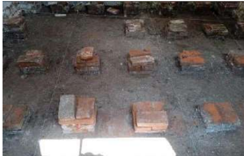
REINTEGRACIÓN DE SOPORTES PARA ENTARIMADO EN PISOS
