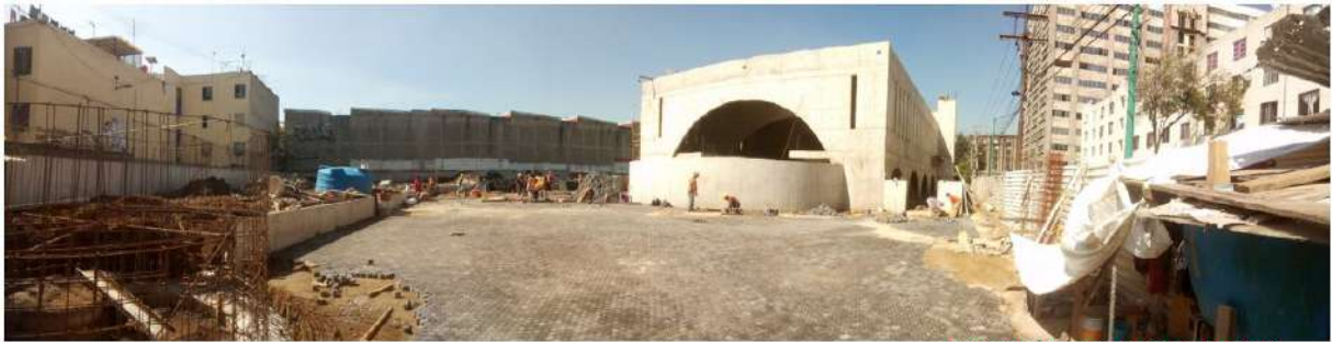
VISTA PANORAMICA SURESTE
