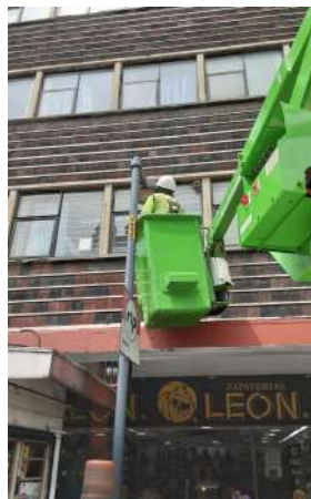
CAMBIO DE LÁMPARA Y BALASTRO / LÁMPARA APAGADA.
