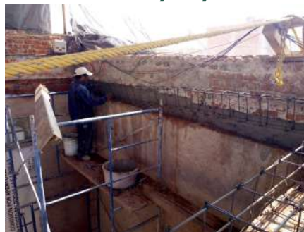
REINTEGRACIÓN DE CORONA DE CERRAMIENTO
