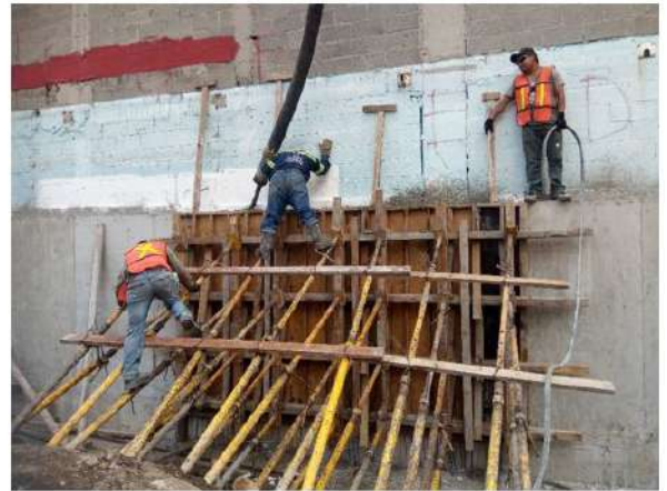
COLADO CON CONCRETO PREMEZCLADO F'c=250\text{KG}/\text{CM}2 EN MURO DE COLINDANCIA (EJES F/5-6)
