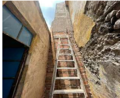
INTEGRACIÓN DE CONTRAFUERTE DE TABIQUE ROJO RECOCIDO EN PLANTA BAJA Y ALTA
