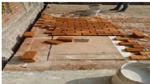
REINTEGRACIÓN DE ENLADRILLADO EN CUBIERTA
