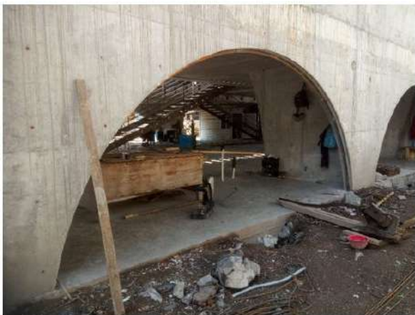
COLOCACION DE MARCOS METALICOS PARA PUERTAS P-01 Y P-02 DE LA PLANTA BAJA (EJES B/1-6 Y C/1-6)
