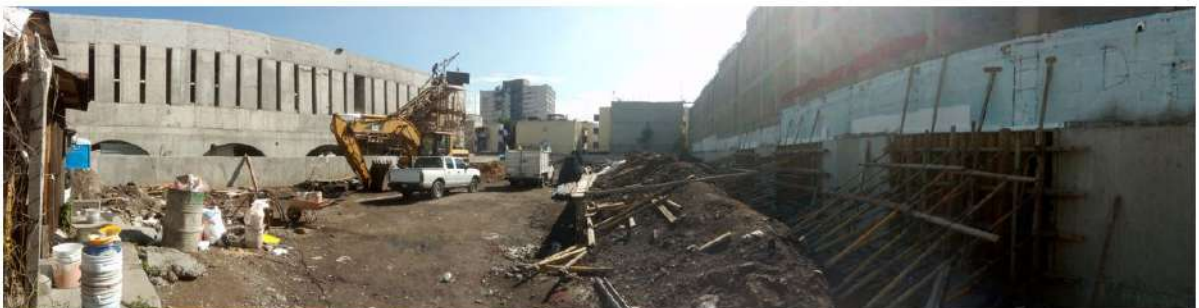
VISTA PANORAMICA NOROESTE
