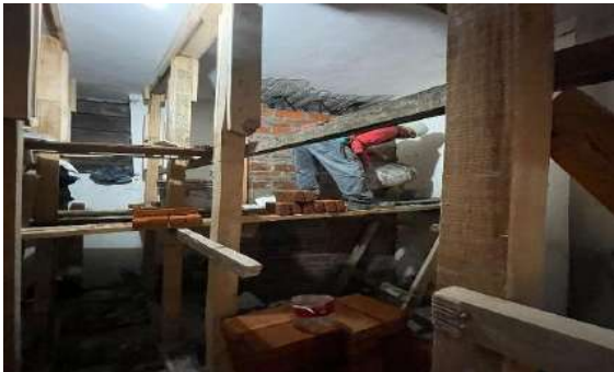
INTEGRACIÓN DE CONTRAFUERTE DE TABIQUE ROJO RECOCIDO ASENTADOS CON CEMENTO- CAL- ARENA
