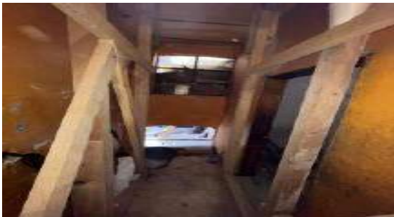
LIBERACIÓN DE MUROS DONDE SE INTEGRARÁN LOS CONTRAFUERTE EN PLANTA ALTA
