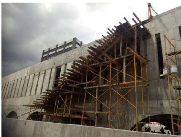
COLOCACION DE CIMBRA Y APUNTALAMIENTO PARA ESCALERA QUE CONDUCE AL NIVEL DE AZOTEA (EJES C/4-5)
