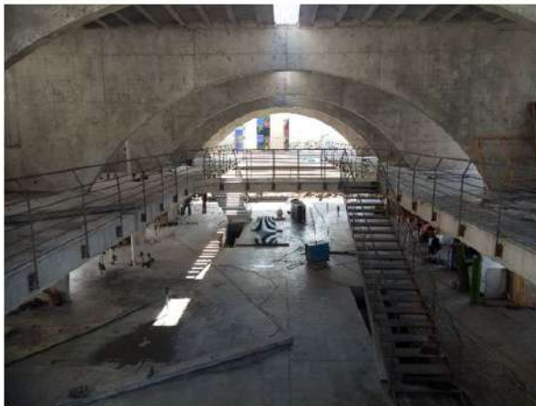
FABRICACION DE BARANDAL DE HERRERÍA H-02 Y H-03 DE 1.43 M. DE DESARROLLO EN PRIMER NIVEL (A BASE DE POSTES, PASAMANOS Y PROTECCIONES HORIZONTRALES DE VARILLA CORRUGADA)
