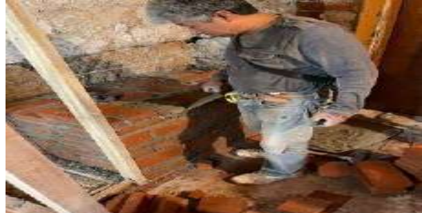
INTEGRACIÓN DE CONTRAFUERTE DE TABIQUE ROJO RECOCIDO ASENTADOS CON CEMENTO- CAL- ARENA
