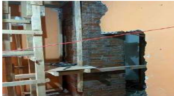
INTEGRACIÓN DE CONTRAFUERTE DE TABIQUE ROJO RECOCIDO ASENTADOS CON CEMENTO- CAL- ARENA
