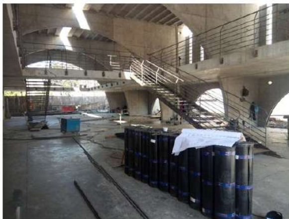
COLOCACION DE ALFARDAS, ESCALONES Y BARANDALES METALICOS DE LAS 2 ESCALERAS INTERIORES DE LA PLANTA BAJA (EJES B/4-5 Y C/2-3)
