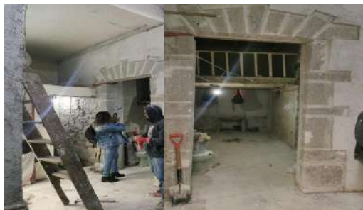
LIMPIEZA DE CANTERA
