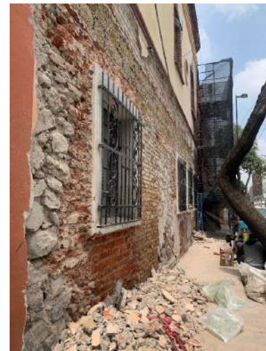
Riva Palacio No. 52. Liberación de aplanado incompatible con fábrica original.
