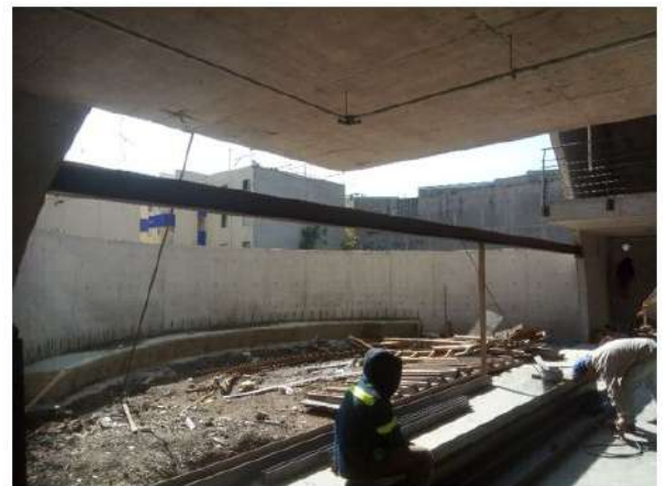
COLOCACION DE VIGA Y MARCOS METALICOS PARA CANCEL C-02 DE LA P.B.-1N (EJE 6/B-C)
