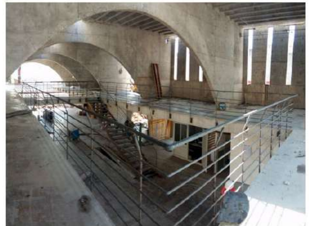
FABRICACION DE BARANDAL DE HERRERÍA H-02 Y H-03 DE 1.43 M. DE DESARROLLO EN PRIMER NIVEL (A BASE DE POSTES, PASAMANOS Y PROTECCIONES HORIZONTRALES DE VARILLA CORRUGADA)
