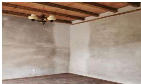
REINTEGRACIÓN DE APLANADOS EN MUROS DE MEZCLA CAL-ARENA
