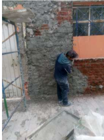
Riva Palacio No 45. Reintegración de aplanados.
