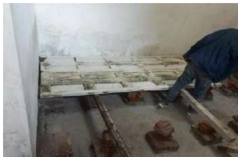
REINTEGRACIÓN DE SOPORTES PARA ENTARIMADO EN PISOS
