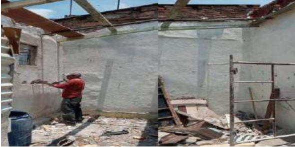
LIBERACIÓN DE CUBIERTA
