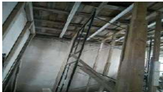
COLOCACIÓN DE APUNTALAMIENTOS DE CIMBRA PARA CUBIERTAS
