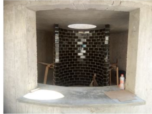
ELABORACION DE MESETAS DE CONCRETO ARMADO EN AREAS DE COMERCIO (EJES 7-B Y F-2)
