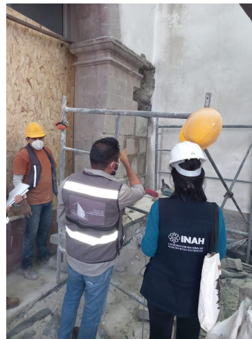
Liberación de piezas en mal estado y reintegración de elementos pétreos trabajados en sitio.
