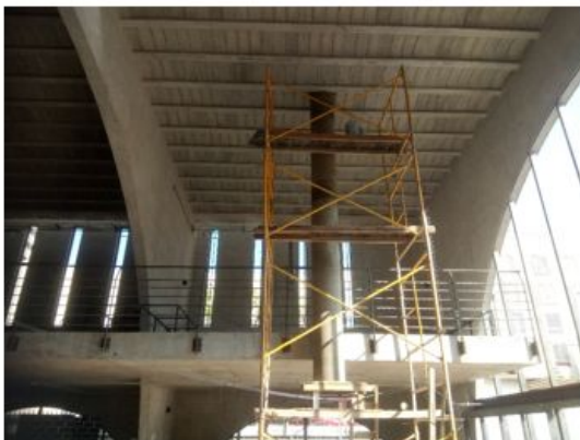
ELABORACION DE CHIMENEA DE EXTRACCION PARA COCINA, DEL NIVEL DE LA PLANTA BAJA A LA AZOTEA (EJES B/5-6)
