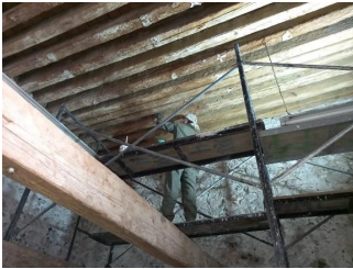
Tratamiento de Vigería de madera en cámara 1 de vestigios arqueológicos.
