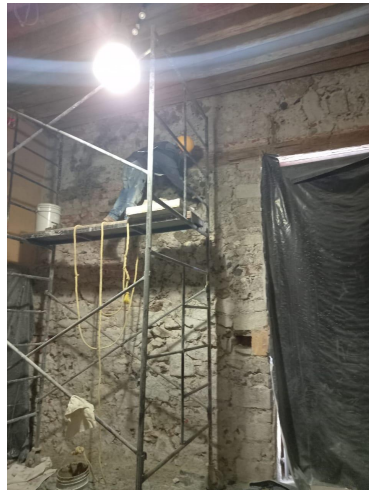
Consolidación de muros de mampostería mixta.
