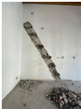
Cocido de grietas en muros de mampostería. Conformación de muros y pretilas en colindancias de azotea.
