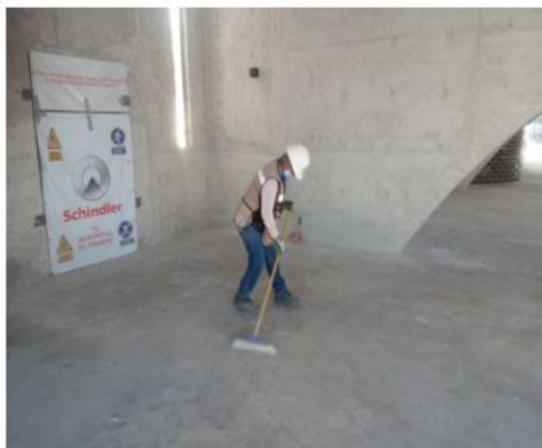
SE REALIZA LIMPIEZA FINA EN OBRA
