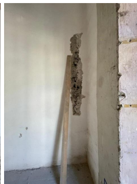
Cocido de grietas en muros de mampostería. Conformación de muros y pretilas en colindancias de azotea.
