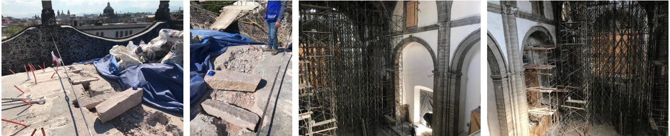
Trabajos de consolidación de grietas en intradós y extradós de bóveda principal.
