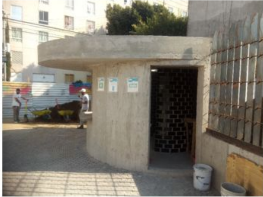
ELABORACION DE MUROS INTERIORES EN AREAS DE COMERCIO (EJES 7-B Y F-2), A BASE DE TABIQUE ESMALTADO SANTA JULIA 10X10X20CM. COLOR VERDE PLATA
