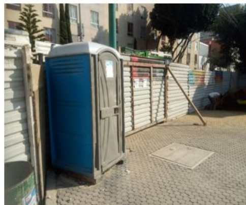
SE CUENTA CON SANITARIOS PORTATILES PARA EL PERSONAL OBRERO
