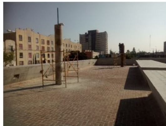
ELABORACION DE CHIMENEA DE EXTRACCION PARA COCINA, DEL NIVEL DE LA PLANTA BAJA A LA AZOTEA (EJES B/5-6)
