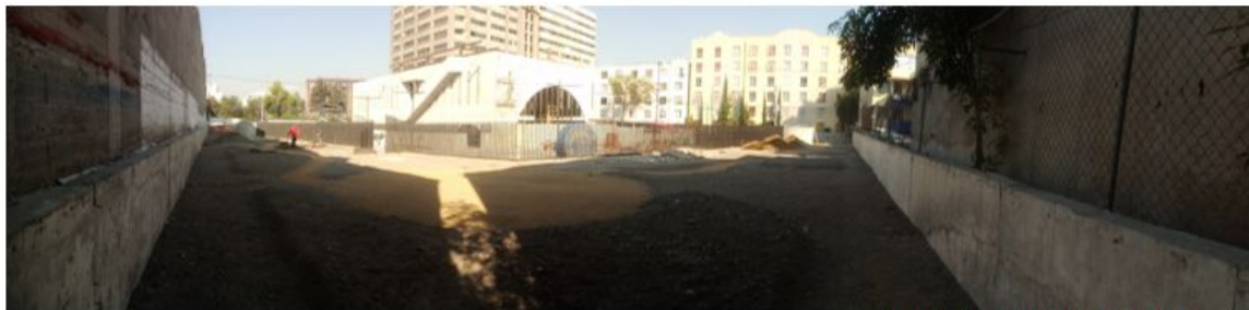
VISTA PANORAMICA NORESTE
