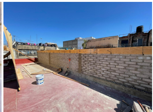
Cocido de grietas en muros de mampostería. Conformación de muros y pretilas en colindancias de azotea.
