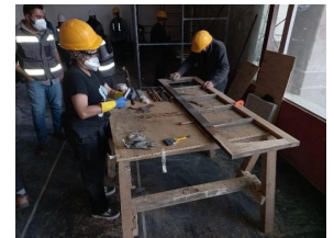
Tratamiento de cancelerías y puertas de madera en estado de deterioro.
