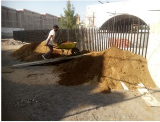
TENDIDO DE TIERRA PARA AFINE DE NIVELES EN PARQUE (EJES 7-8/E-F)
