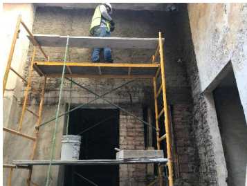
Reintegración de aplanado grueso en muros.
