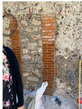
Consolidaciones de muros de mampostería mediante integraciones de elementos de tabique rojo.
