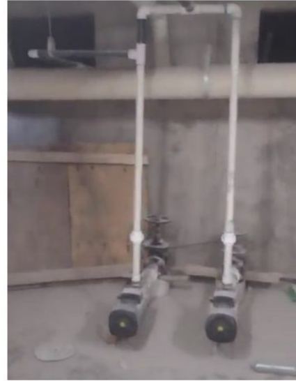
COLOCACIÓN DE DOS BOMBAS HIDRÁULICA EN CUARTO DE MÁQUINAS
