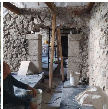
Integración de elementos de cantera labrada en sitio para conformación de vano de interconexión de cámaras 1 y 2 de zona de vestigios arqueológicos.
