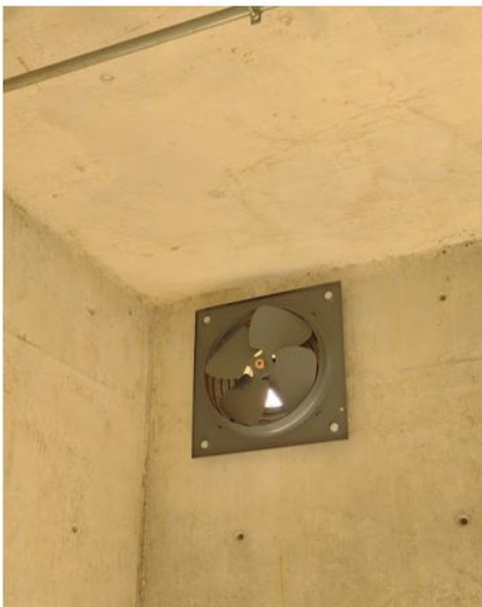
COLACACION DE VENTILADORES
