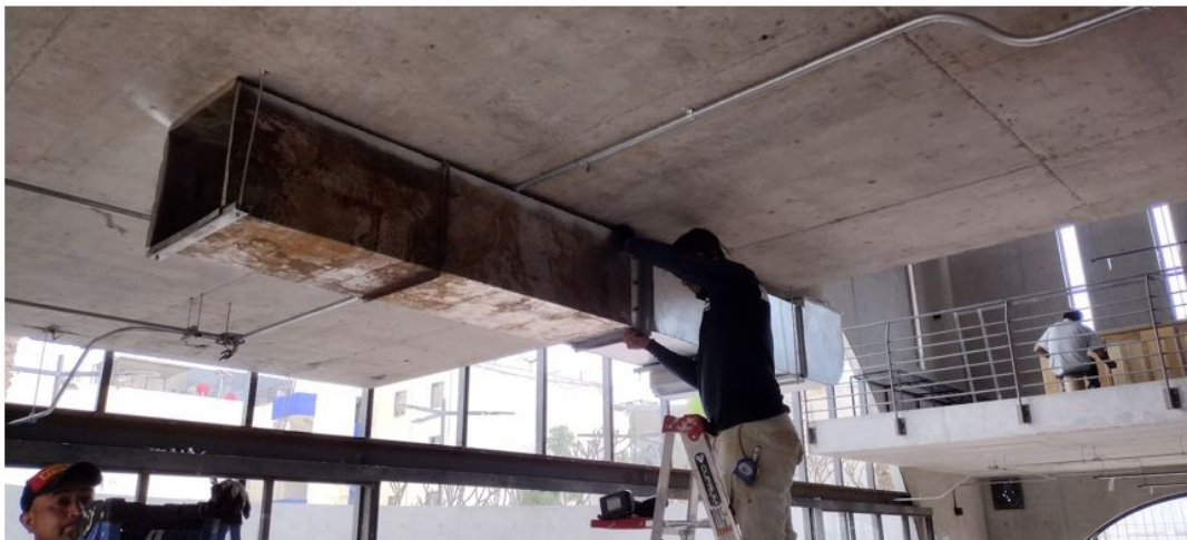
COLOCACIÓN DE DUCTO DE LÁMINA PARA EXTRACCIÓN
