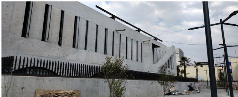
VISTA PANORAMICA NOROESTE
