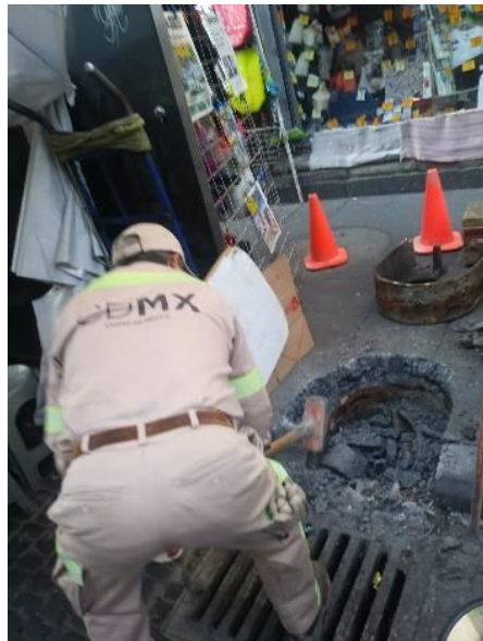
Se realiza la restitución de tapadera pluvial en calle de Venustiano Carranza esq Correo Mayor
