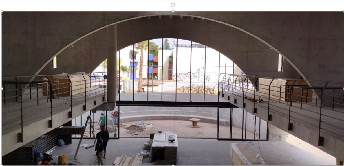
VISTA PANORAMICA DEL PRIMER NIVEL
