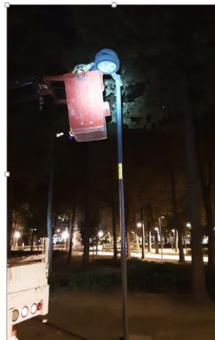
SE REALIZA CAMBIO DE LÁMPARA Y BALASTRO.
