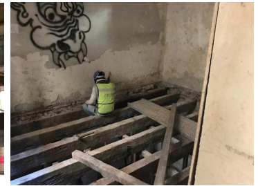
Liberación de sistema de entpiso en mal estado.
