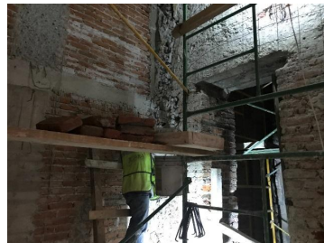
Consolidación de muros de tabique rojo.
