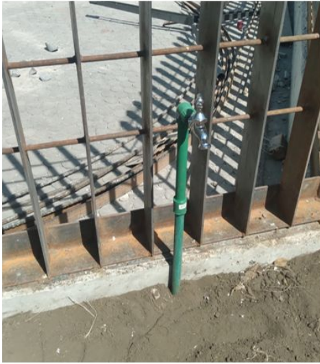
COLOCACIÓN DE LLAVE HIDRÁULICA
