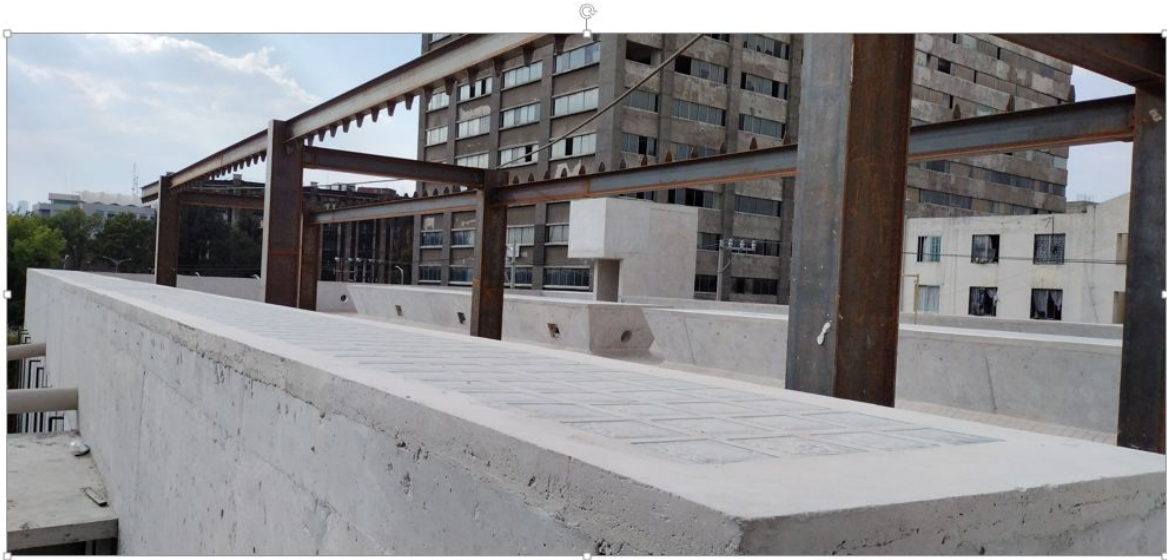
VISTA PANORAMICA DE LA AZOTEA
