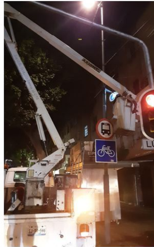
SE REALIZA CAMBIO DE LÁMPARA Y BALASTRO.
