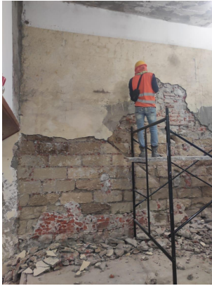
Liberación de aplanados en mal estado en muros de mampostería.
