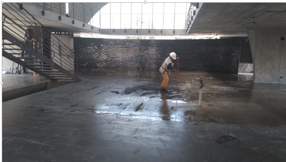
SE REALIZAN TRABAJOS DE LIMPIEZA EN OBRA
