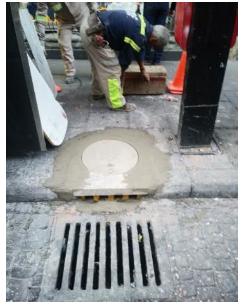
Se realiza la restitución de tapadera pluvial en calle de Venustiano Carranza esq Correo Mayor
