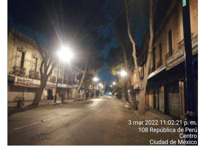
Reparación de luminarias en calle de República de Perú
