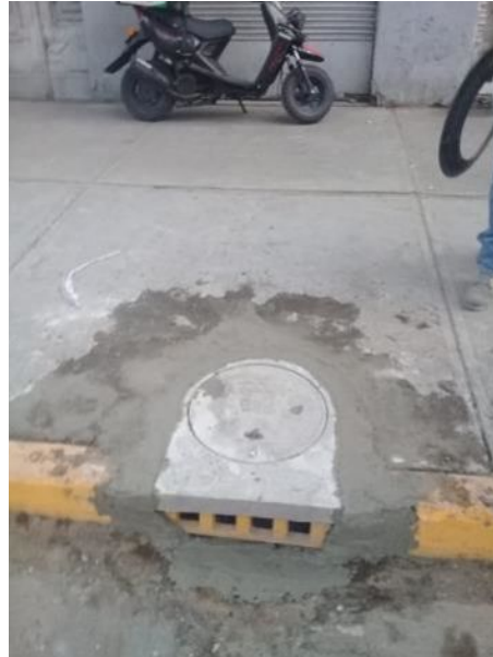
Colocación de tapa de registro pluvial en Costa Rica # 52 entre Florida y Aztecas
