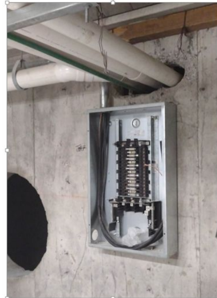
COLOCACION DE TABLEROS ELÉCTRICOS EN CUARTO DE MÁQUINAS
