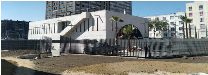
VISTA PANORAMICA NORESTE
