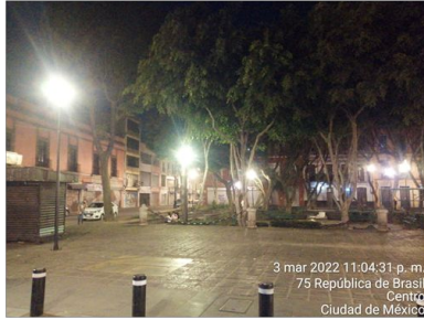
Reparación de luminarias en calle de República de Brasil
