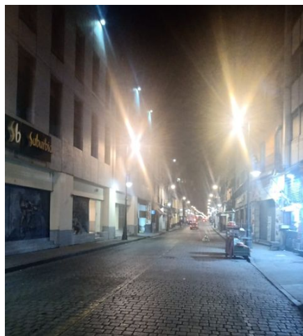
VENUSTIANO CARRANZA TRAMO EJE CENTRAL A BOLÍVAR SE ENCUENTRAN LOS LUMINARIOS EN SERVICIO
