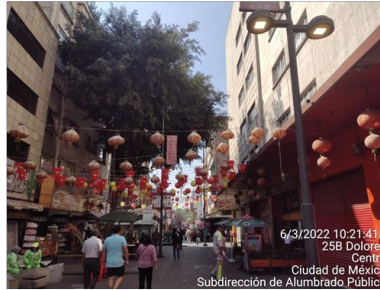
Reparación de luminarias en calle Dolores
