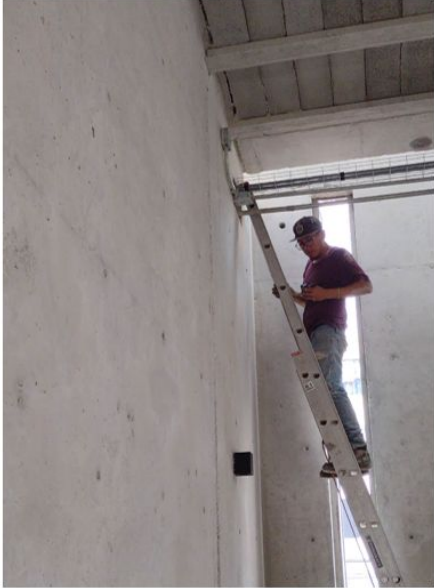
COLOCACIÓN DE CANALIZACIÓN Y CABLEADO DE VOZ Y DATOS
