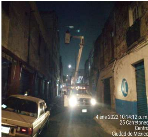
Reparación de luminarias en calle Carretones
