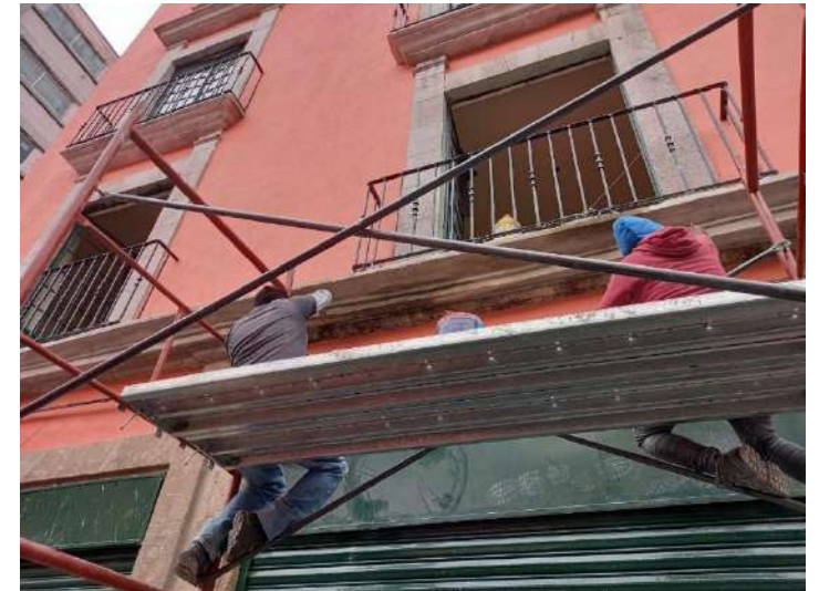
República de Paraguay No. 44. Remoldeo de cornisas de cantera.
