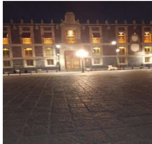
Reparación de alumbrado en plaza Santo Domingo
