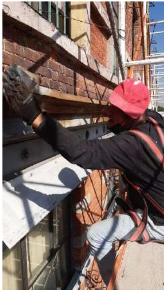
República de Brasil No.64. Tratamiento integral de viguetas metálicas.
