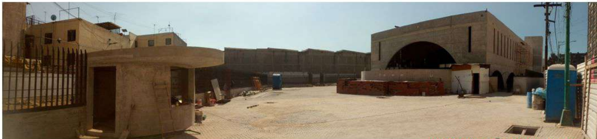
VISTA PANORAMICA SURESTE
