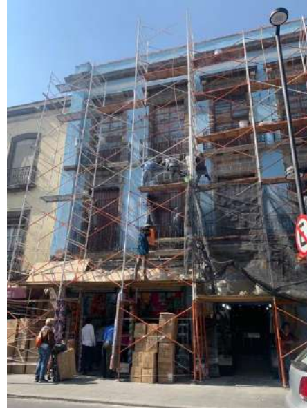
República de Brasil No.62. Remoldeo de elementos de cantera y perfilado de juntas.
