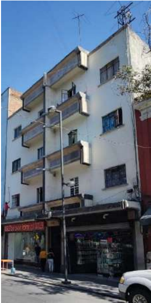
República de Brasil No.63. Aplicación de pintura vinílica.
