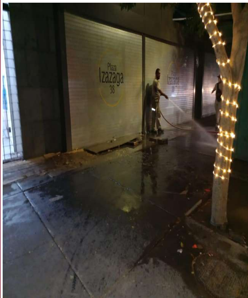
Izazaga # 38 entre Bolívar y E. Central Desazolve de 80 m de atarjea 1 pozos de visitas y 3 coladera pluviales ; retiro de 0.5 m3 de azolve
