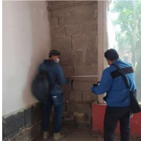
Medición de elementos pétreos a sustituir.
