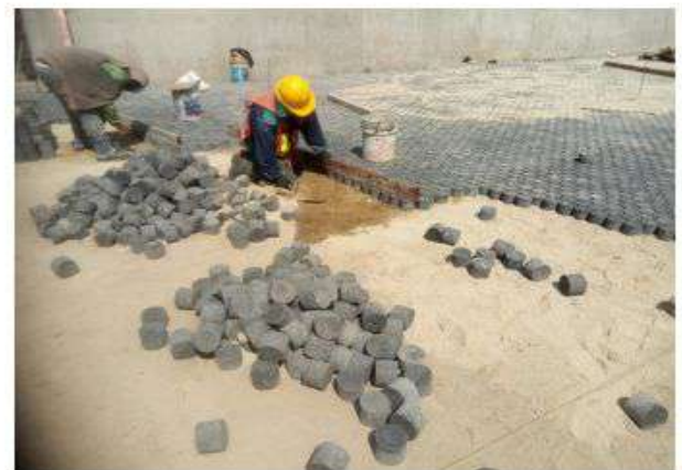
COLOCACIÓN DE PISO DE ADOCRETO CIRCULAR NEGRO DE 10 CM. DE ESPESOR Y 10 CM. DE DIÁMETRO EN PLAZA (EJES 1-7/A-E)
