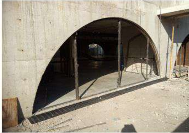
ELABORACION DE FIJOS Y ABATIBLES METALICOS DE PUERTAS P-01 Y P-02 DE LA PLANTA BAJA (EJES B/1-6 Y C/1-6)
