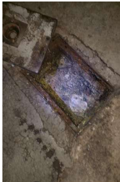
Manuel Doblado # 73 Desazolve y limpieza de drenaje
