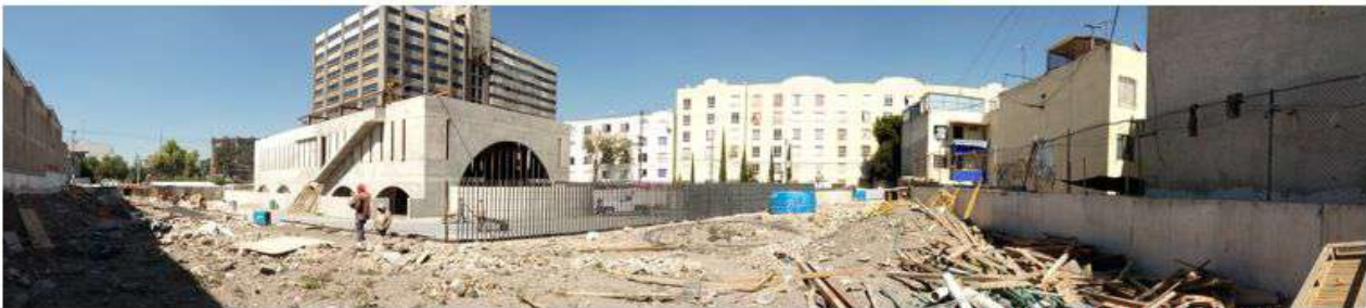
VISTA PANORAMICA NORESTE
