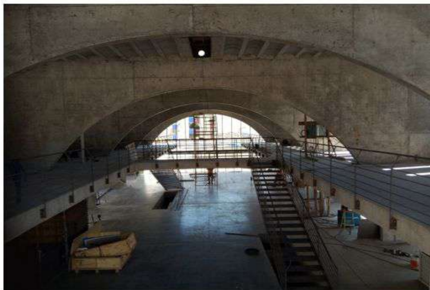
VISTA INTERIOR NIVEL PRIMERO
