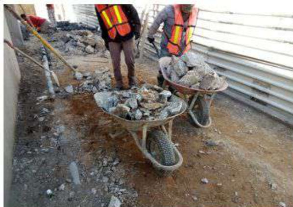
DEMOLICION POR MEDIOS MANUALES DE GUARNICIONES Y BANQUETAS EXISTENTES
