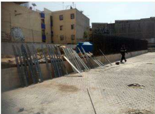
ELABORACION DE REJA DE HERRERIA H05 PARA PARQUE DE 1.90 M DE ALTURA (EJES 7/A-E Y E/1-7)
