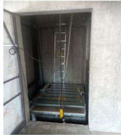
INSTALACION EN SITIO DEL ELEVADOR DE PASAJEROS “SCHINDLER” DE TRES PARADAS (PLANTA BAJA, NIVEL PRIMERO Y AZOTEA)
