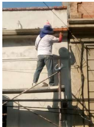
Obraje No. 7. Elaboración de molduras en cornisas.
