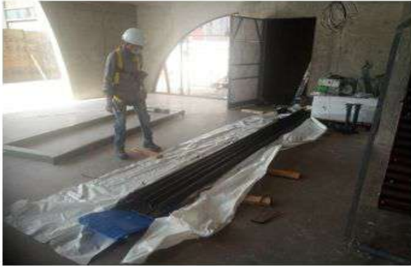
INSTALACION EN SITIO DEL ELEVADOR DE PASAJEROS “SCHINDLER” DE TRES PARADAS (PLANTA BAJA, NIVEL PRIMERO Y AZOTEA)
