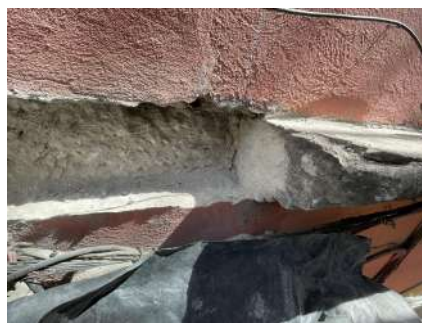
República de Brasil No.43. Sustitución de piezas de cantera.
