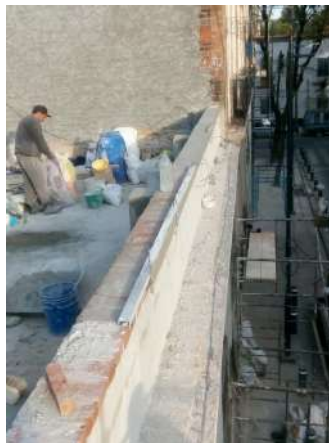
Obraje No. 7. Integración de tapa de pretil.
