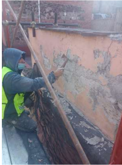
República de Brasil No. 29. Liberación de capa de pintura en mal estado.
