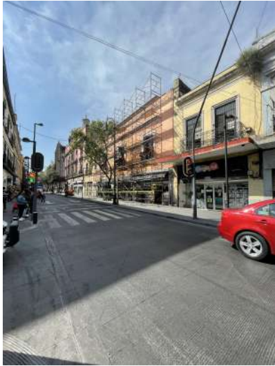
República de Brasil No. 46. Montaje de andamios.
