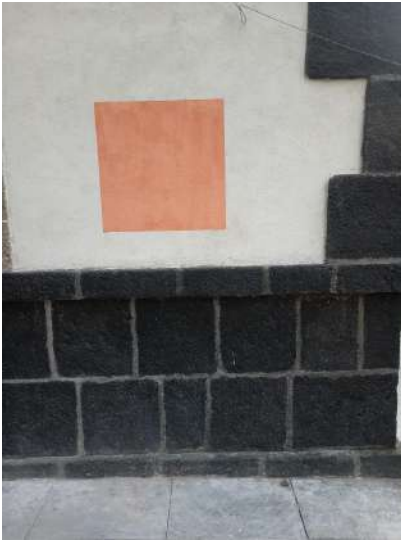
Riva Palacio No. 46-48. Prueba de color en paramentos para autorización de INAH.
