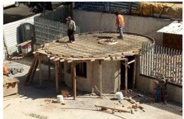
ARMADO CON ACERO DE REFUERZO PARA LOSA DE AZOTEA DEL AREA DE COMERCIO (EJES B-7)
