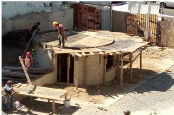
COLOCACION DE CIMBRA DE MADERA PARA LOSA DE AZOTEA DEL AREA DE COMERCIO (EJES E-2)
