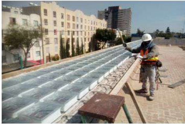
ELABORACION DE TRAGALUZ A BASE DE VITROBLOCK 19X19X08 CM. EN AZOTEA (EJES 1-6/B-C)
