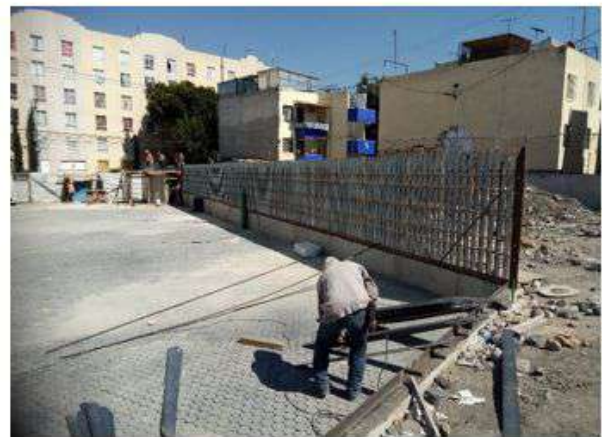
ELABORACION DE REJA DE HERRERIA H05 PARA PARQUE DE 1.90 M DE ALTURA (EJES 7/A-E Y E/1-7)
