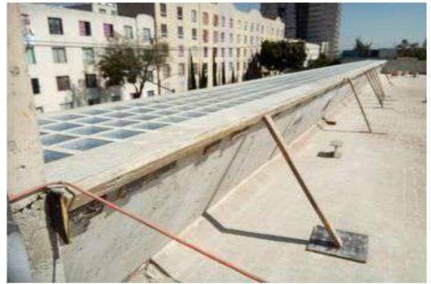
ELABORACION DE TRAGALUZ A BASE DE VITROBLOCK 19X19X08 CM. EN AZOTEA (EJES 1-6/B-C)
