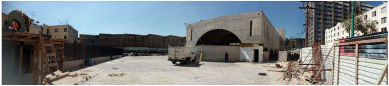
VISTA PANORAMICA SURESTE
