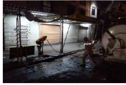
Desazolve en la calle de Peña y Peña
