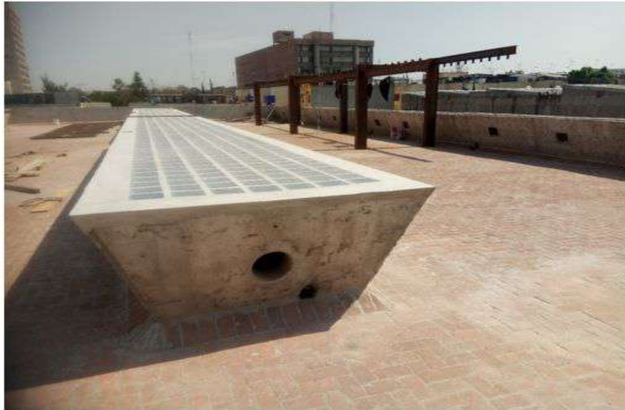
VISTA NIVEL AZOTEA
