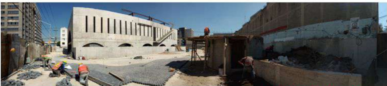
VISTA PANORAMICA NOROESTE
