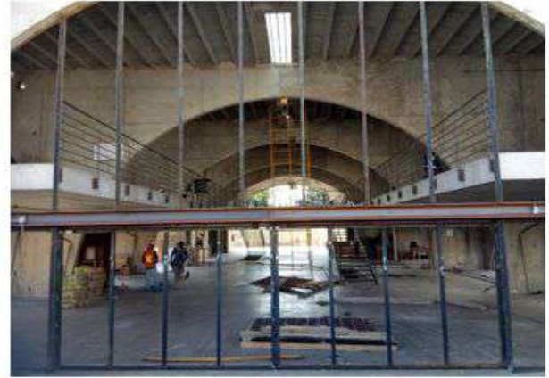
COLOCACION DE FIJOS METALICOS PARA CANCEL C-02 DE LA P.B.-1N (EJE 6/B-C)
