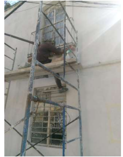
Riva Palacio No. 49. Elaboración de molduras en balcones.
