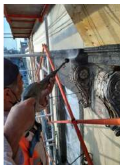
República de Brasil No.62. Lavado de elementos de cantera.
