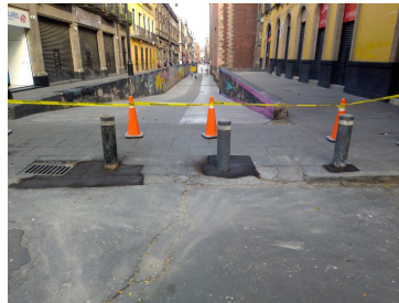
Reposición de 3 bolardos en Zapata esquina Margil
