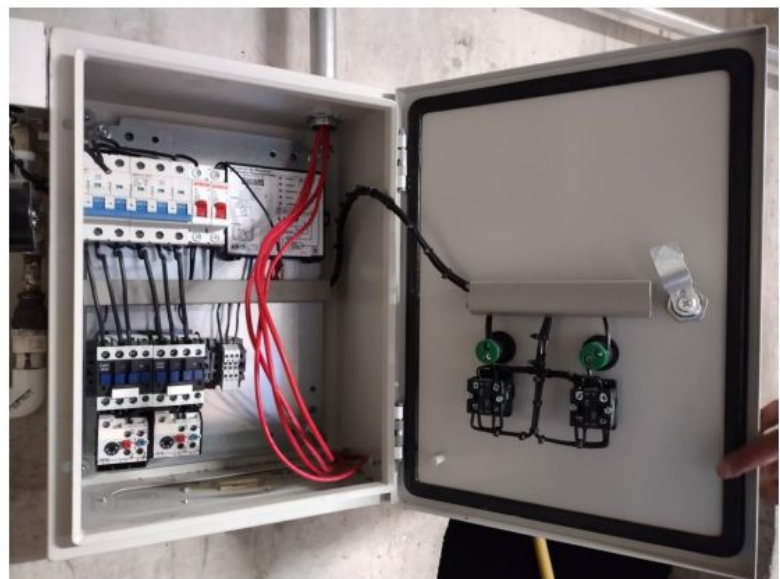
ALIMENTACIÓN ELÉCTRICA DE TABLEROS DE CONTROL
