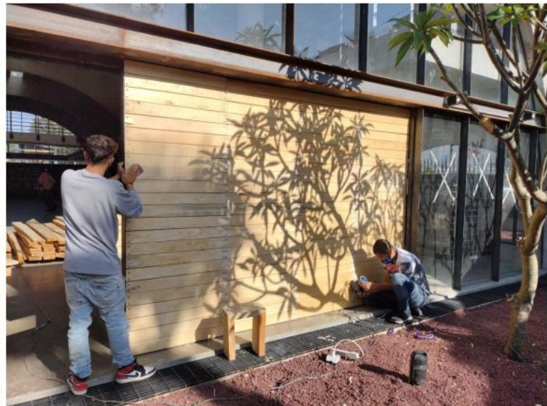
LIJADO DE MADERA EN PORTÓN CORREDIZO
