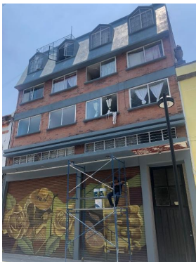
Brasil No. 92: aplicación de pintura en marquesina.
