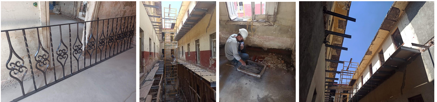
Consolidaciones en muros, liberación de entresijos, integración de entresijos en locales interiores y en pasillos y estabilización de herreras.
