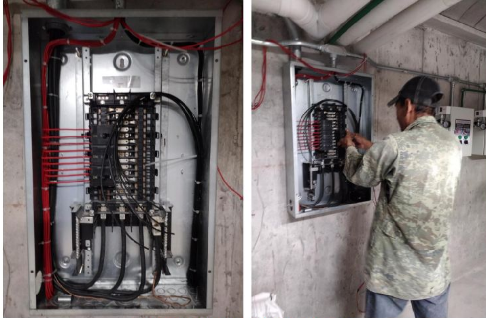
PEINADO DEL TABLERO EN CUARTO DE MÁQUINAS
