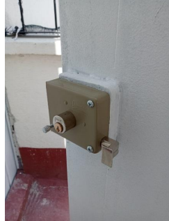
Mantenimiento integral y cambio de cerraduras en puertas metálicas de azotea.
