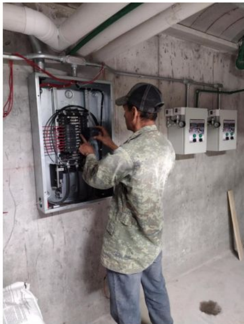
PEINADO DEL TABLERO EN CUARTO DE MÁQUINAS
