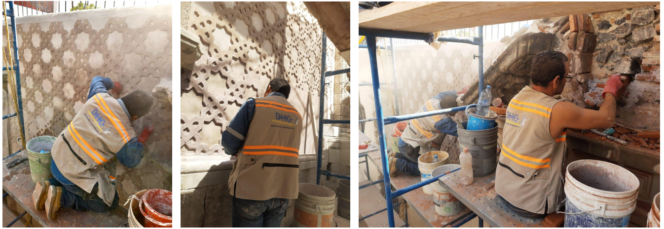
Ecuador No. 8 - 12, trabajos de reintegración de ornamentación y consolidación de portada sobre acceso principal.
