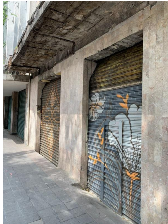
Bucareli No. 53: retiro de pintura sobre elementos de mármol.
