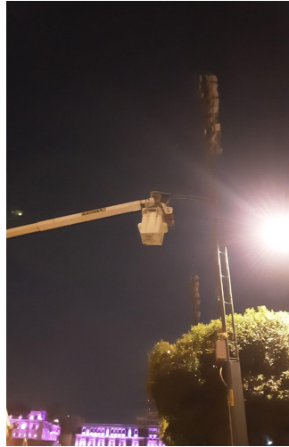
SE REALIZA CAMBIO DE BALASTRO
