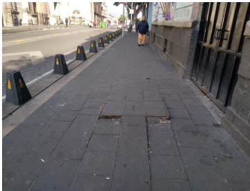
Cambio de piso tipo recinto en Belisario Domínguez
