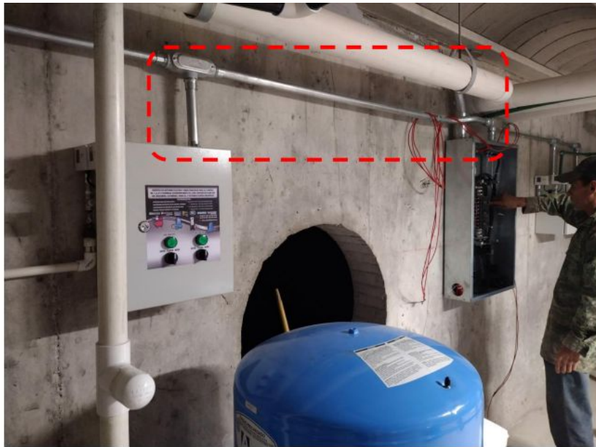
ALIMENTACIÓN ELÉCTRICA DE TABLEROS DE CONTROL
