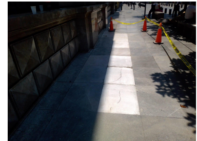
Reposición de piso de mármol en 16 de Septiembre
