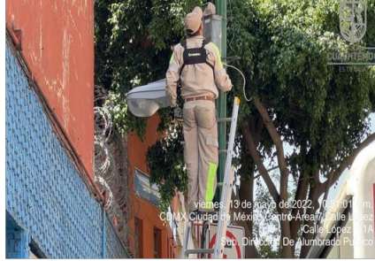
Cambio de fotocelda en calle López
