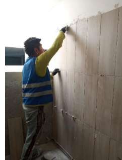
Colocación de lambrín de loseta cerámica en baños de nivel dos.
