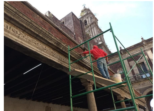
Reintegración de aplanados gruesos de mortero cemento – arena.
