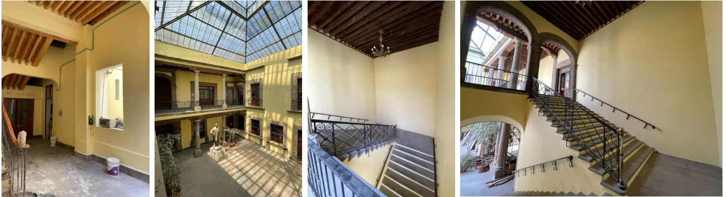
Aplicación de pintura a la cal en áreas de intervención.
