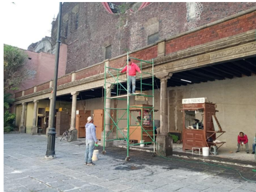
Cosido de grietas y consolidación de muros de mampostería de tabique.
