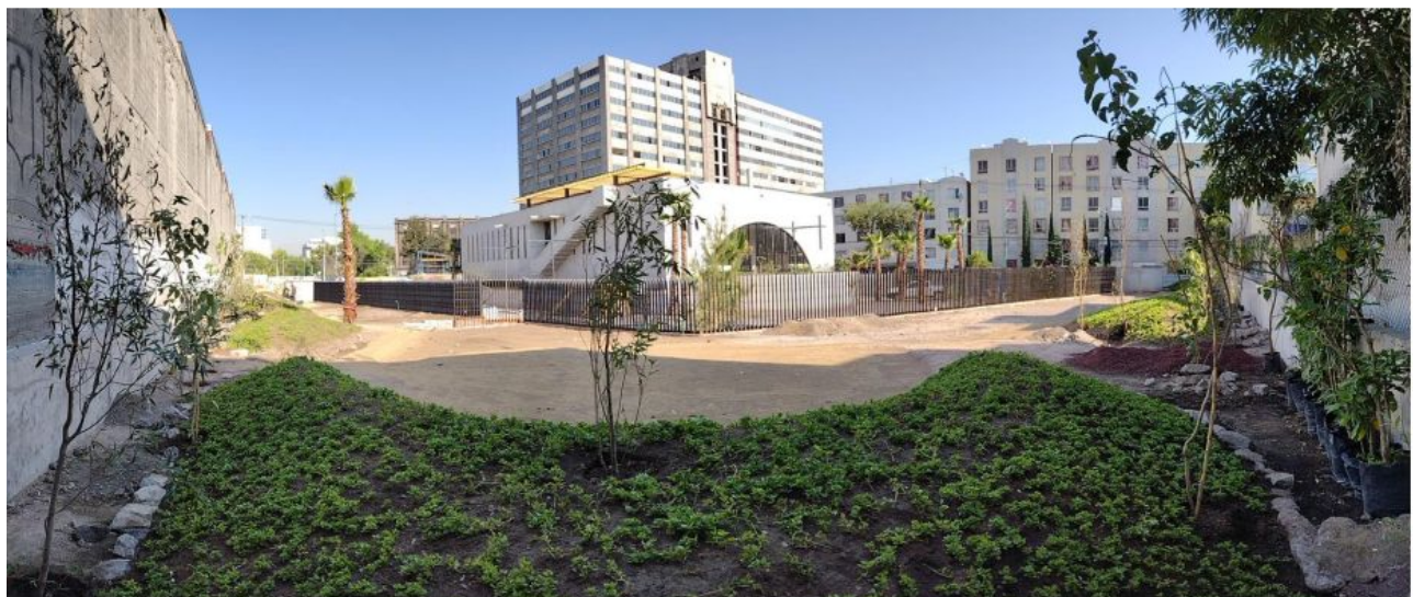
VISTA PANORAMICA NORESTE
