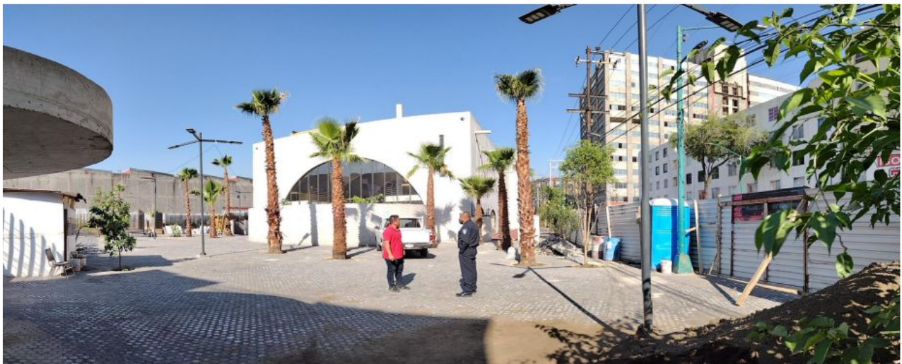
VISTA PANORAMICA SURESTE
