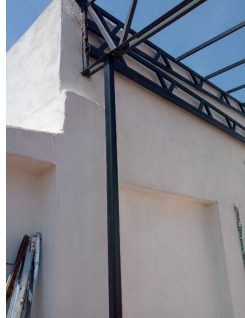
Habilitado y colocación de traves de alma abierta complementarias y largueros longitudinales.
