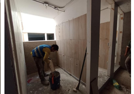
Colocación de lambrín de loseta cerámica en baños de nivel dos.
