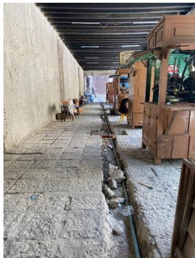
Liberación de capas de impermeabilización y entortados deteriorados.
