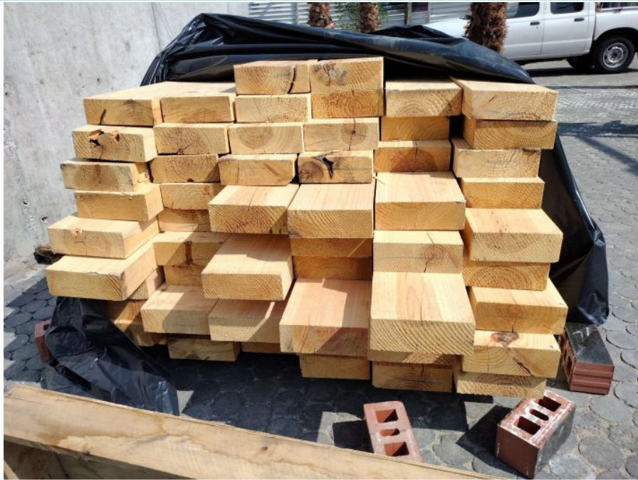
SUMINISTRO DE VIGAS PARA ESTRUCTURA METALICA EN AZOTEA
