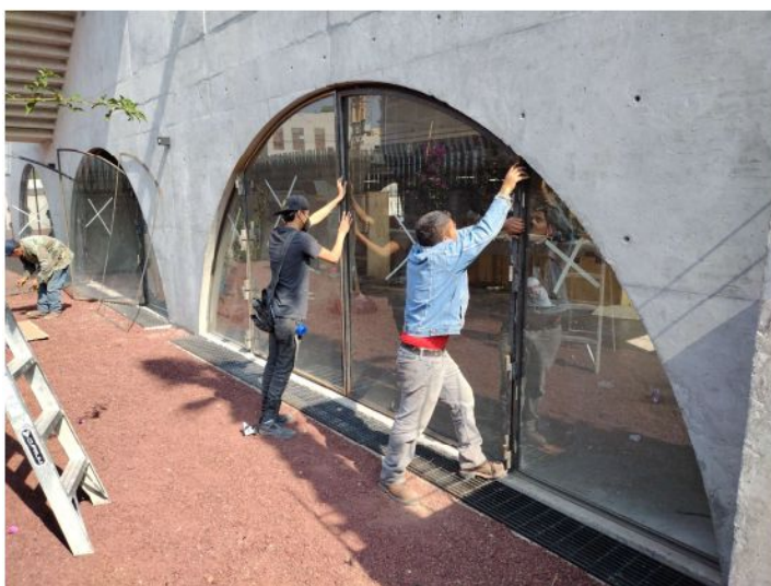
COLOCACIÓN DE MARCOS DE HERRERÍA
