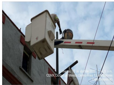
Reparación de luminarias en calle Dolores
