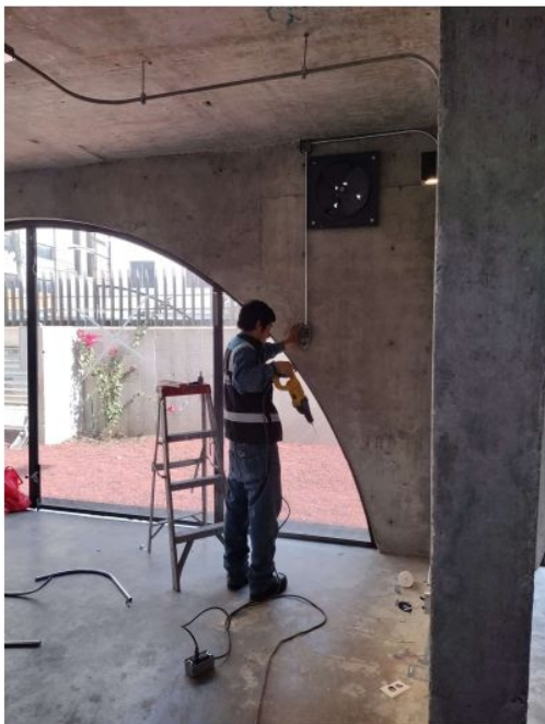
ALIMENTACIÓN A VENTILADORES DE EXTRACCIÓN
