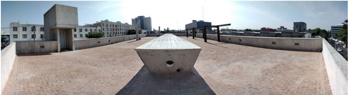
VISTAS PANORAMICAS DE LA AZOTEA
