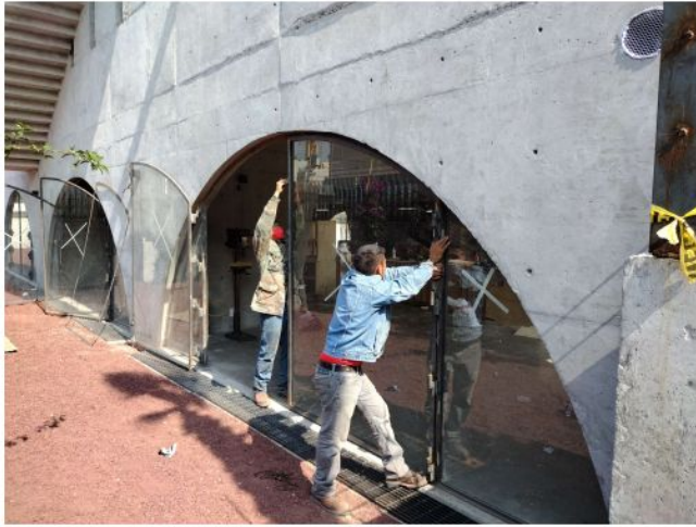
COLOCACIÓN DE MARCOS DE HERRERÍA
