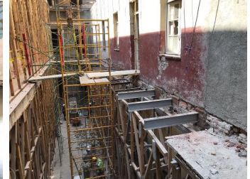
Habilitado de acero para soporte de pasillos centrales en nivel dos.
