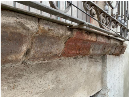
Retiro de pintura en elementos de cantera. Integración de aplanado fino. Limpieza de elementos de tabique. Preparación de superficie en manzarda para integración de aplanado fino.
