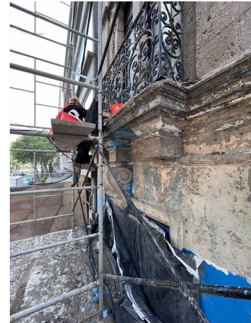
Integración de juntas. Retiro de pintura en elementos de cantera. Tratamiento integral a herrería histórica.
