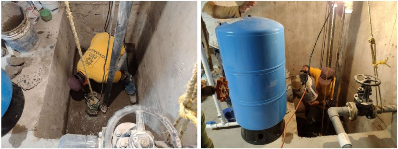
NIVELACIÓN EN EL CÁRCAMO DE BOMBEO
