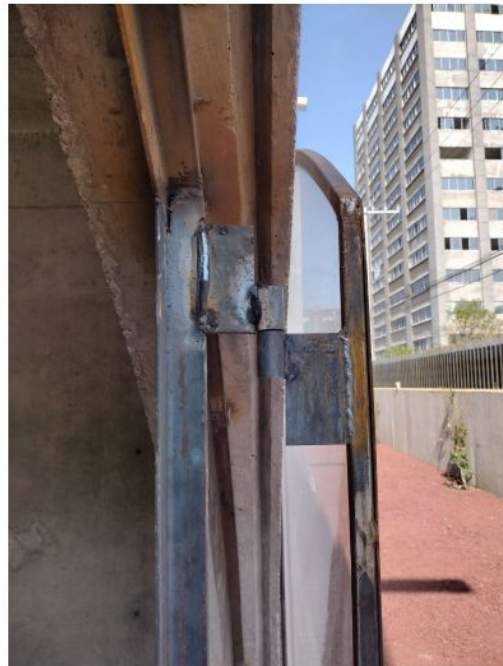
COLOCACIÓN DE BISAGRAS EN PUERTAS DE HERRERÍA
