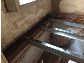
Colocación de acero estructural para rehabilitación de entresijos.
