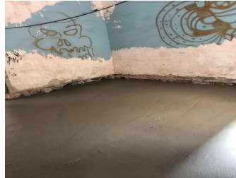
Colado de losa de entresijo con malla electrosoldada.
