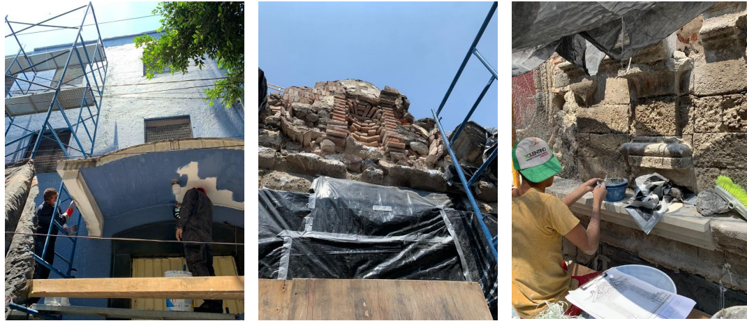
Aplicación de pintura y consolidación de elementos de cantera.
