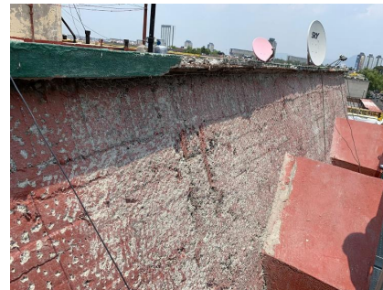
Retiro de pintura en elementos de cantera. Integración de aplanado fino. Limpieza de elementos de tabique. Preparación de superficie en manzarda para integración de aplanado fino.
