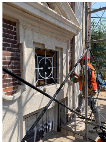
Integración de juntas. Retiro de pintura en elementos de cantera. Tratamiento integral a herrería histórica.
