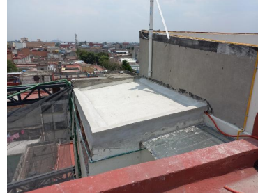
Habilitado y colado de losa de cubierta en baños de sección sur de azotea.
