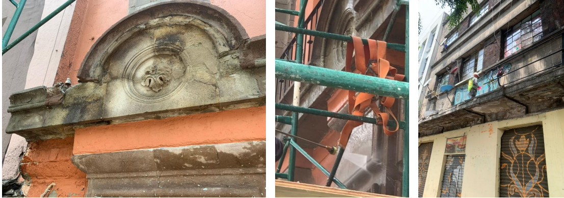
Lavado de elementos de cantera y retiro de pintas vandálicas.
