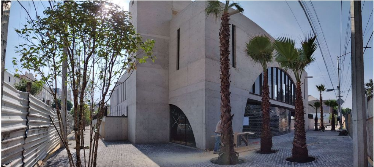
VISTA PANORAMICA SUROESTE
