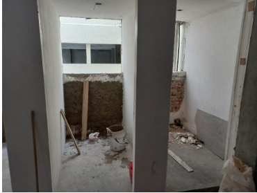
Aplanado grueso de cemento arena para recibir acabado final, baños nivel dos sección sur.
