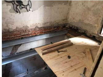
Colocación de cimbraplay para posterior colado de entresijo.
