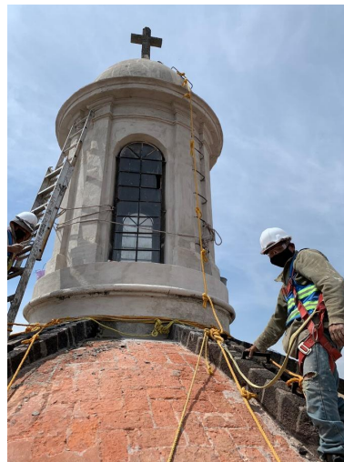
Liberación de aplanado de cemento en cúpula.
