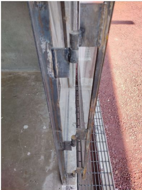
COLOCACIÓN DE BISAGRAS EN PUERTAS DE HERRERÍA
