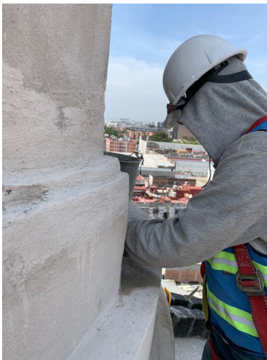
Consolidación de cantera e integración de enlucido en cúpula.
