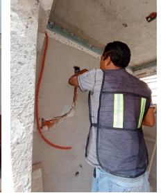
Ranurado para colocación de instalaciones hidrosanitarias y eléctricas en baños de azotea.
