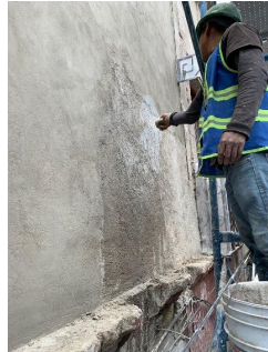
Retiro de pintura en elementos de cantera. Integración de aplanado fino. Limpieza de elementos de tabique. Preparación de superficie en manzarda para integración de aplanado fino.
