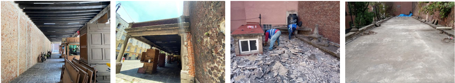
Retiro de aplanados en estado de deterioro.
