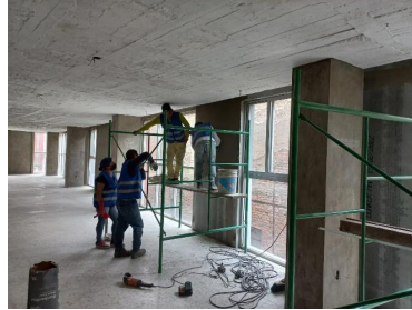
Colocación de cerramientos laterales de tabla cemento en ventanas interiores de nivel dos.
