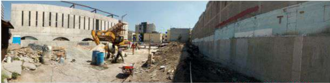
VISTA PANORAMICA NOROESTE
