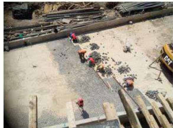
COLOCACIÓN DE PISO DE ADOCRETO CIRCULAR NEGRO DE 10 CM. DE ESPESOR Y 10 CM. DE DIÁMETRO EN PLAZA (EJES 6-7/A-D)
