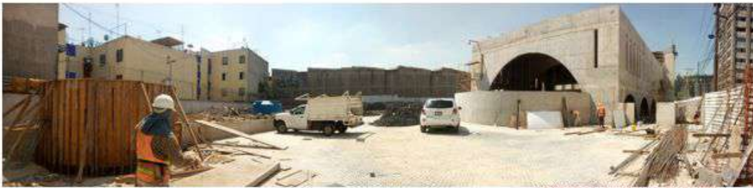
VISTA PANORAMICA SURESTE
