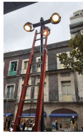
SE CAMBIO BALASTRO / LÁMPARA APAGADA.
