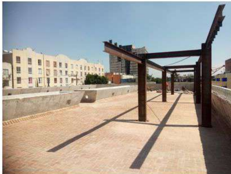
VISTA INTERIOR NIVEL AZOTEA
