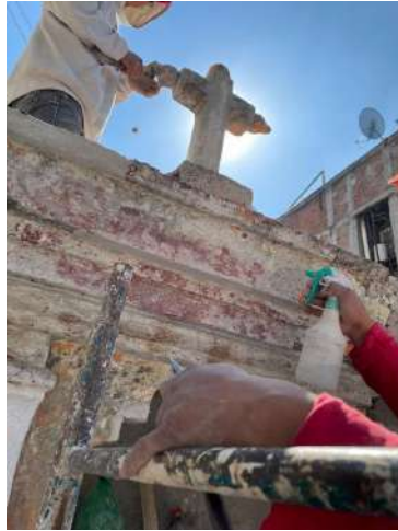
Riva Palacio No 45. Consolidación de elemento ornamental.
