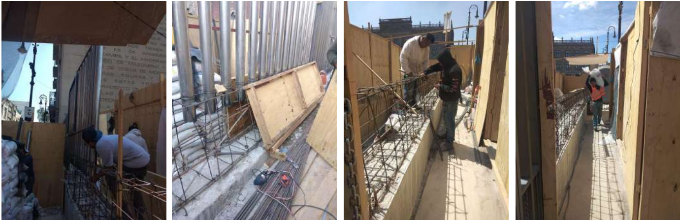
Actividades de desmontaje de elementos de reja anterior y preparación de base.
