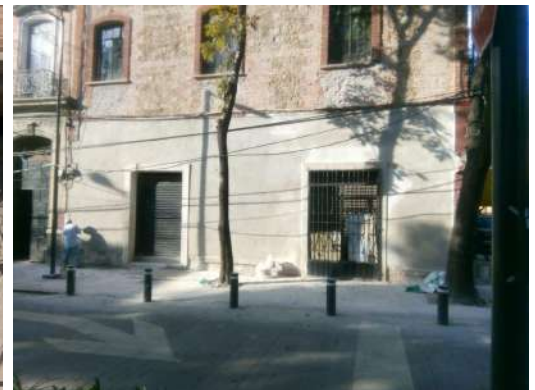
Riva Palacio No. 52. Integración de aplanado fino de cal-arena.
