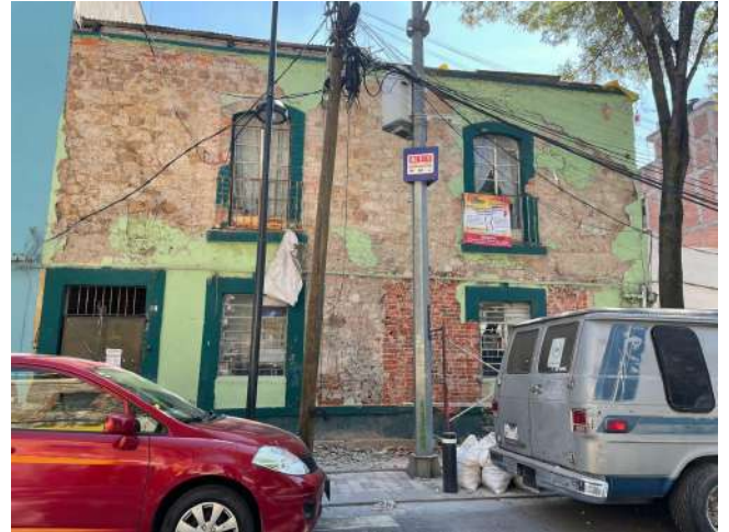
Riva Palacio No. 49. Liberación de aplanados en mal estado.
