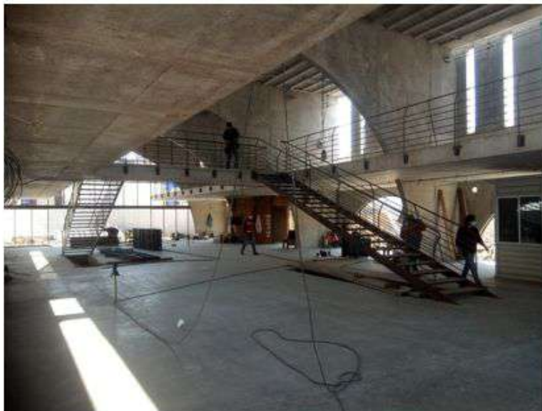
VISTA INTERIOR PLANTA BAJA
