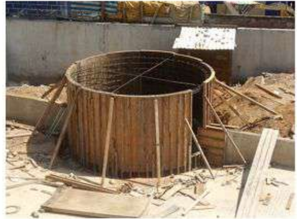
ARMADO CON ACERO DE REFUERZO Y COLOCACION DE CIMBRA DE MADERA PARA AREAS DE COMERCIO (EJES B-7)
