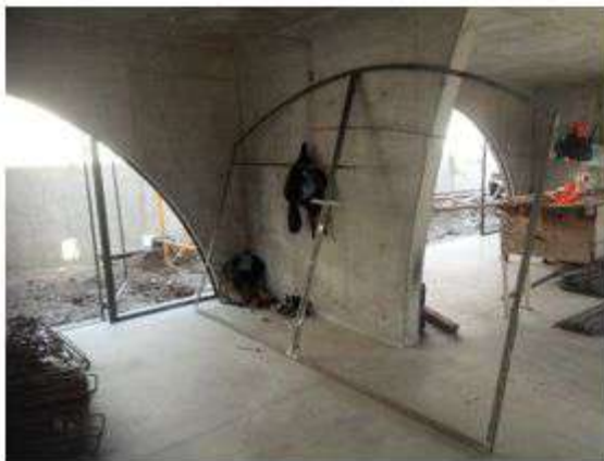
ELABORACION DE MARCOS METALICOS PARA PUERTAS P-01 Y P-02 DE LA PLANTA BAJA (EJES B/1-6 Y C/1-6)
