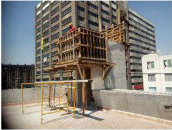
COLADO DE PRETILES DEL CUBO DE ELEVADOR (EJES B-2)
