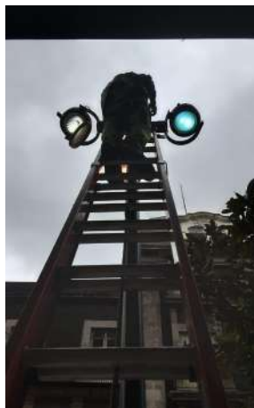
SE CAMBIO BALASTRO / LÁMPARA APAGADA.
