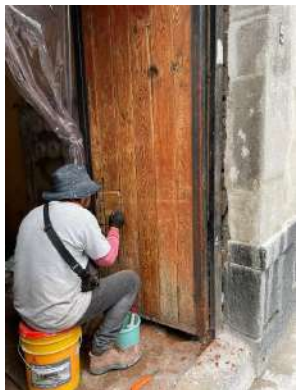
Las Cruces No.5. Tratamiento integral del portón de madera.
