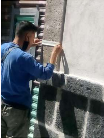
Riva Palacio No. 46-48. Reintegración de juntas en elementos de piedra natural.
