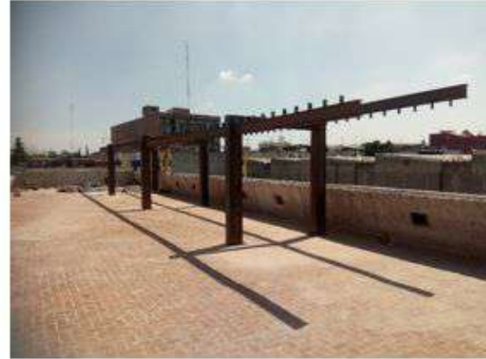
COLOCACION DE COLUMNAS Y TRABES METALICAS PARA TECHUMBRE DEL AREA DE TERRAZA (EJES 2-6/B-C)
