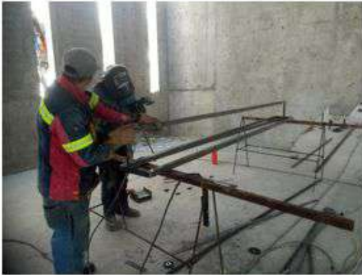
ELABORACION DE FIJOS METALICOS PARA TRONERAS T-01 DE 0.30X3.10 M. (EJES B/1-6 Y C/1-6)
