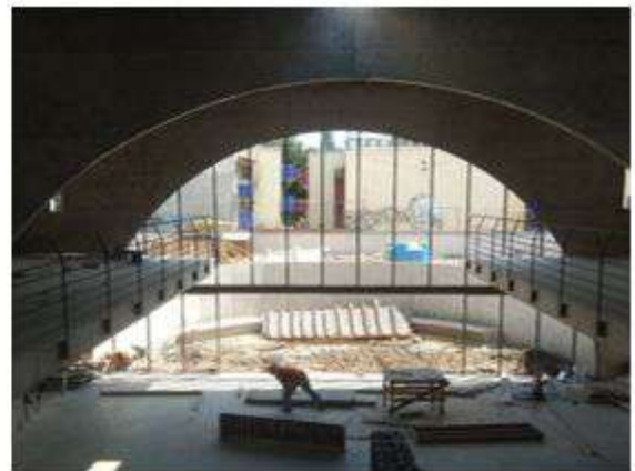
COLOCACION DE FIJOS METALICOS PARA CANCEL C-02 DE LA P.B.-1N (EJE 6/B-C)
