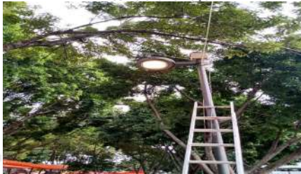
Se reparan 2 circuitos en Plaza San Lucas y Plaza Pino Suárez, quedan funcionando 23 luminarias.
