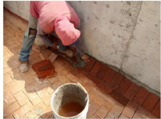
COLOCACION DE ENLADRILLADO EN AZOTEA (EJES 1-6/B-C)
