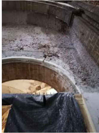
Consolidación de muros.
