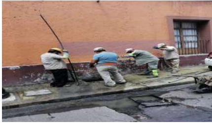
Se realizó desazolve en Callejón de Jiménez esquina Echeveste, se limpian 4 coladeras y se sondean 16 mts. de drenaje.
