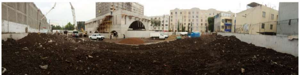
VISTA PANORAMICA NORESTE
