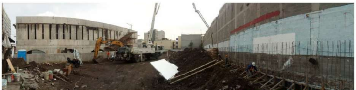
VISTA PANORAMICA NOROESTE
