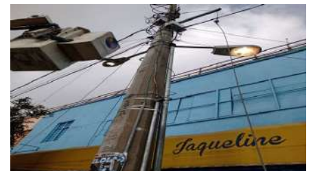
Se repara 1 circuito en República de Costa Rica y González Ortega, quedan funcionando 10 Luminarias.
