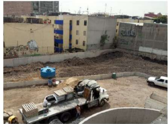
CONFORMACIÓN DE NIVELES EN PLAZA Y JARDÍN/HUERTO CON MATERIAL PRODUCTO DE LA EXCAVACIÓN (EJES 7-8/E-F)
