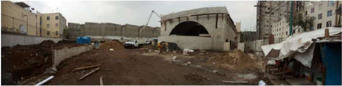
VISTA PANORAMICA SURESTE
