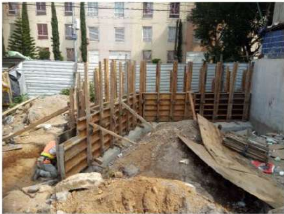
COLADO CON CONCRETO PREMEZCLADO F'c=250KG/CM2 PARA CIMENTACION Y MURO BAJO DEL PARQUE (EJE 7-E)
