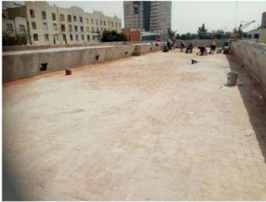
COLOCACION DE ENLADRILLADO EN AZOTEA (EJES 1-6/B-C)
