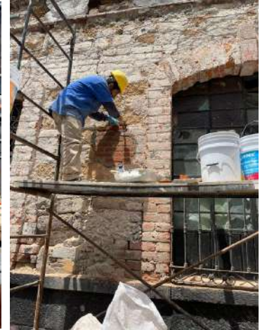
Obraje No. 7. Consolidación de grietas.
