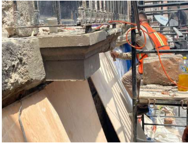
Las Cruces No. 5. Integración de piezas de cantera en balcones.
