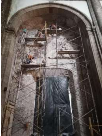
Consolidación de grietas.
