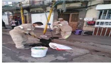
Se realizó desazolve en República de Argentina No. 100, se limpian 4 coladeras, 1 rejilla y se sondean 15 mts. de drenaje
