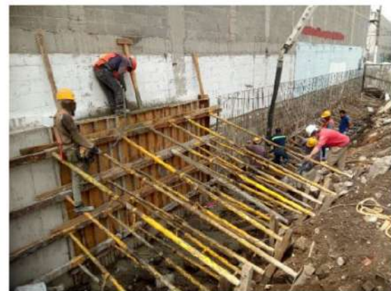
COLADO CON CONCRETO PREMEZCLADO F´C=250KG/CM2 EN MURO DE COLINDANCIA (EJES F/5-6)
