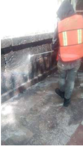
Riva Palacio No. 46-48. Limpieza de pintura vinílica en rodapié de recinto.
