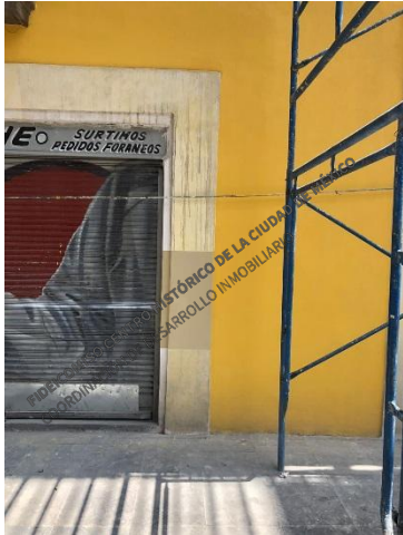
Brasil No. 60: Aplicación de pintura en paramentos y marcos.
