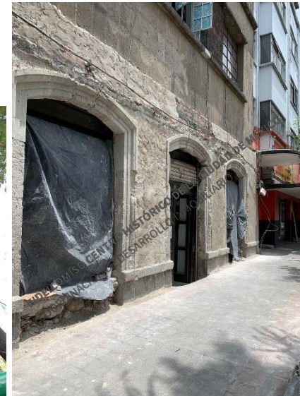
Bucareli No. 53: Integración de aplanado grueso cal -arena.
