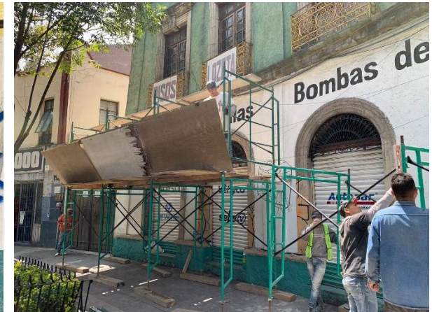
Bucareli No. 154: Montaje de andamios en tramo de fachada sobre calle Barcelona.
