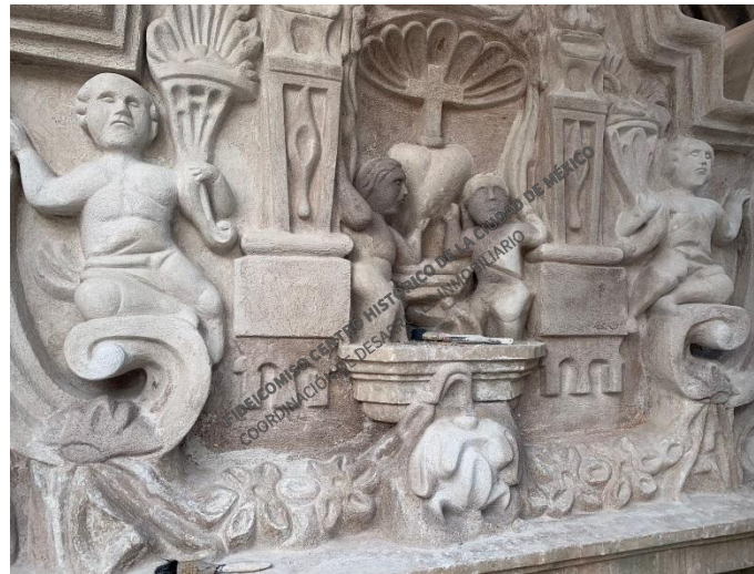
Ecuador No. 8-12, Restauración de portada a base de argamasa.
