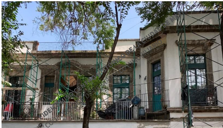
Bucareli No. 73: Preparación para aplicación de pintura vinílica. Tratamiento integral de herrerías.
