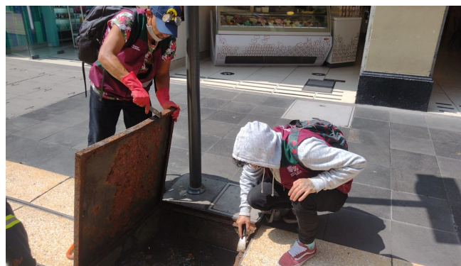
Atención de limpieza en Plaza Vizcaínas, reparación de válvula de toma de agua en Plaza Primo de Verdad y apertura de registros en la calle Madero, con apoyo de 8 infractores de Justicia Cívica, 19 de julio de 2022
