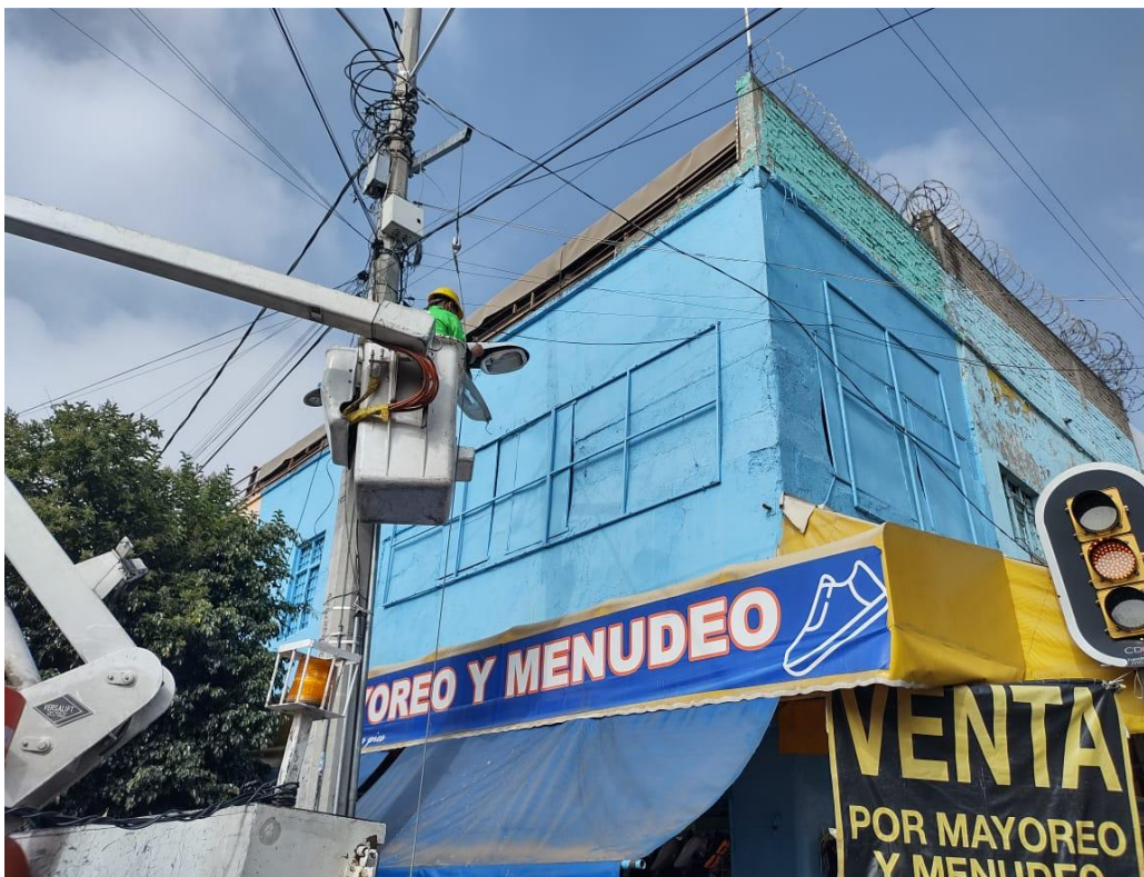
CAMBIO DE FOTOCELDA.
