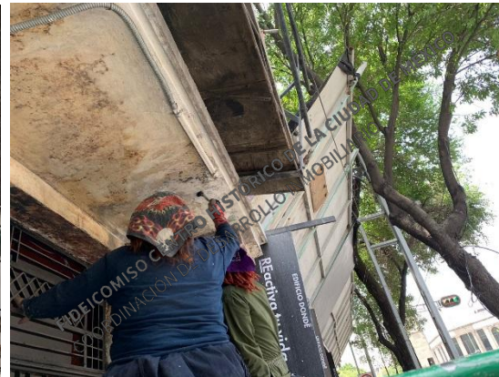
Bucareli No. 66: Retiro de pintura de elementos ornamentales de granito.
