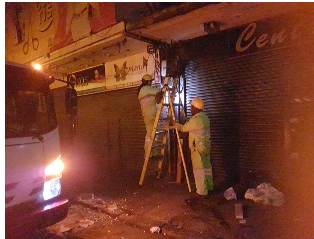
RECONEXIÓN DE LÍNEAS.
