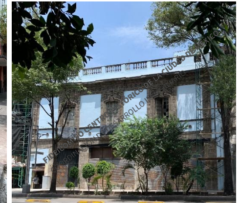
Bucareli No. 69: Aplicación de pintura a la cal.
