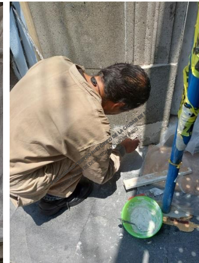
Leona Vicario No. 10, Remoldeo a base de pasta de polvo de cantera y cal.
