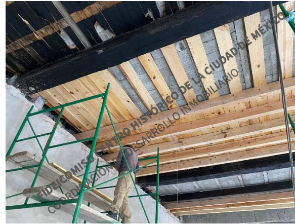
Liberación de tablado de madera por encontrarse en muy mal estado de conservación, con presencia de humedad y de carbón. Colocación de elementos de madera nuevos.
