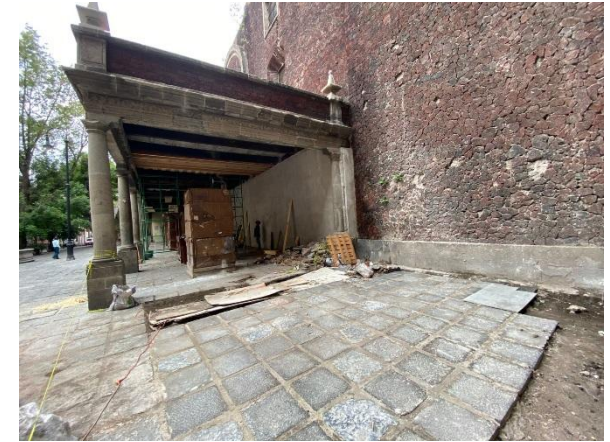
Liberación de piso de concreto e integración de piezas de recinto similar al existente.
