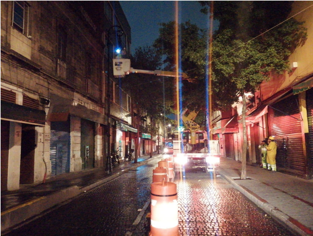
CAMBIO DE LÁMPARA Y BALASTRO.
