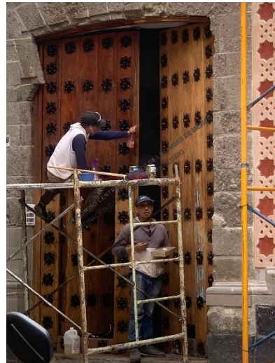
Ecuador No. 8 - 12, Tratamiento integral de portón de madera.
