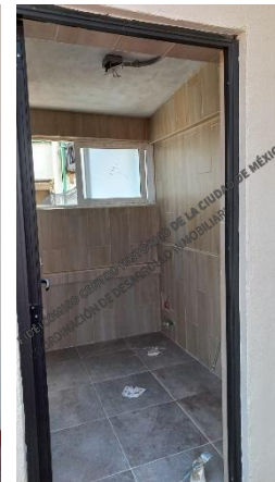
Colocación de piso de loseta en núcleo de sanitarios de azotea y nivel dos.
