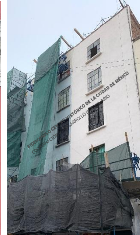
Brasil No. 65: Preparación para aplicación de pintura vinílica. Tratamiento básico de herrería en ventanas.
