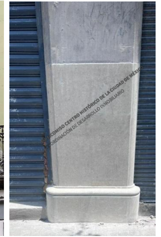
Brasil No. 67: Pulido de elementos de granito en planta baja.
