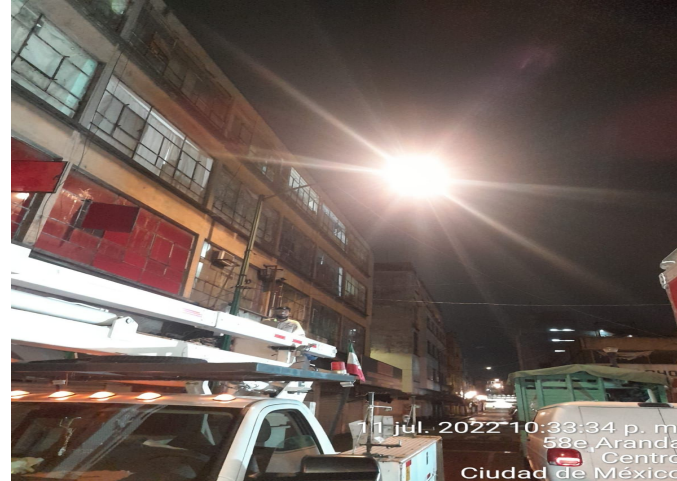
Cambio de lámpara en calle Aranda
