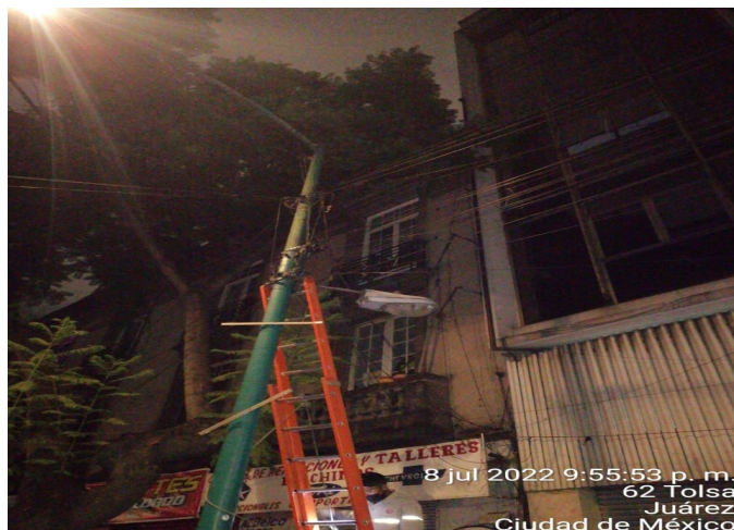
Reparación de luminarias en calle Tolsá
