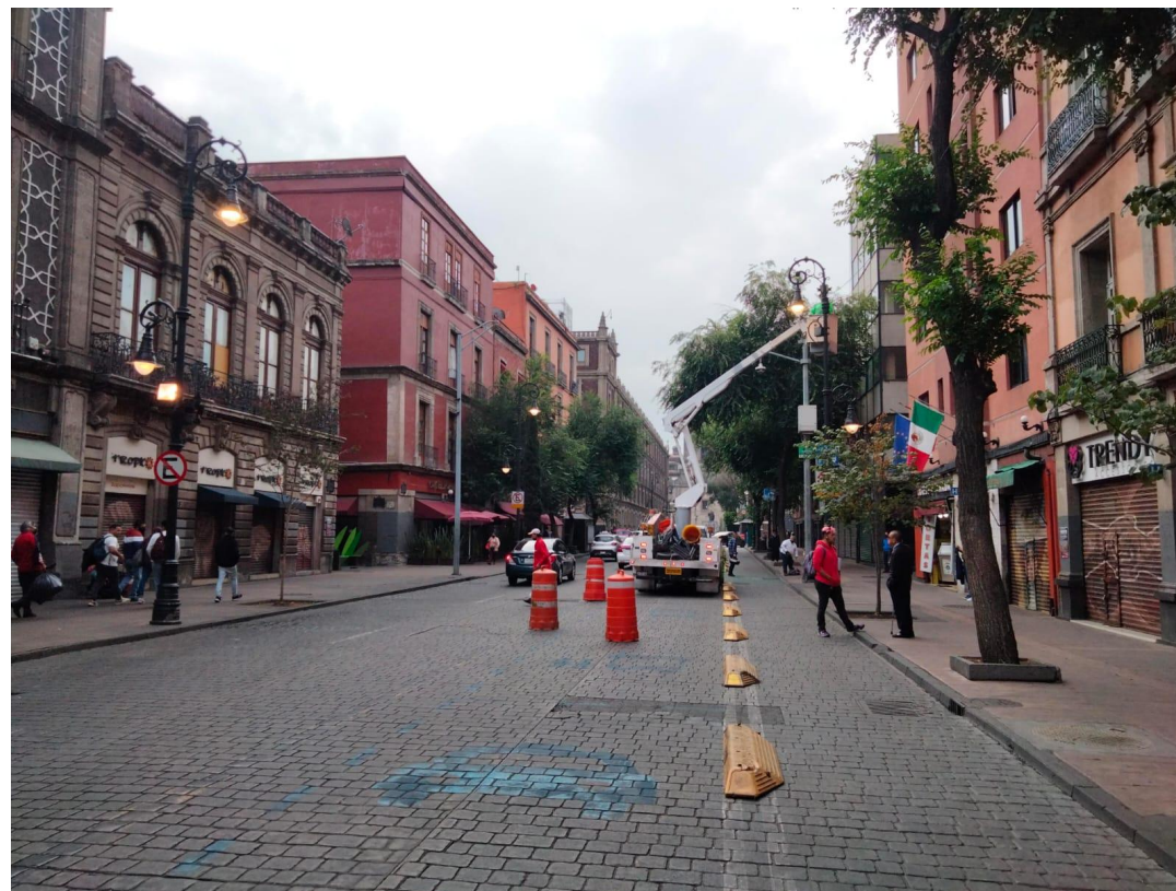
CAMBIO DE FOTOCELDA.
