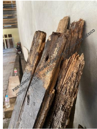
Liberación de tablado de madera por encontrarse en muy mal estado de conservación, con presencia de humedad y de carbón. Colocación de elementos de madera nuevos.
