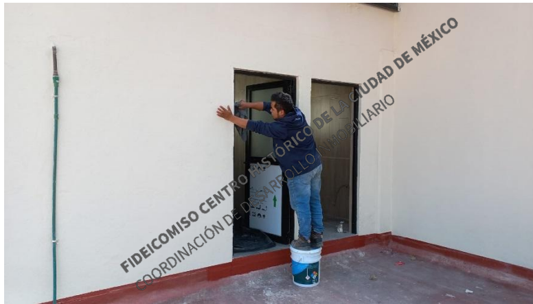
Colocación de puertas de cancelería en baños de azotea.
