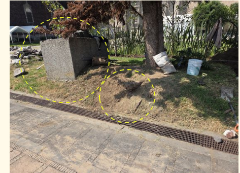
Fotografía 5. Condiciones en la base del tronco. Se observa el levantamiento la escultura y también se observa el corte de raíz.
