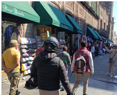
Supervisión del Subsecretario de la instalación de CVP en Moneda y Correo Mayor
