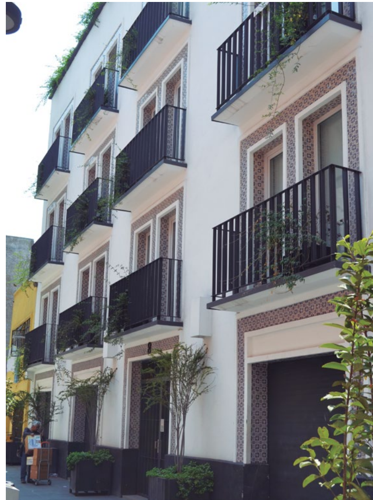
Fachada de mejoramiento de vivienda en la calle San Ildefonso. Fuente: Archivo PUEC-UNAM.
