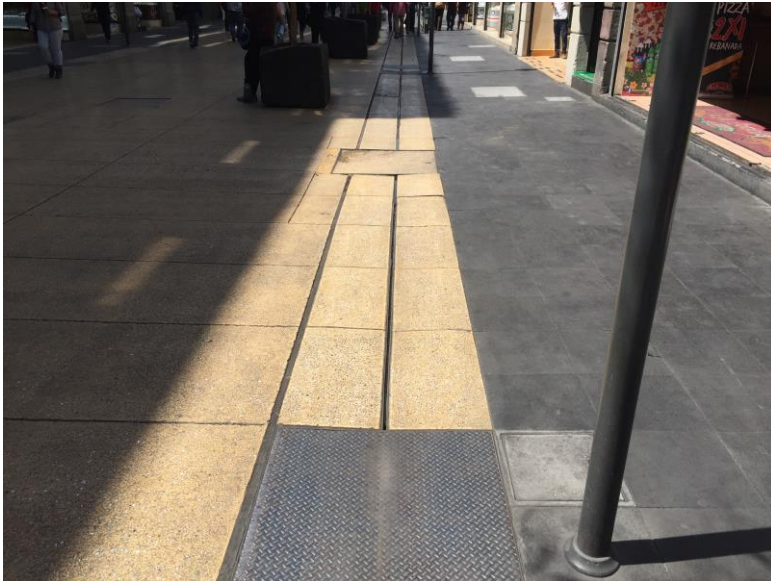
CALLE MADERO DREN EXISTENTE
