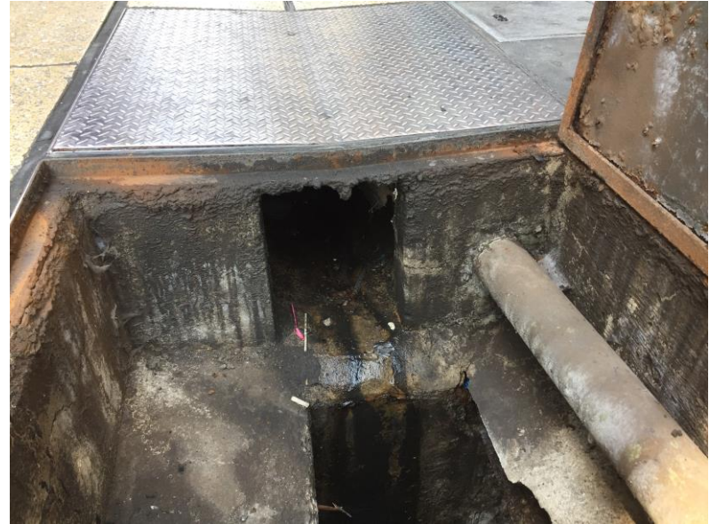
CALLE MADERO DREN LIMPIO
