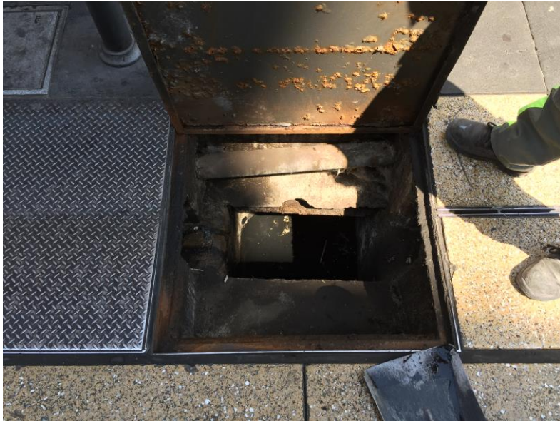
CALLE MADERO POZO DE VISITA LIMPIO
