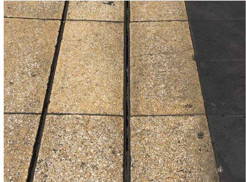
CALLE MADERO DREN EXISTENTE
