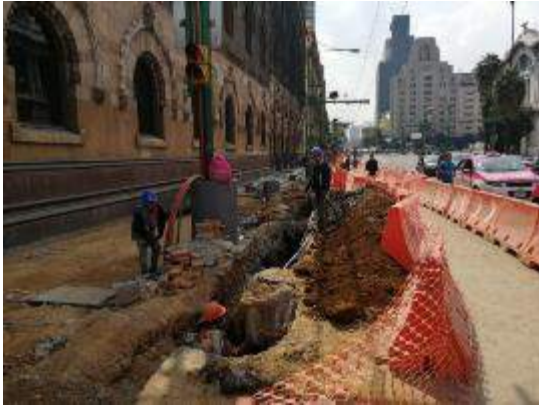
Trabajo de excavación
