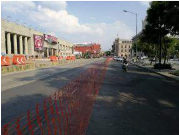
Confinamiento área de trabajo
