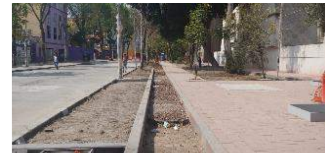
Avance en Calle Violeta
