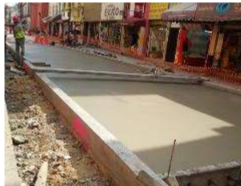
Colado de MR45 en Calle Soledad
