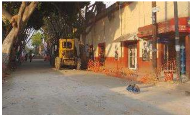
Colado de Relleno Fluido en Galeana Sur
