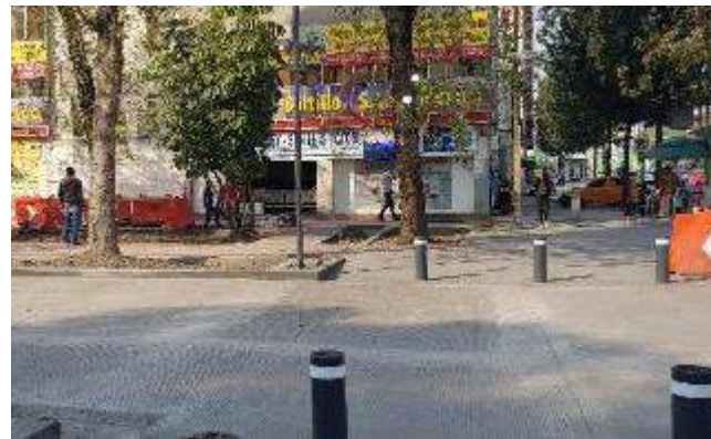
Colocación de Bolardos Calle Violeta y Eje Central
