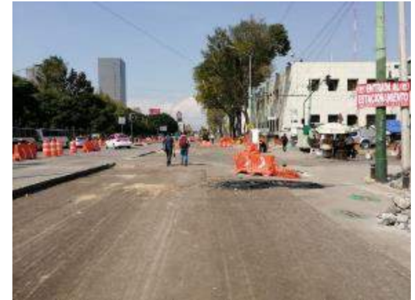
Fresado de carpeta asfáltica
