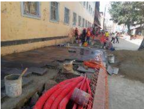
Colocación de recinto en Calle Soledad
