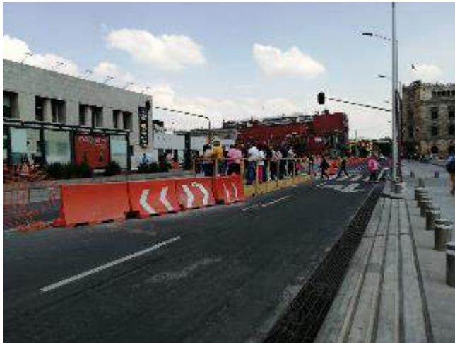
Estación provisional Metrobús Bellas Artes
