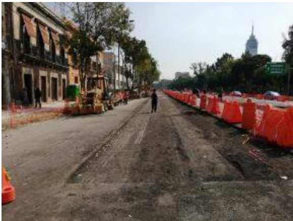
Fresado de carpeta asfáltica
