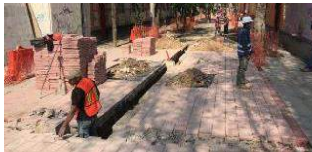
Colocación de recinto en Riva Palacio Norte
