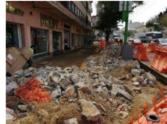
Trabajos de Demolición
