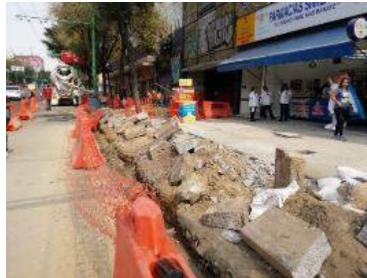
Confinamiento de áreas de trabajo
