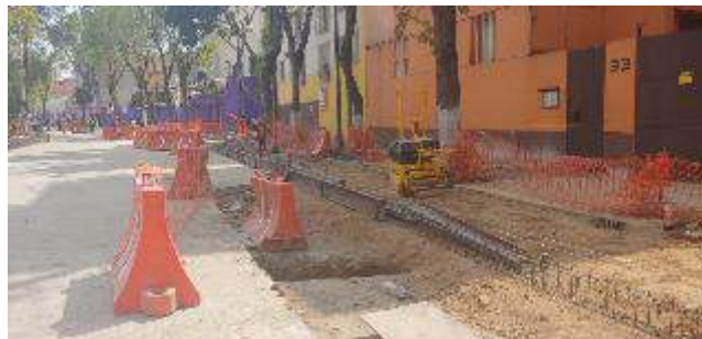
Armado de guarnición en Calle Violeta
