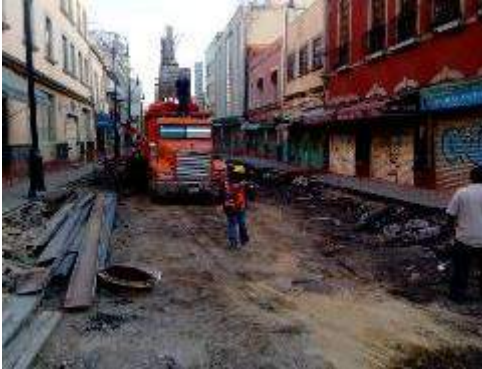
Retiro de residuos de la construcción en Calle Leona Vicario
