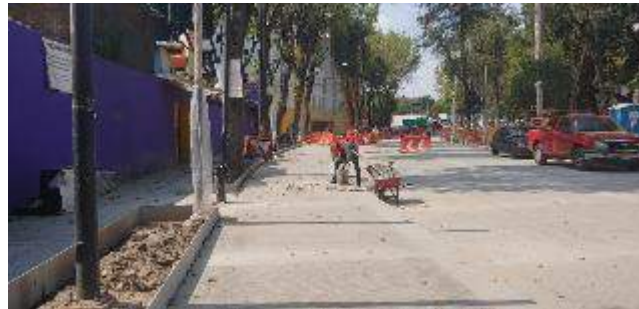
Avance en Calle Violeta
