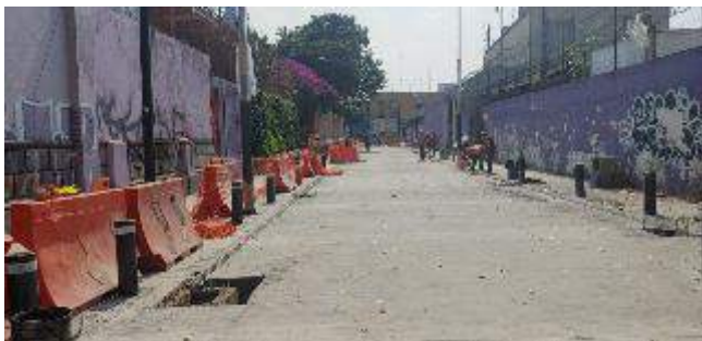
Colocación de bolardo en Riva Palacio Sur
