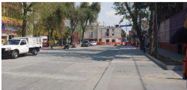
Avance Calle Violeta
