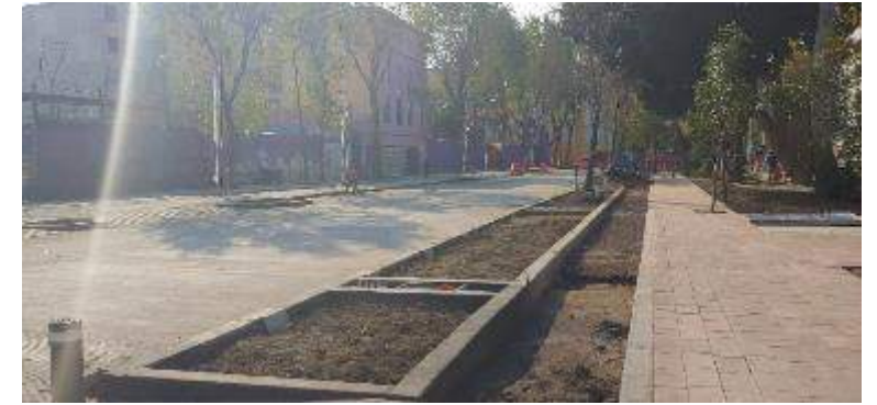
Avance Calle Violeta
