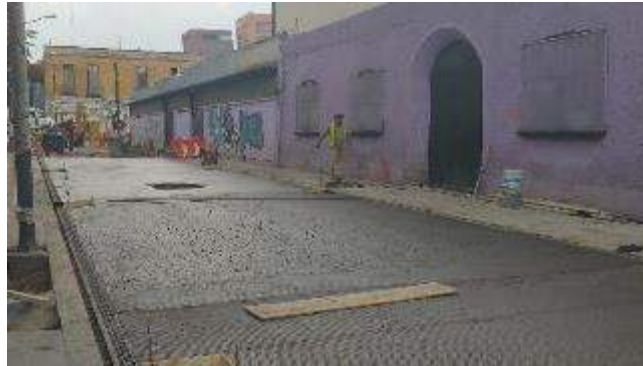
Colado de MR-45 en Riva Palacio Sur
