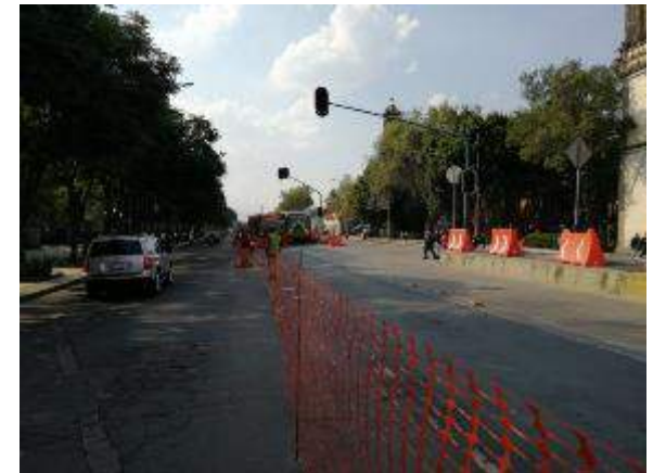
Confinamiento área de trabajo
