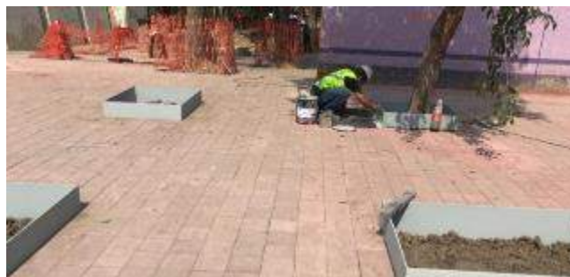
Avance Calle Violeta
