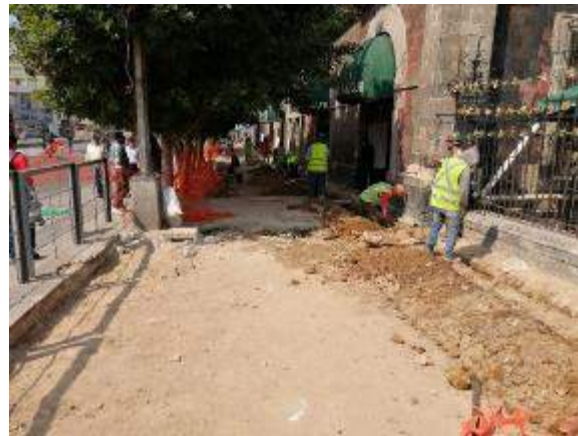
Trabajos de excavación
