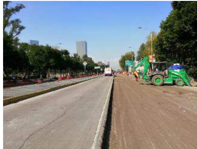
Fresado de carpeta asfáltica
