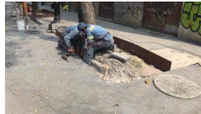
Colocación de placas de jardineras en Valerio Trujano
