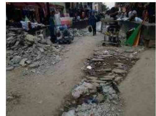
Trabajos de demolición en Calle Santísima
