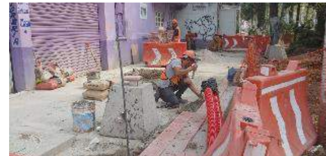
Colocación de recinto en Calle Violeta
