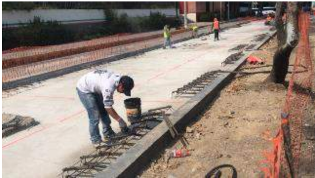
Habilitado de acero para recibir MR45 en Valerio Trujano
