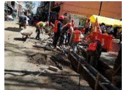
Cimbrado de guarnición en Calle República de Guatemala
