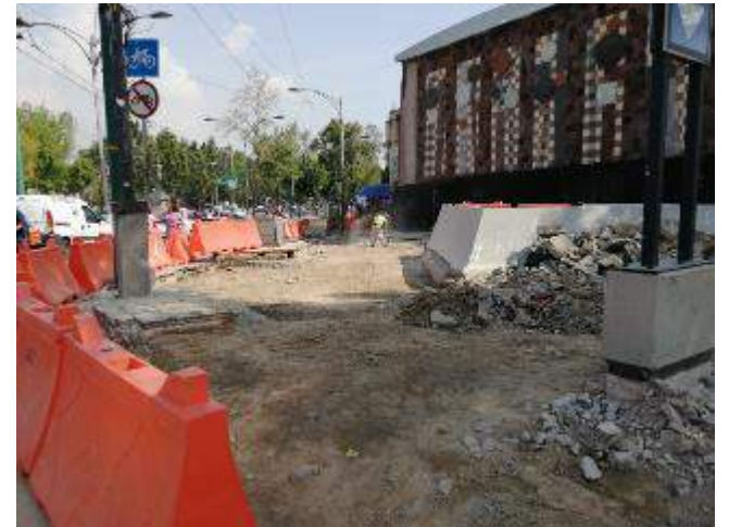
Demolición de banqueta y limpieza de zona de intervención
