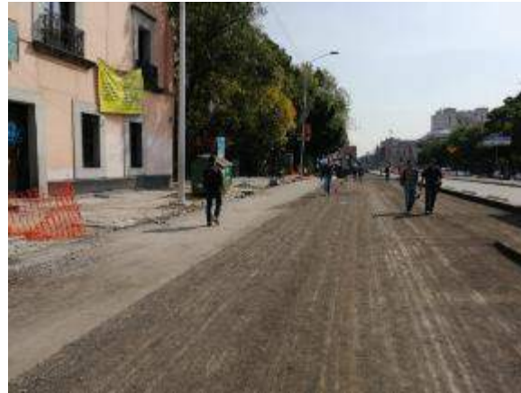
Fresado de carpeta asfáltica
