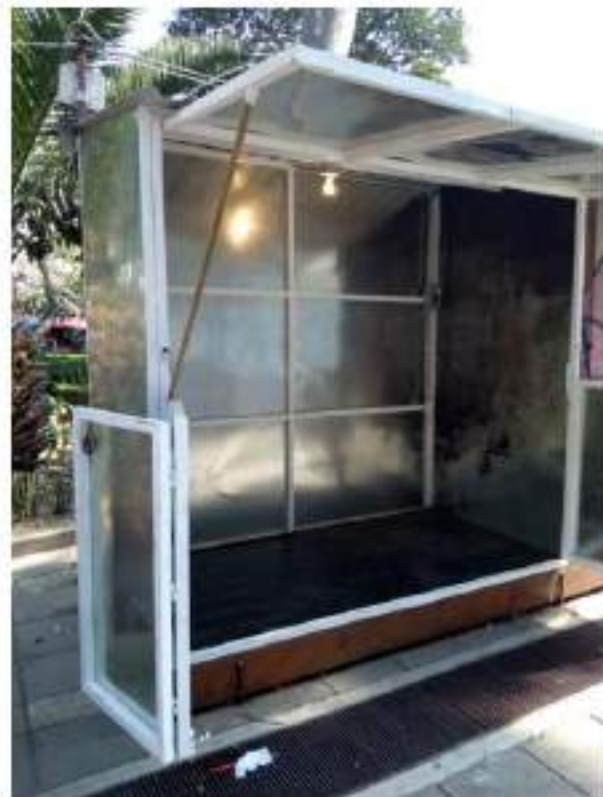
Reparación del local incendiado
