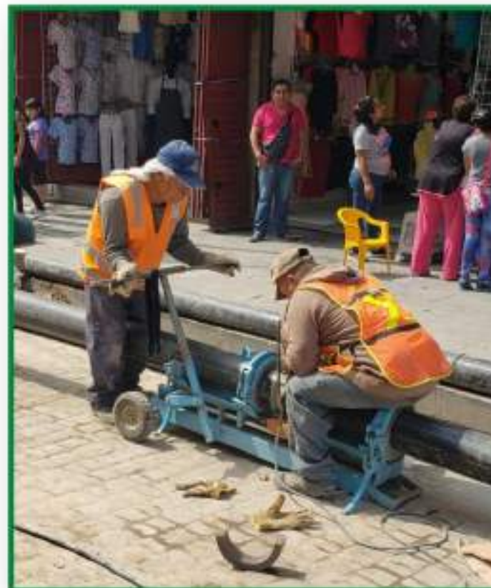
Instalación con perforación direccional
