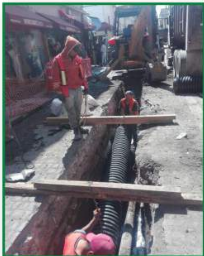
Instalación en zanja a cielo abierto
