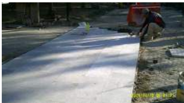
Colocacion de marmol sto. Tomas
