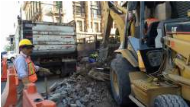
Demolición de banqueta y guarnición
