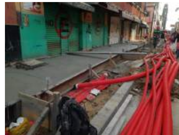
Colocación de Iluminación
