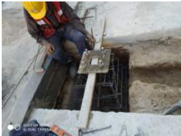
Habilitación de acero para postes en C.Valeriano Trujano
