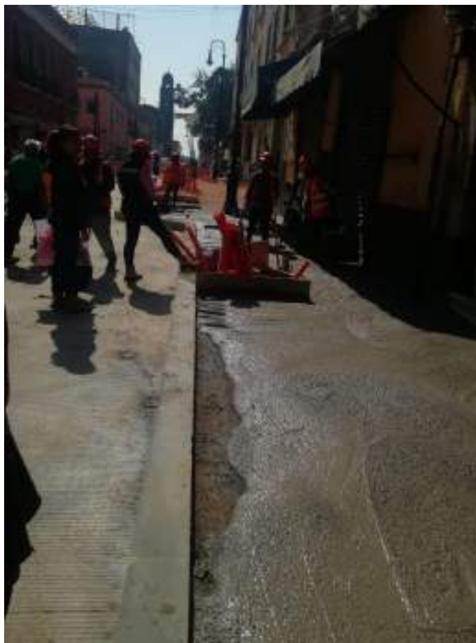
Colado de banquetas
