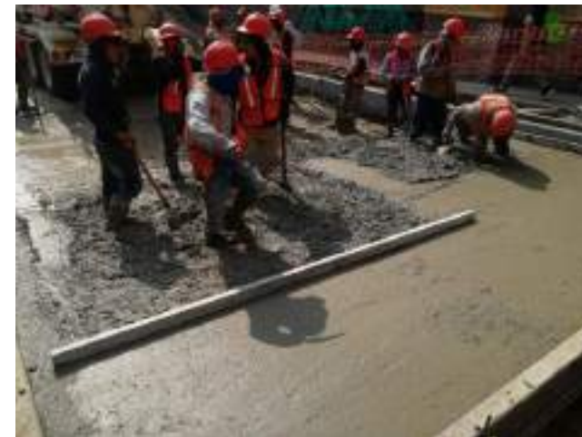
Colado en arroyo vehicular
