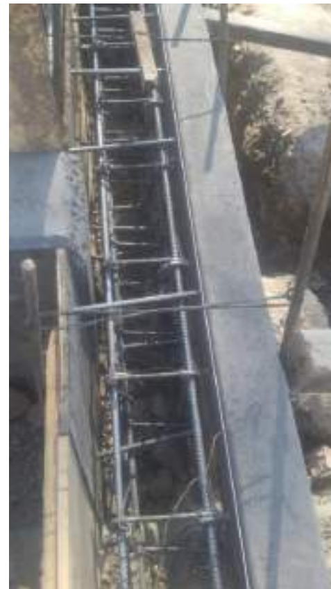
Armado para guarnición
