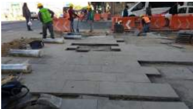
colocación de recinto
