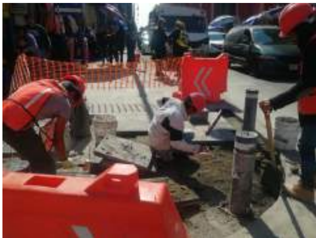
Colocación de recinto en banquetas
