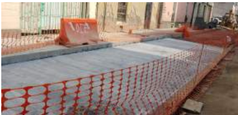
Avance de obra 3er Callejón de San Juan de Dios
