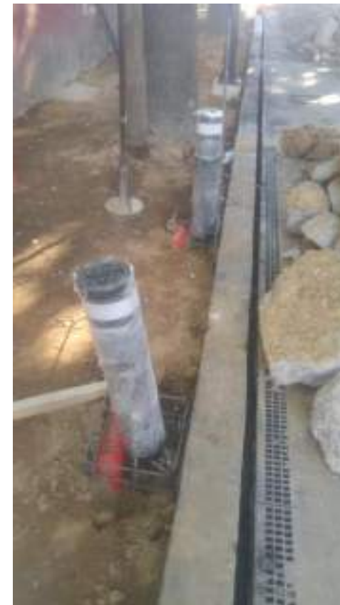
Colocación de bolardos
