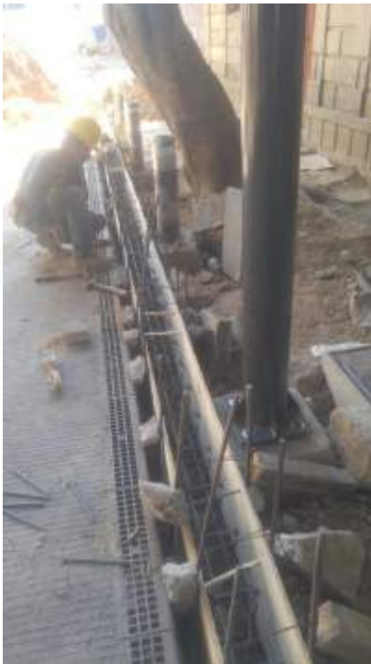
Colocación de posteria alumbrado
