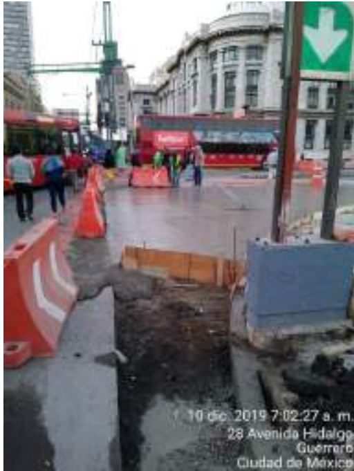
Colocado de relleno fluido en banquetas
