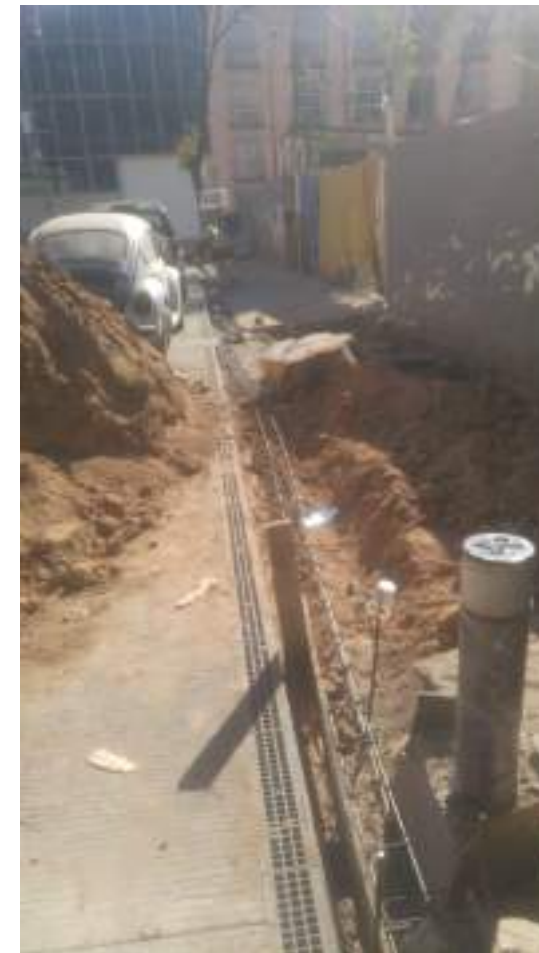
Colocación de guarnición
