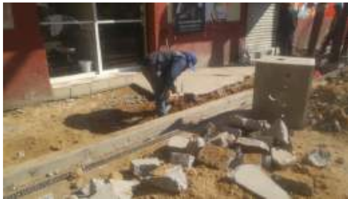
Demolición de banqueta
