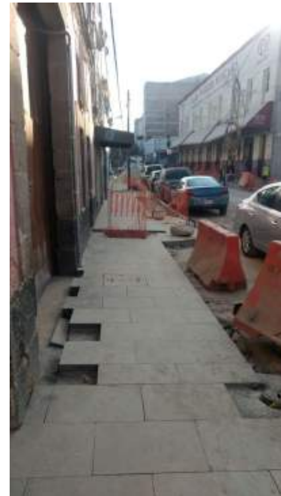
Avance de obra Pensador Mexicano
