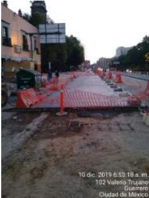
Colado de relleno fluido Valerio Trujano
