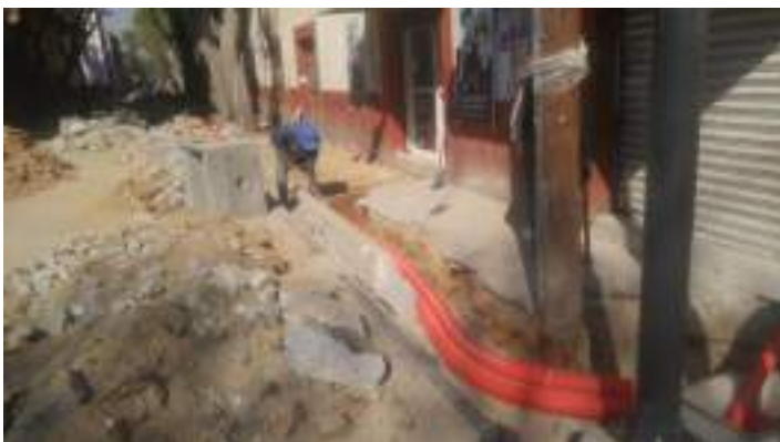
Colocación de precalado terracota
