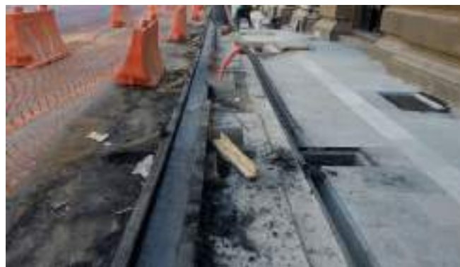
colocación de guarniciones
