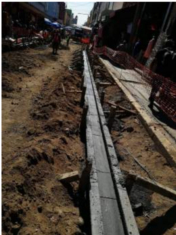
Colado de guarnición
