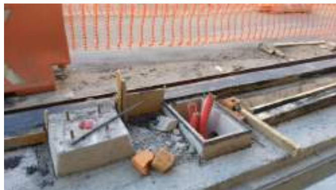
colocación de bases y registros para luminarias
