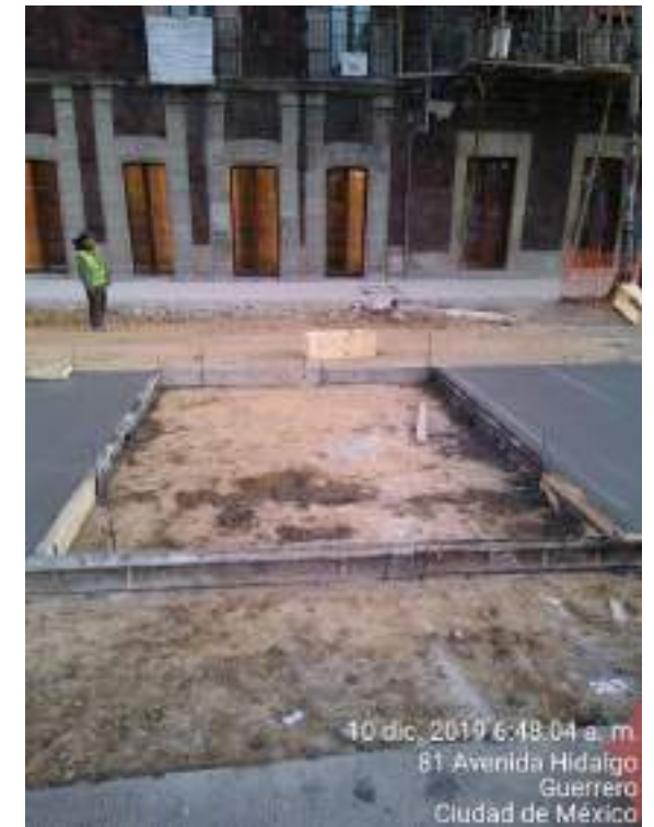
Colocación de recinto en Av Hidalgo
