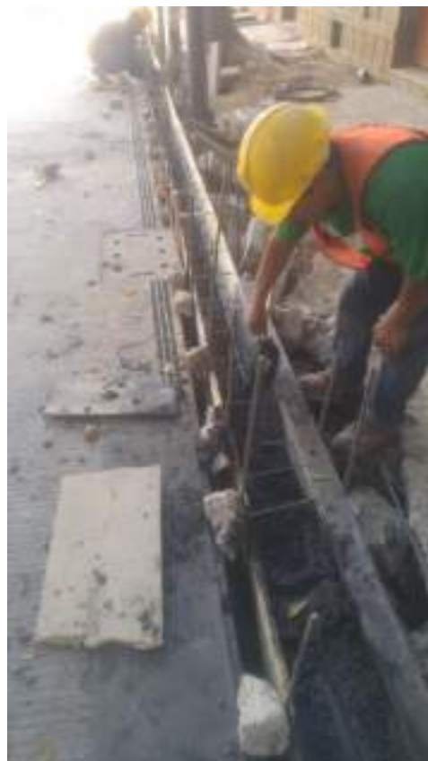
Colado de guarnición
