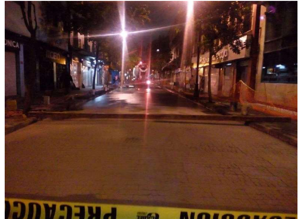
COLADO Y ESTAMPADO DE CONCRETO
