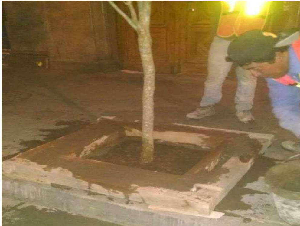
REHABILITACION DE ARRIATES EN LA CALLE DE TACUBA
