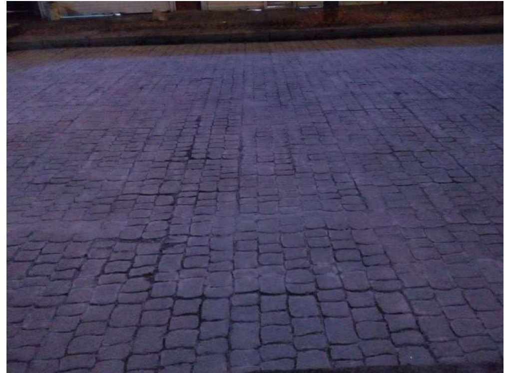
COLADO Y ESTAMPADO DE CONCRETO
