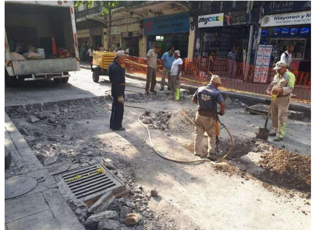
REPARACIONES DE SACMEX
