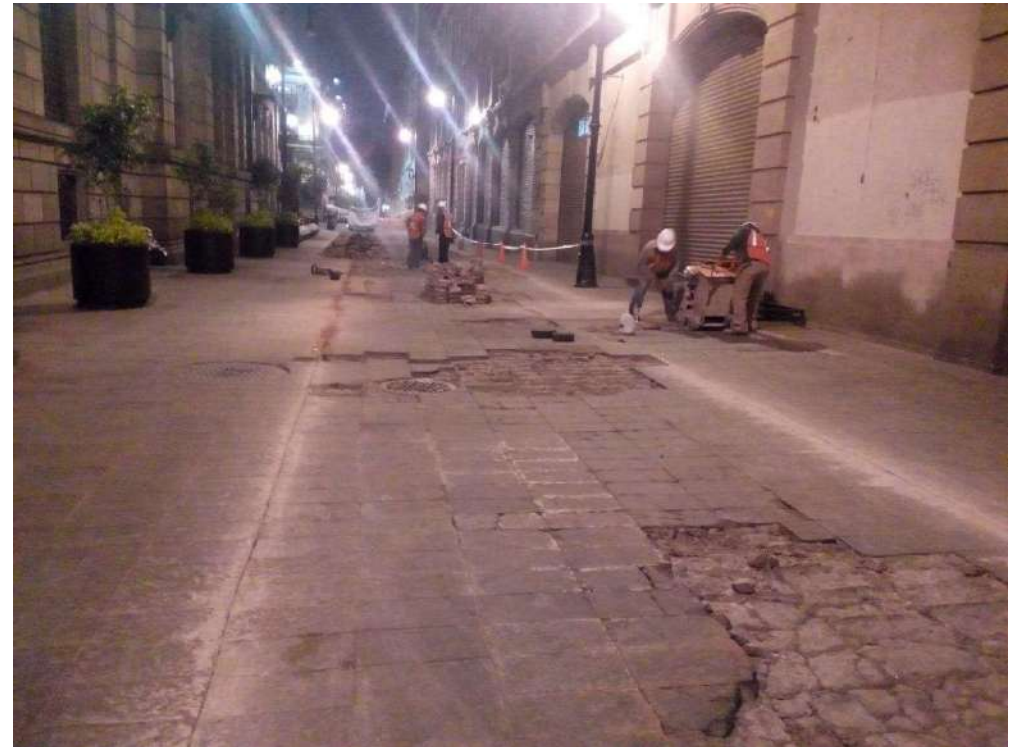
DEMOLICION DE PISO DE CANTERA
